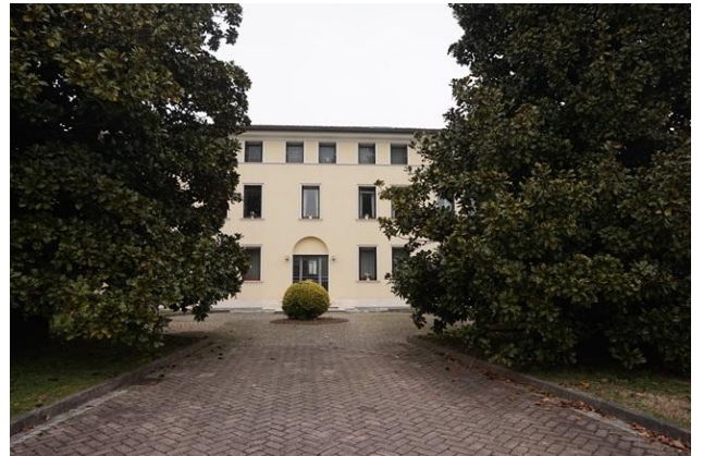
Fronte sud fabbricato principale e cortile comune
