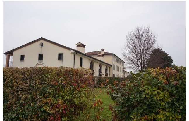
Vista fronte ovest fabbricato principale
