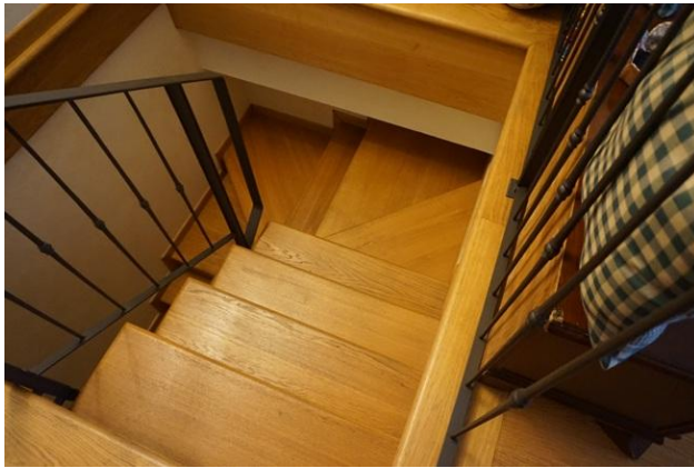
Piano Terra – Scala interna accesso piano interrato
