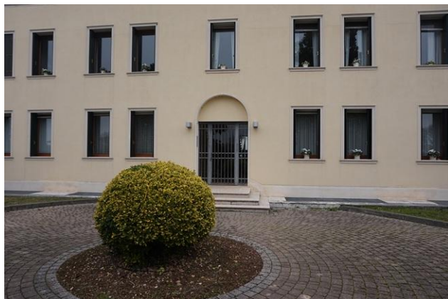
Particolare ingresso comune a sud
