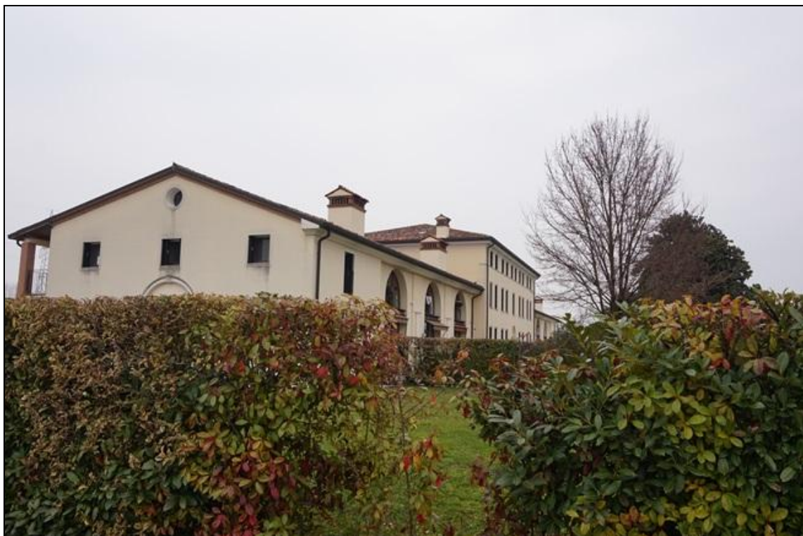
FOTO 8 – Vista fronte ovest fabbricato principale
