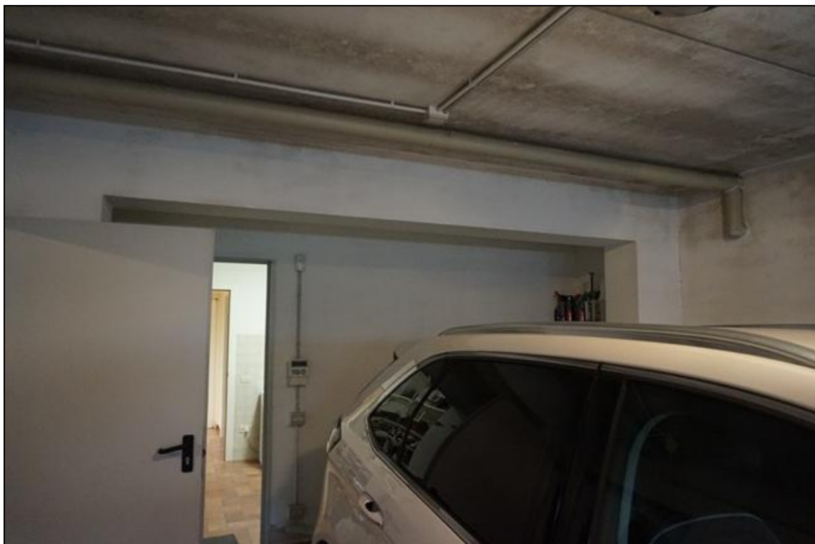
FOTO 36 – Piano interrato – Garage sub.45 con accesso da lavanderia
