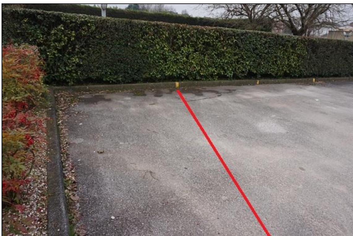
FOTO 42 – Piano terra – Posto auto sub.20 (a sx)
