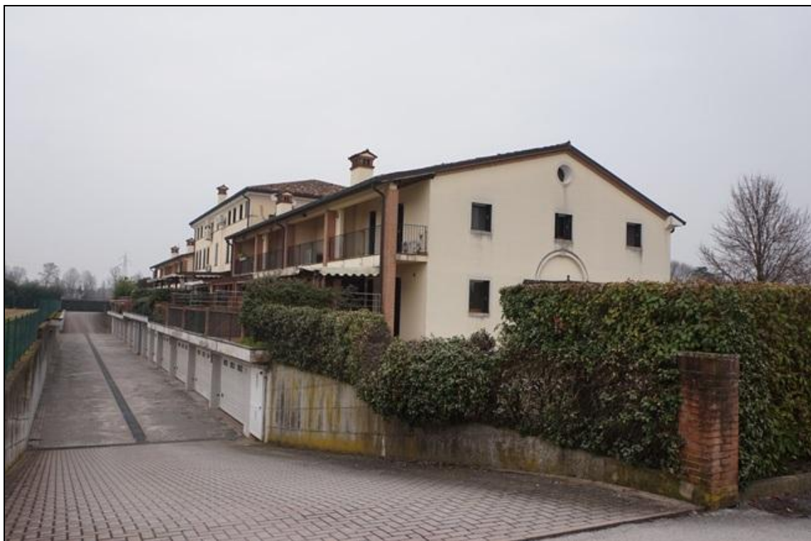
FOTO 9 – Vista fronti ovest e nord e corsia accesso carraio
