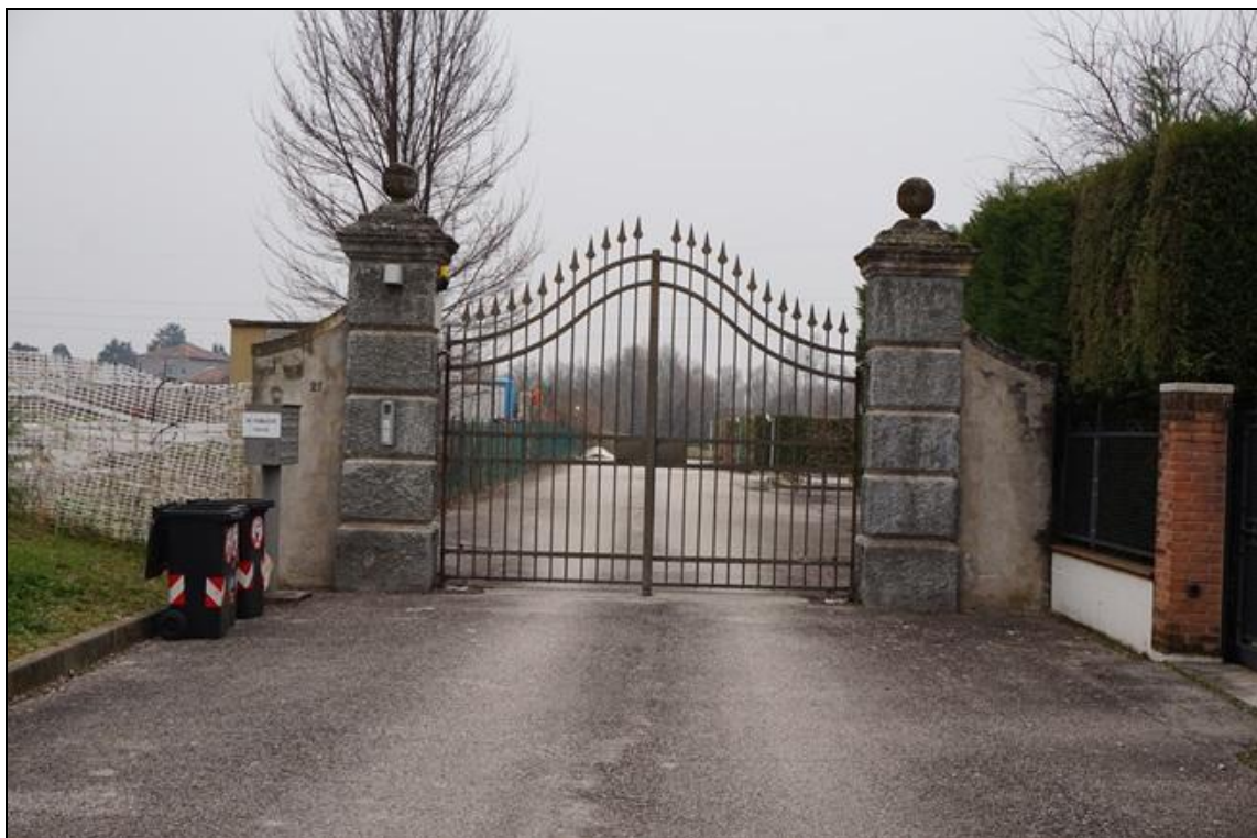
FOTO 1 – Ingresso principale complesso residenziale a ovest
