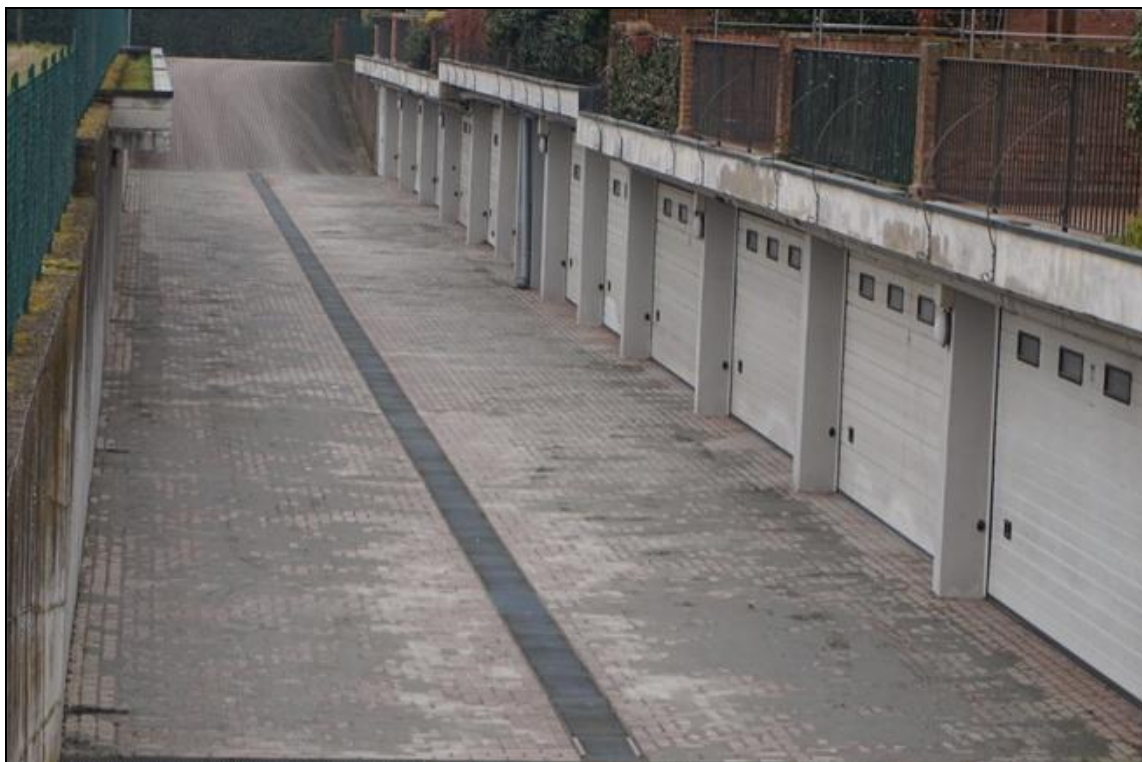
FOTO 35 – Piano interrato – Corsia comune accesso garage
