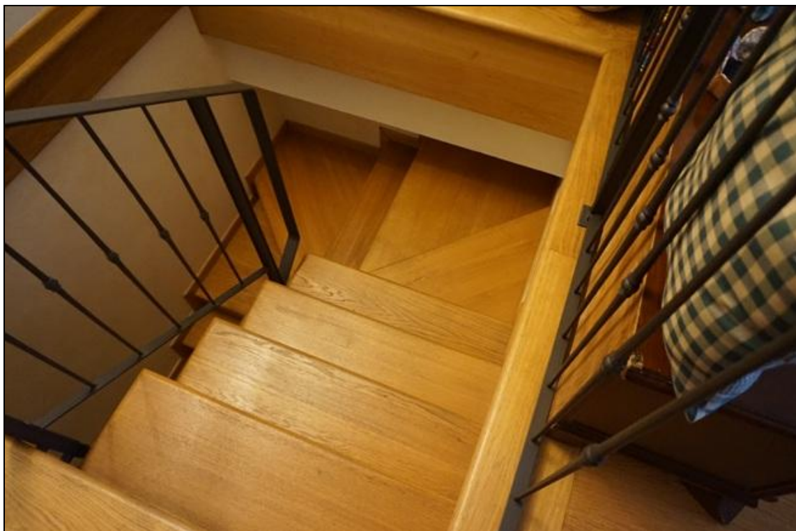
FOTO 27 – Piano Terra – Scala interna accesso piano interrato
