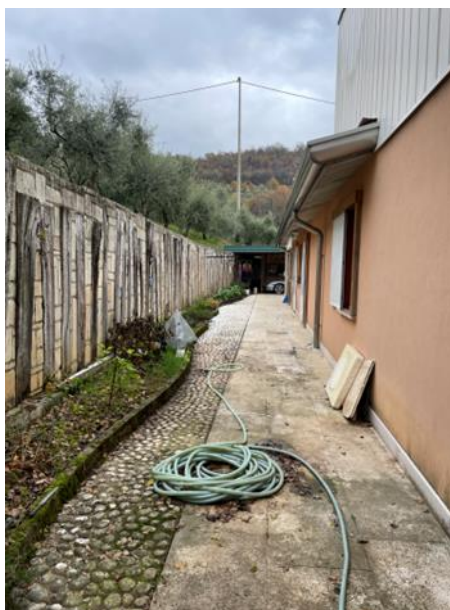
vista fabbricato lato ovest
