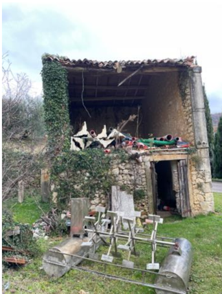
vista ovest deposito
