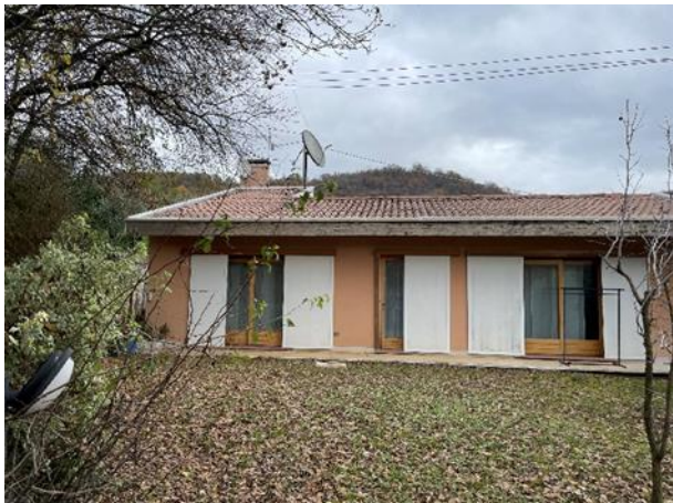
vista est dal confine con altra proprietà
