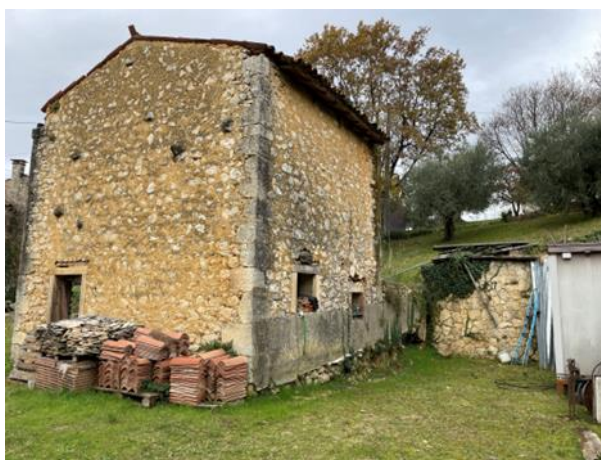
vista deposito lato nord-est
