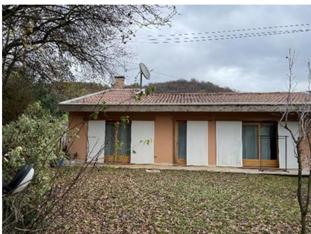
vista est dal confine con altra proprietà
