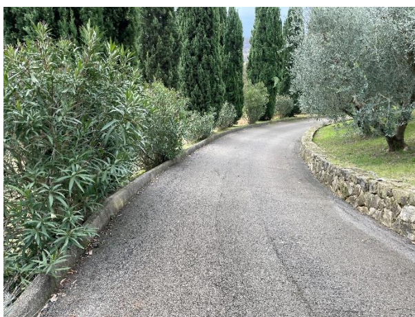
vista p.lla 196-620: strada privata di accesso
