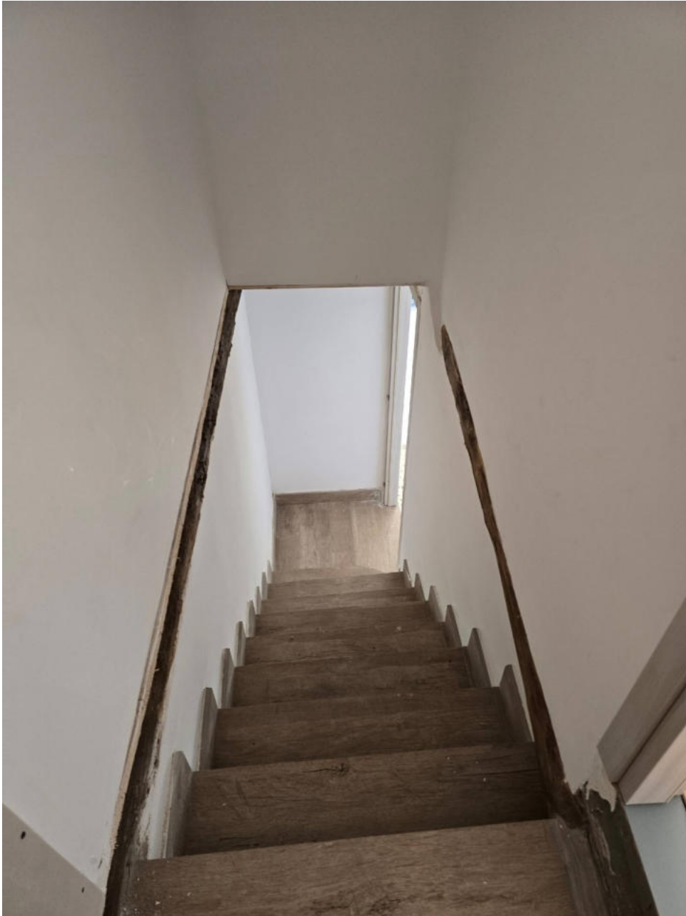
Foto 3: Vista scala di collegamento
