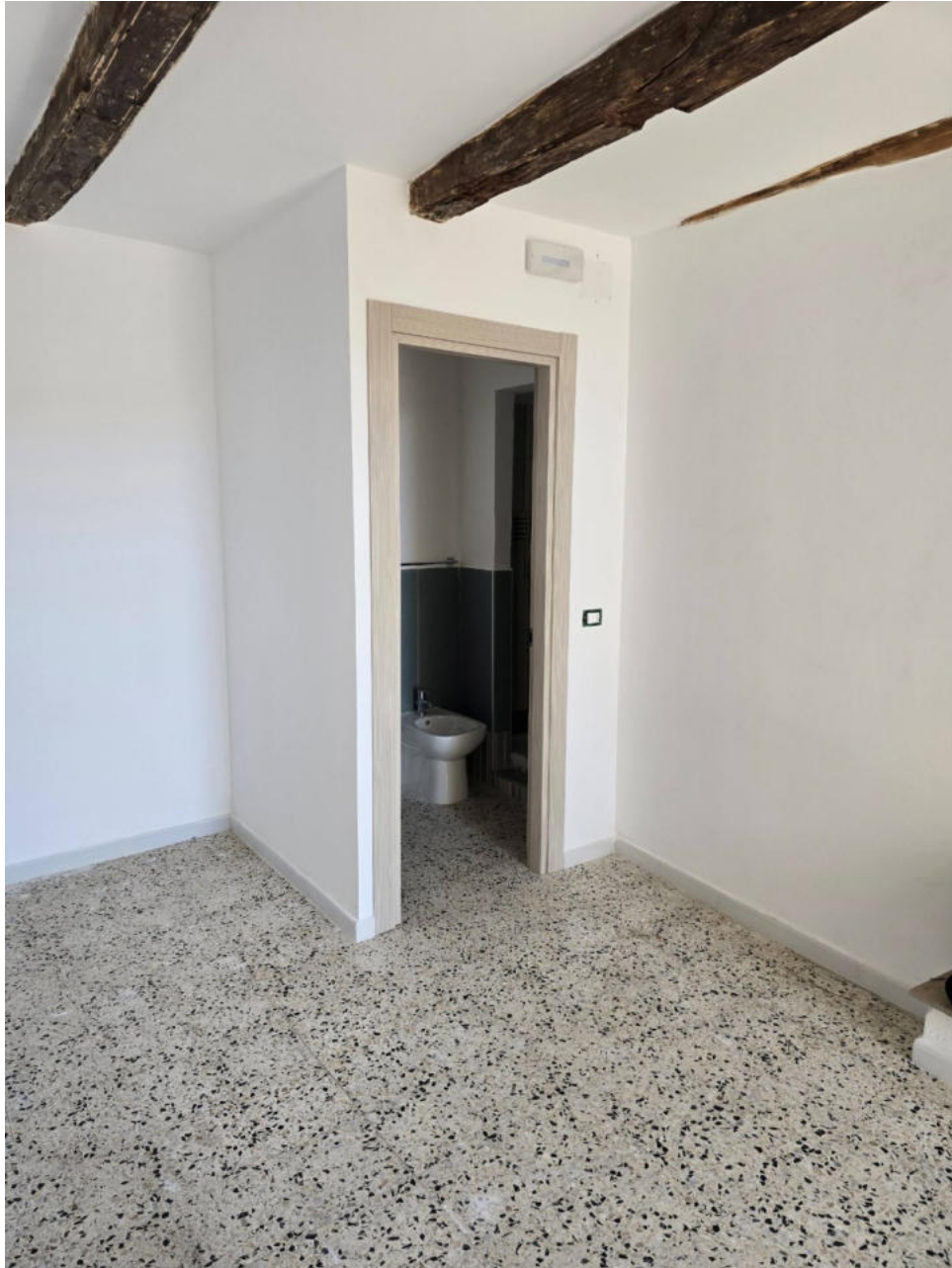
Foto 2: vista vano piano terra con wc
