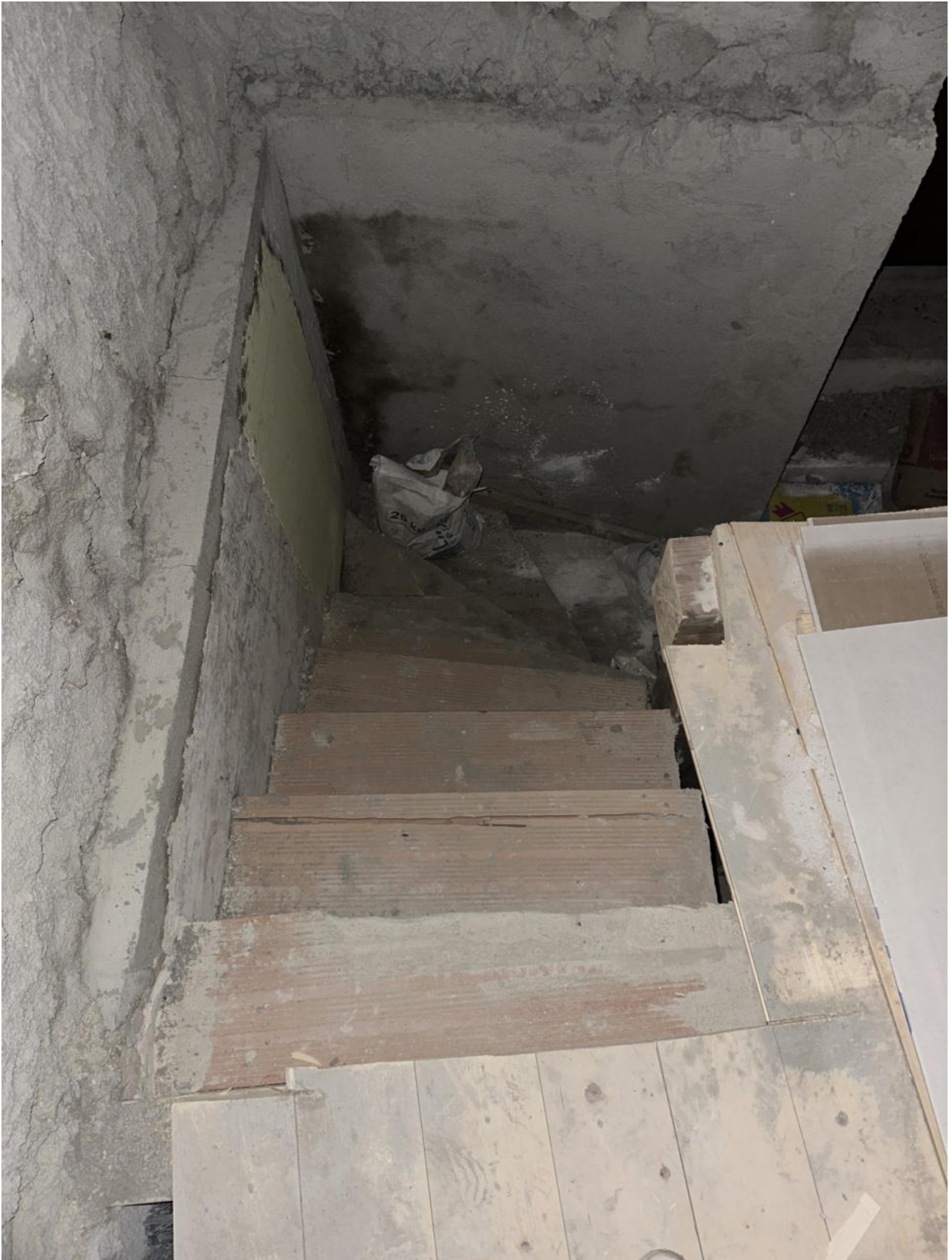
Foto 9: Vista scala vano piano terra
