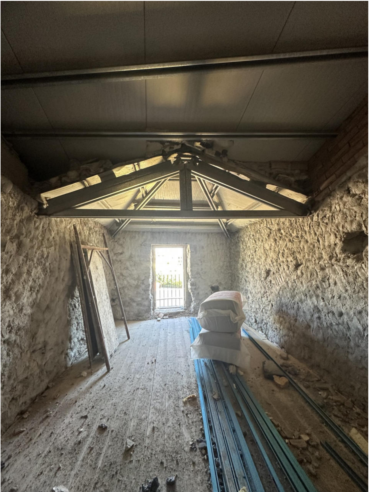
Foto 12: Vista secondo vano piano primo
