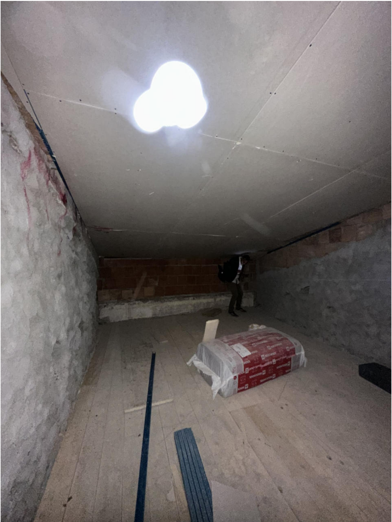
Foto 11: Vista vano soffitta piano primo
