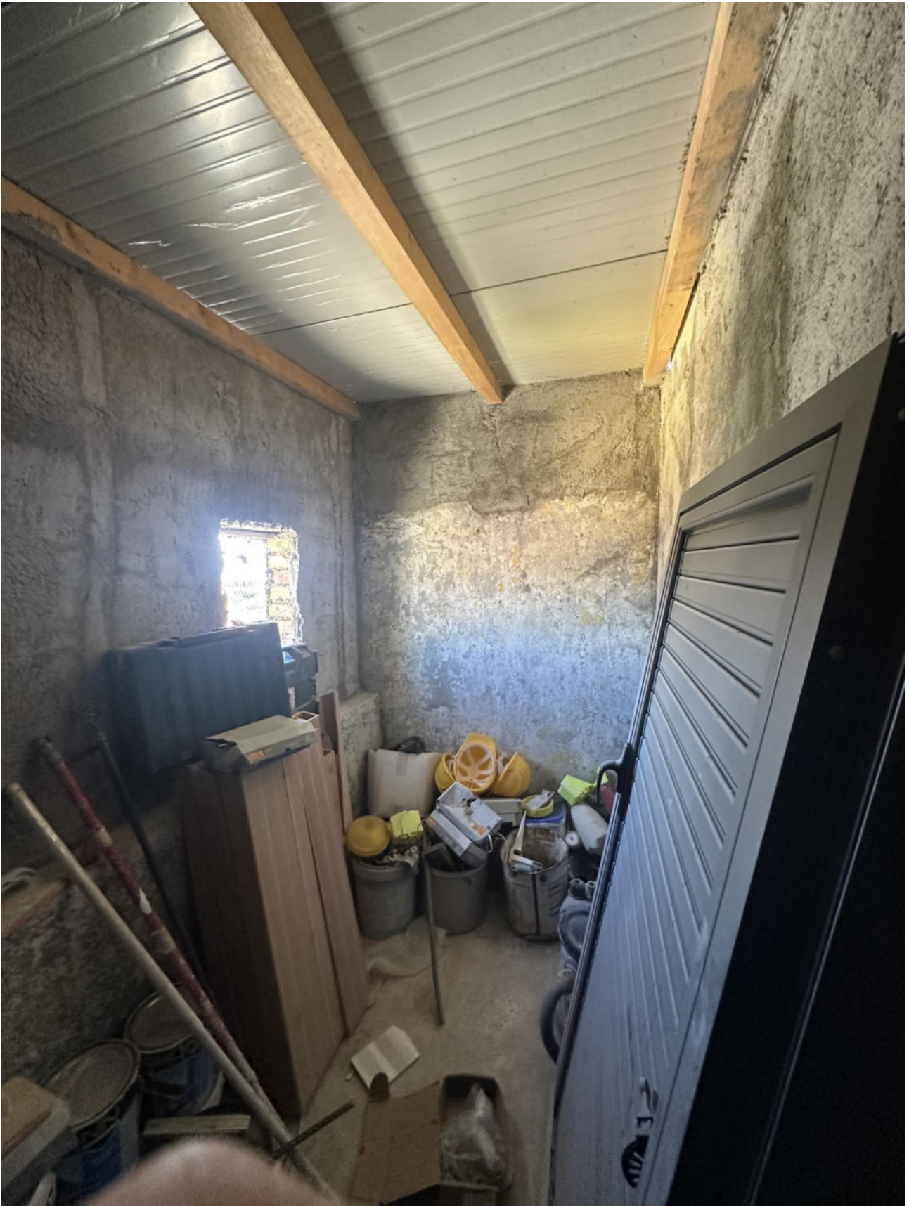
Foto 8: Vista balcone esterno coperto
