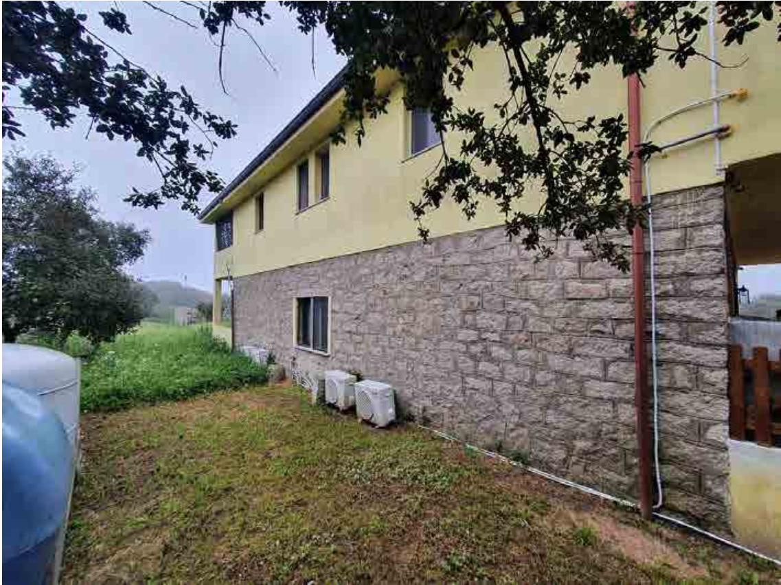
VISTA SUD-OVEST FABBRICATO
