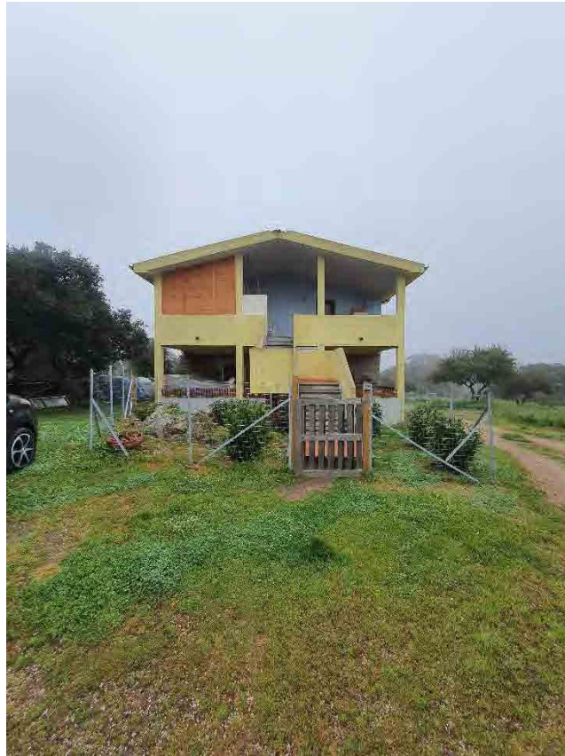
VISTA SUD FABBRICATO
