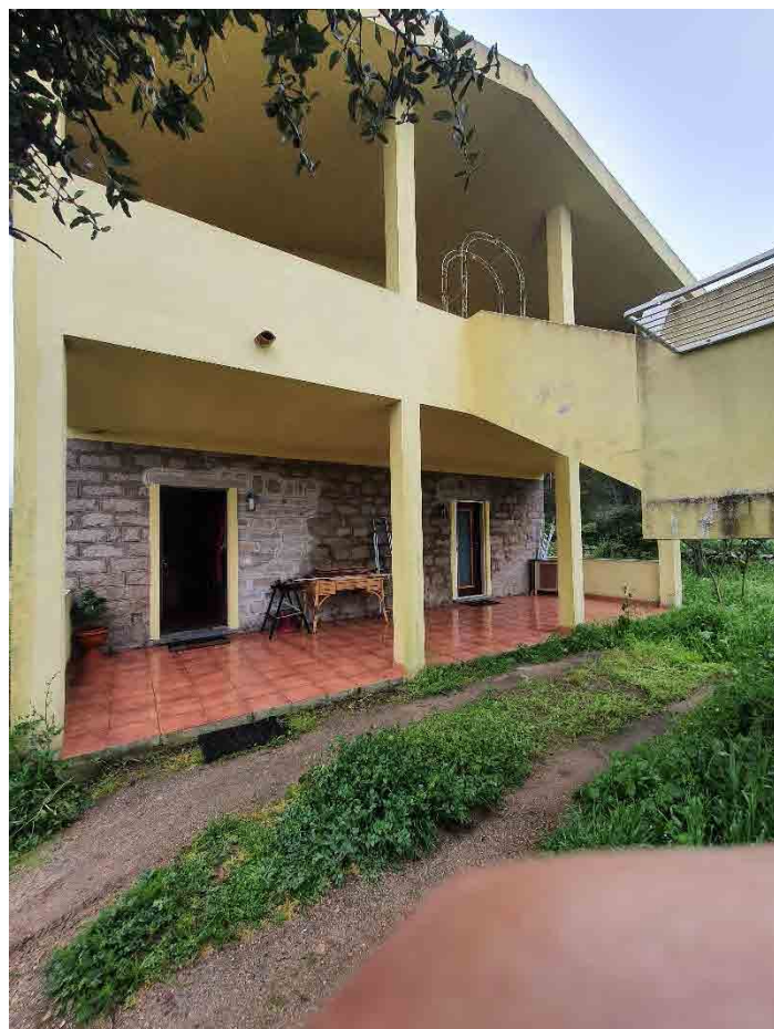
VISTA NORD FABBRICATO
