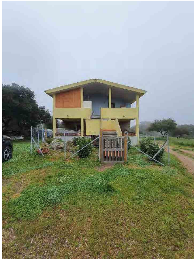
VISTA SUD FABBRICATO
