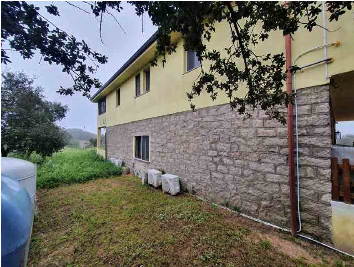
VISTA SUD-OVEST FABBRICATO
