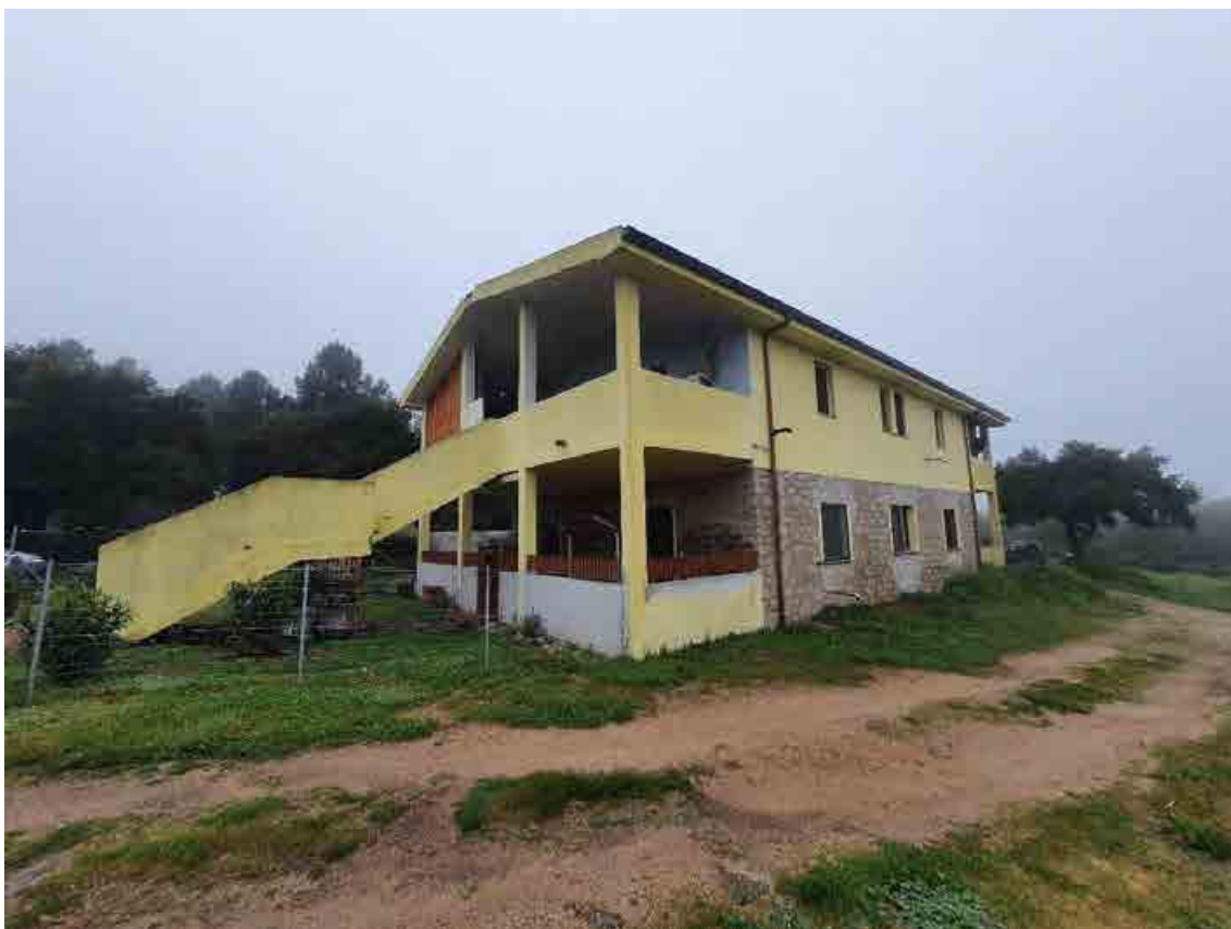
VISTA SUD-EST FABBRICATO
