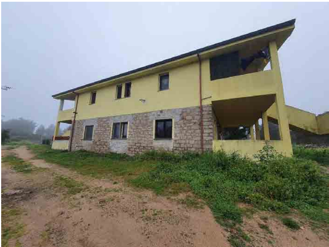
VISTA OVEST FABBRICATO
