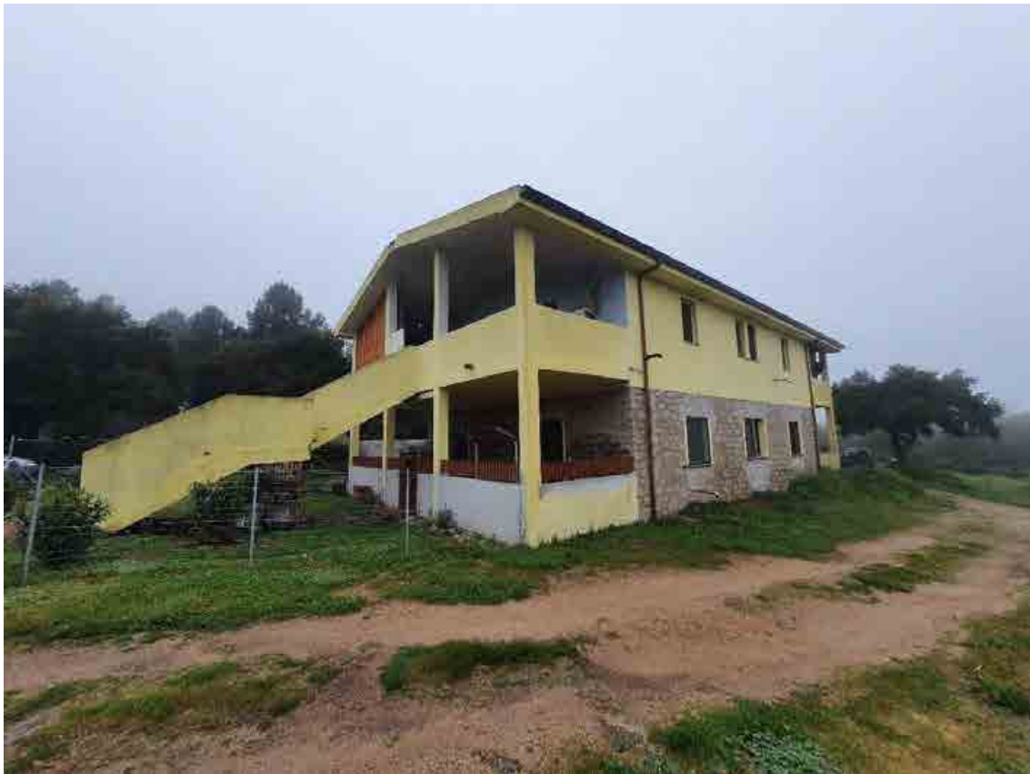
VISTA SUD-EST FABBRICATO
