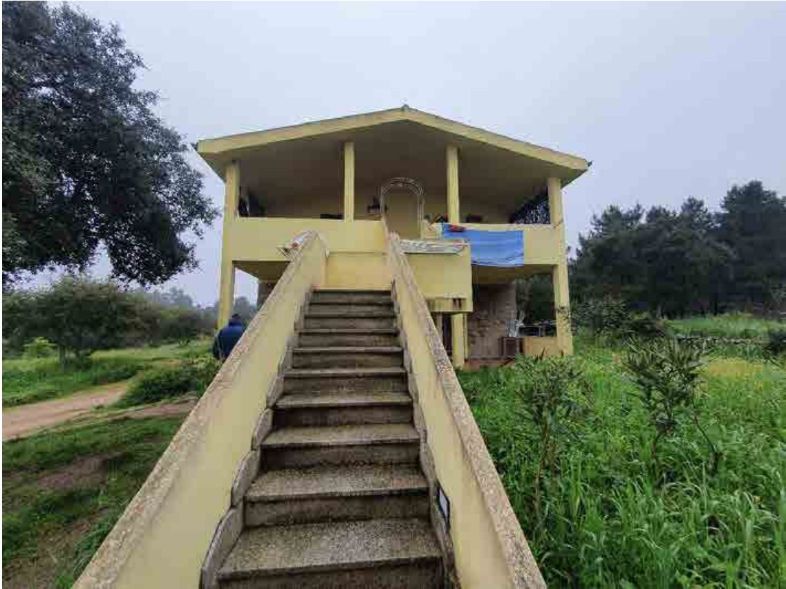
VISTA NORD FABBRICATO
