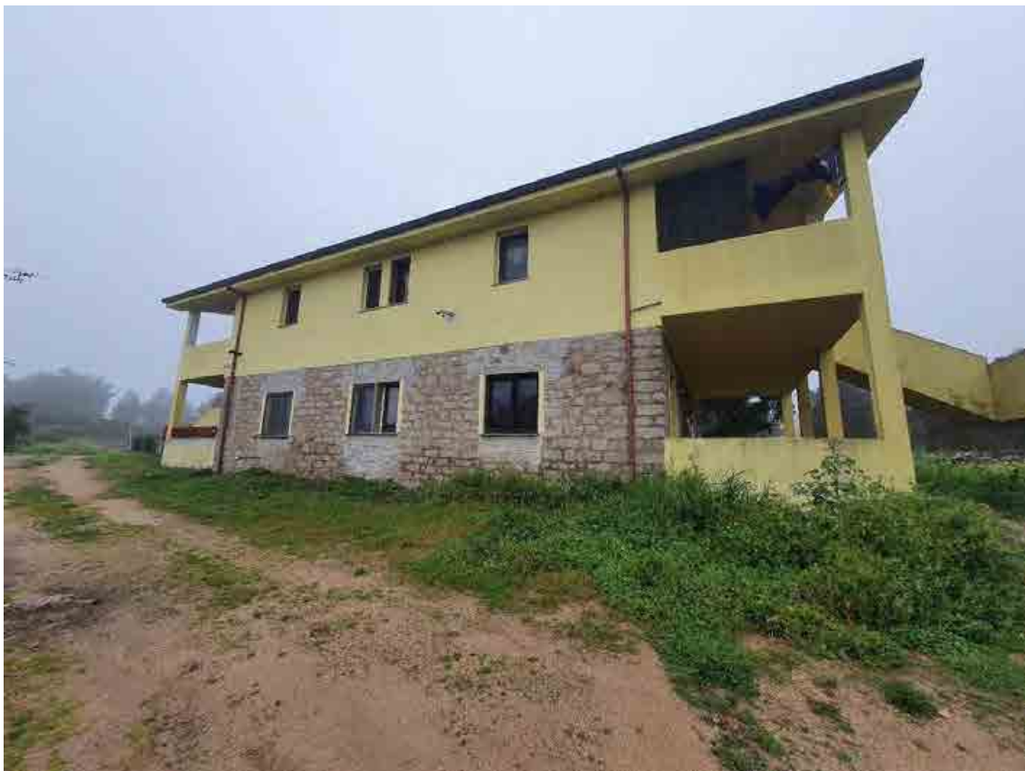
VISTA OVEST FABBRICATO
