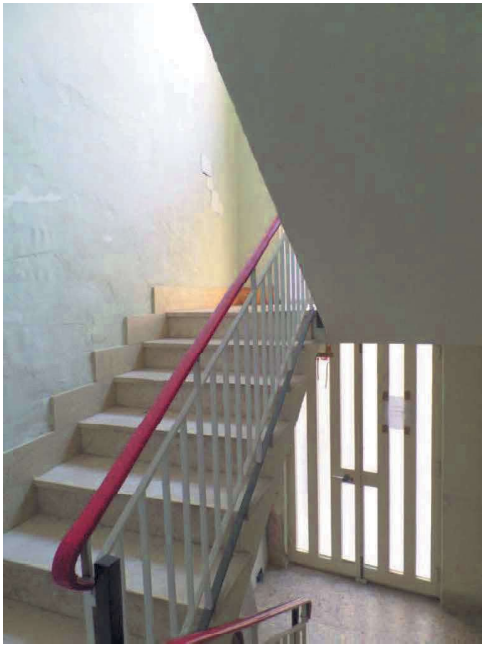
Foto n° 5. Vano scala: ingresso
