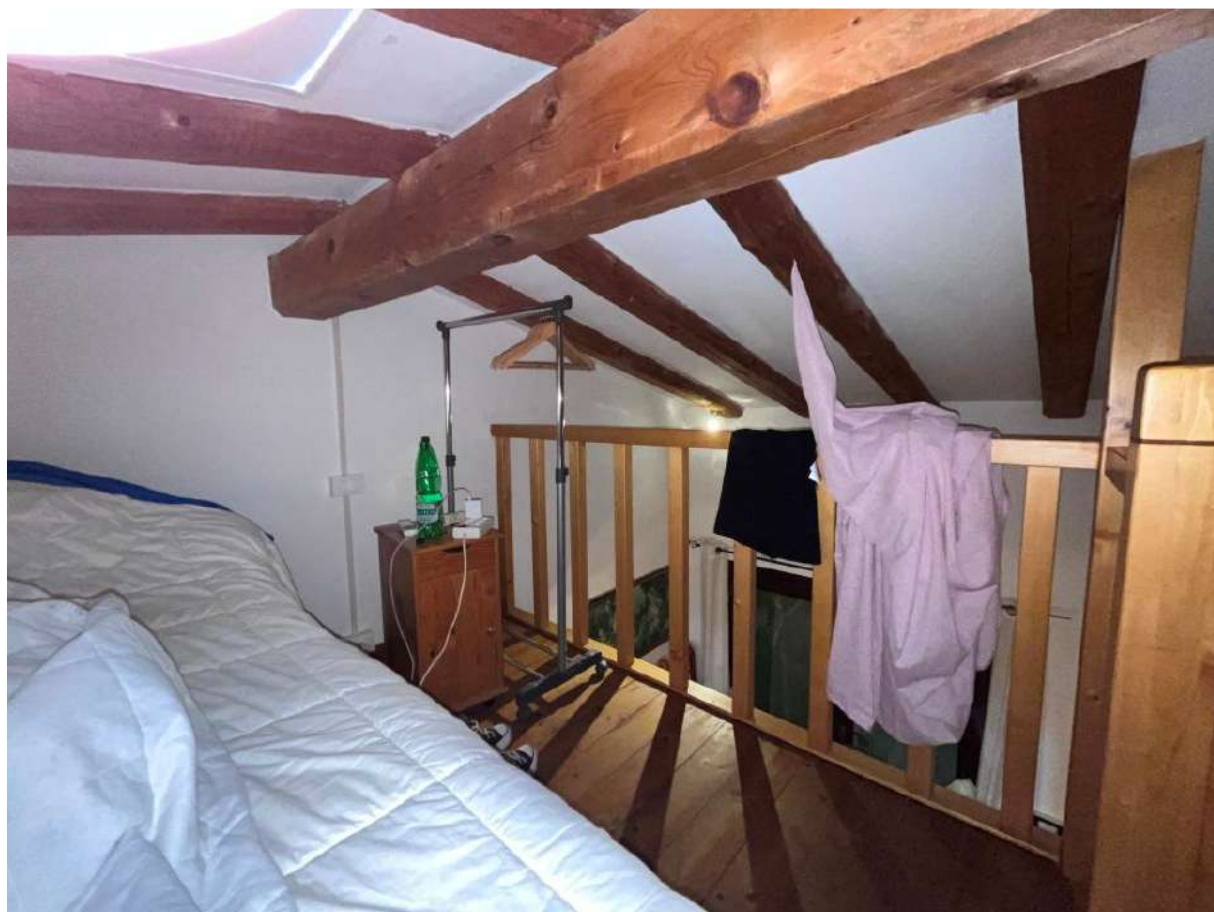
Deposito (allestito a zona notte)
