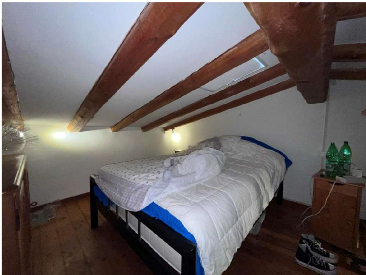
Deposito (allestito a zona notte)
