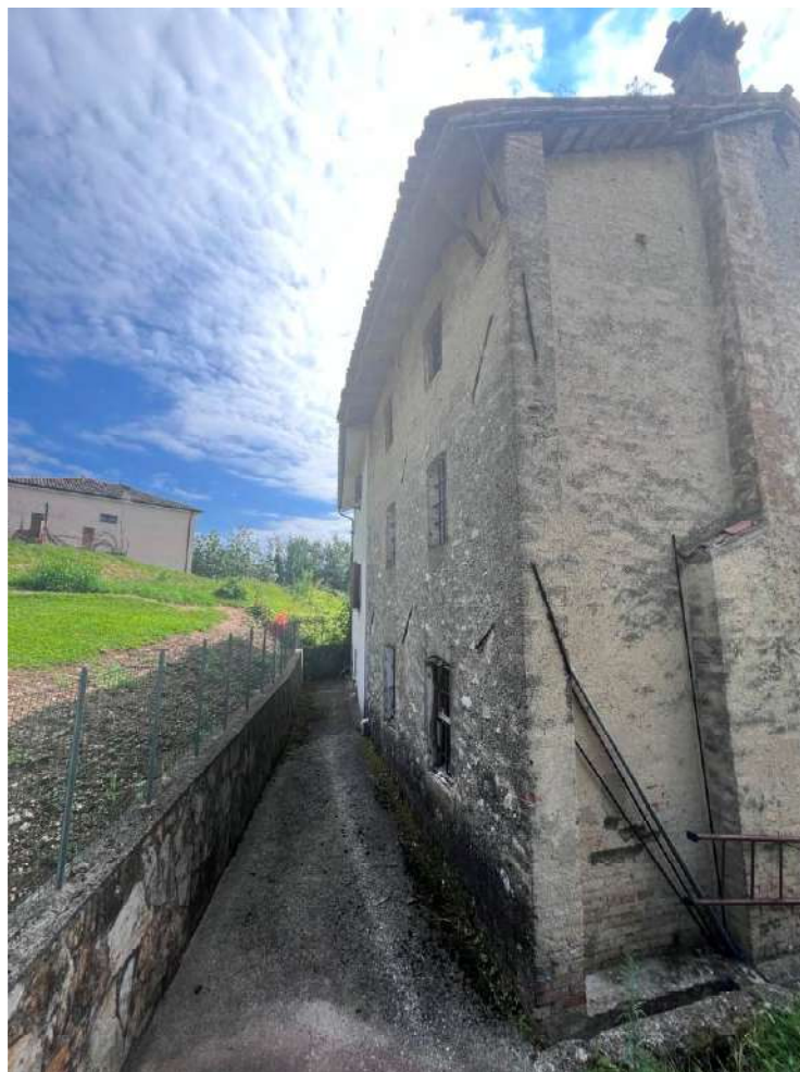
Fronte Nord – camminamento verso Est
