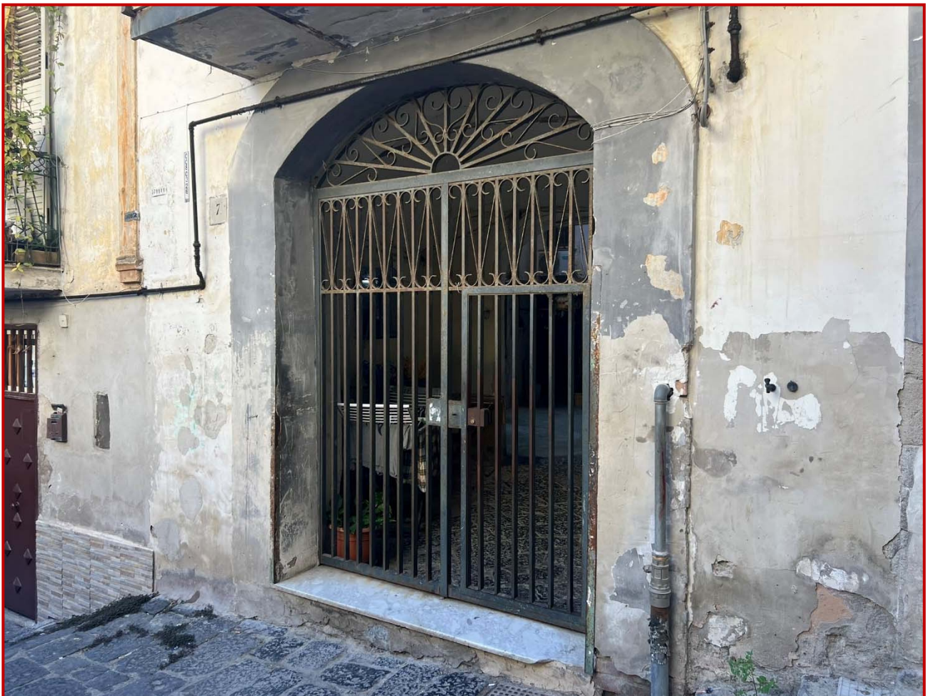
Vista del portone di ingresso del fabbricato
