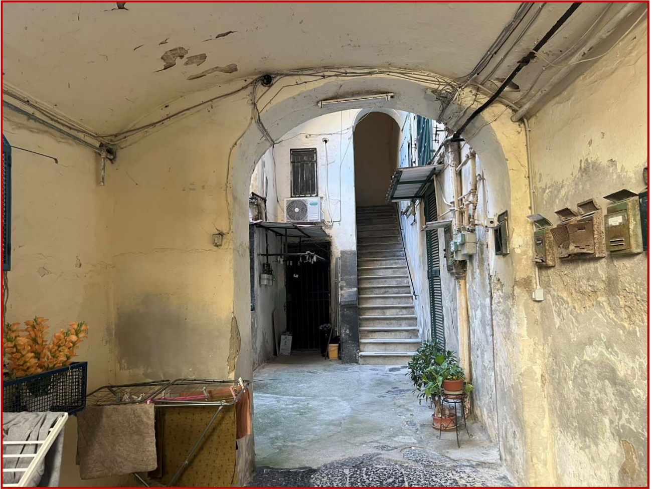
Vista di porzione del cortile interno del fabbricato e dell'imbocco della scala comune
