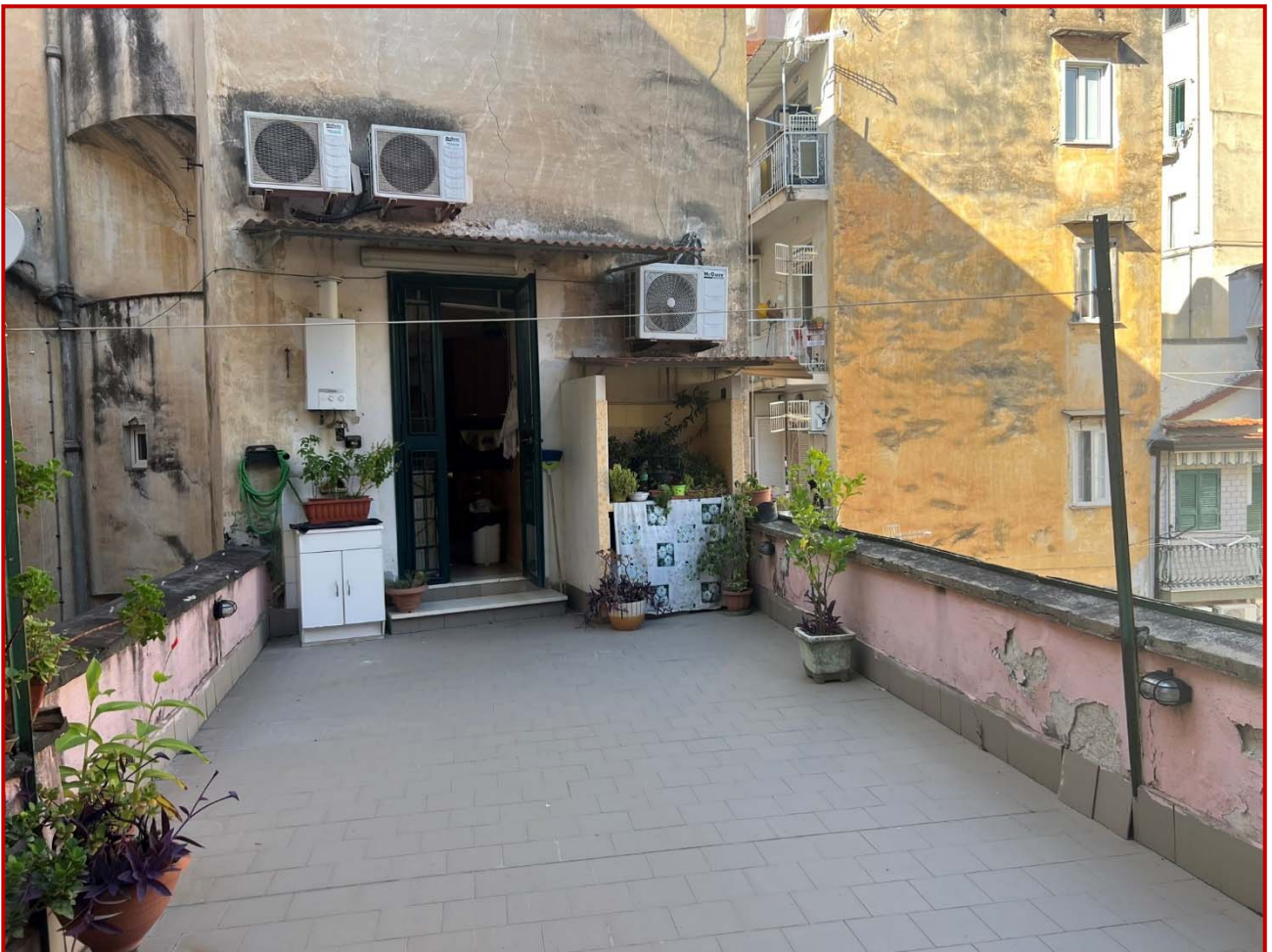
Vista del terrazzo a livello con accesso dalla cucina
