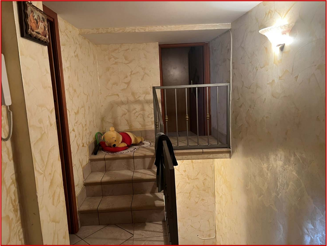
Vista della piccola rampa che conduce dal ballatoio del soppalco alla vetusta camera/deposito
