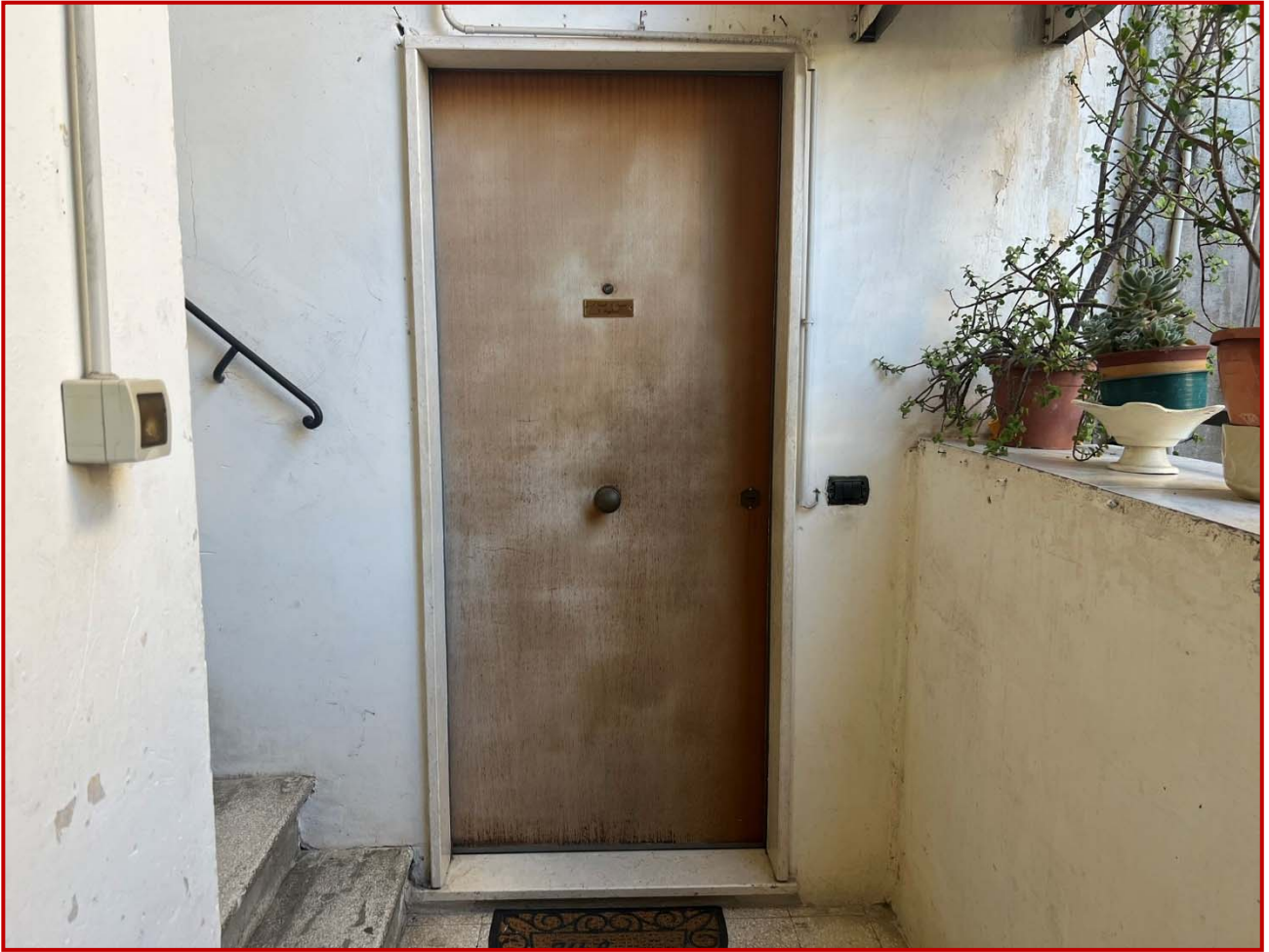
Vista della porta di caposcala dell'appartamento staggito
