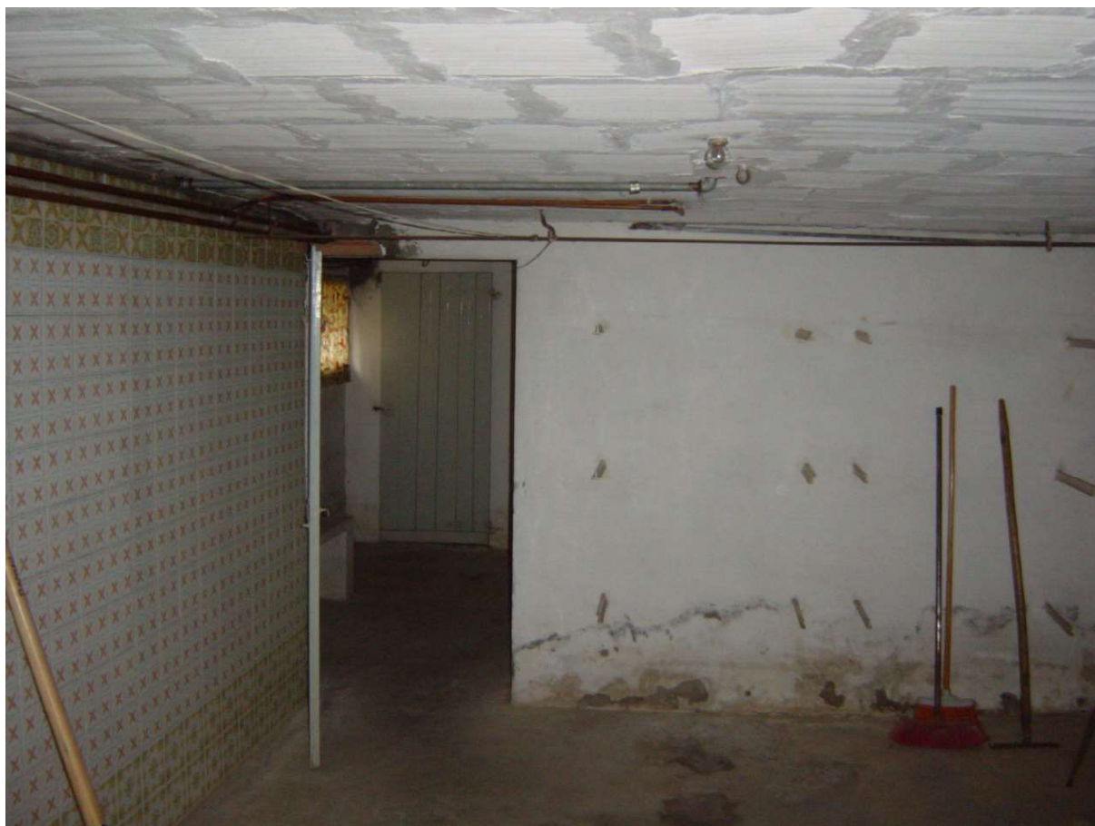
FOTO 12 INTERNO ABITAZIONE PT
