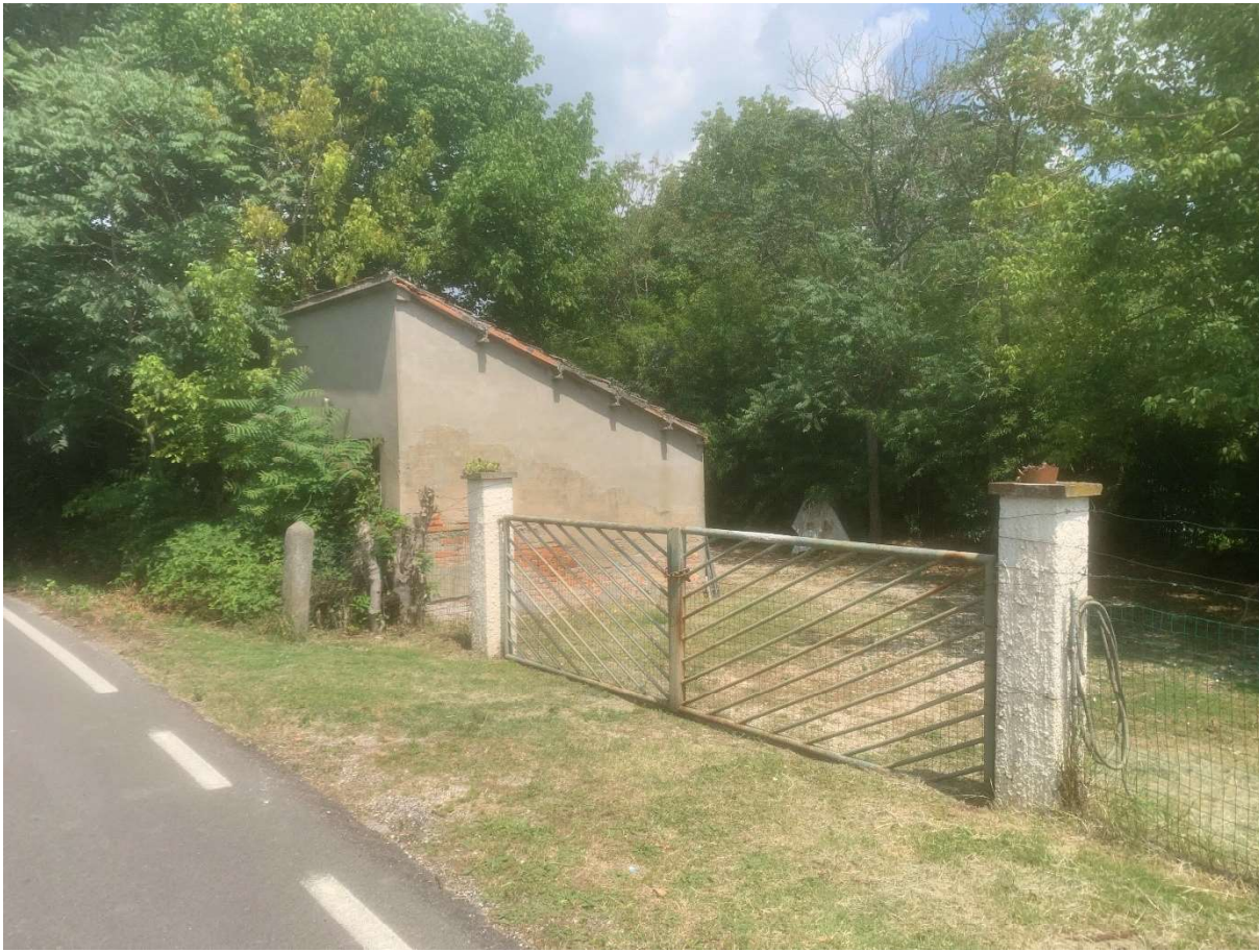
FOTO 1 VIA BASSA ZONA GARAGE
