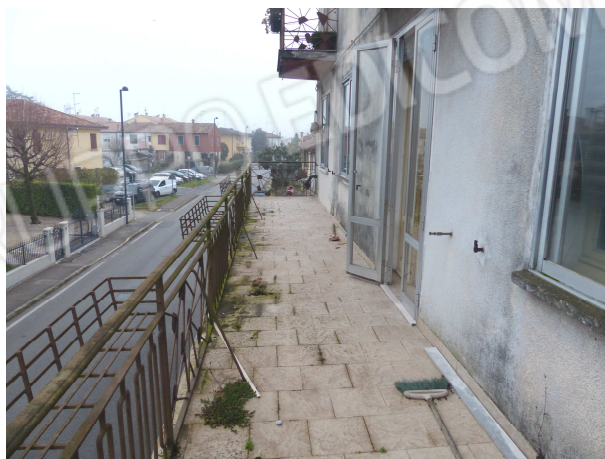
Foto 14 – Poggiolo fronte strada
