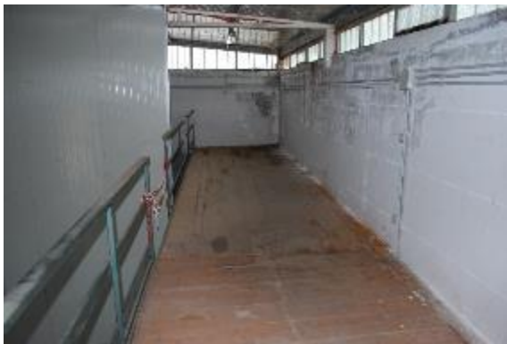
Foto 89 – LOTTO 3- piano ammezzato
