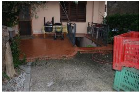
Foto 56 – LOTTO 2- scala di accesso cantina
