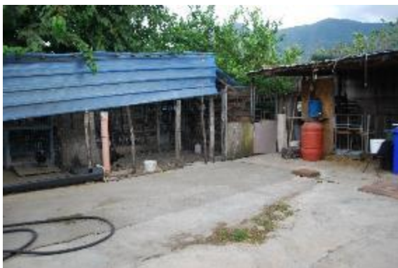
Foto 122 – LOTTO 4- tettoie area nord-est
