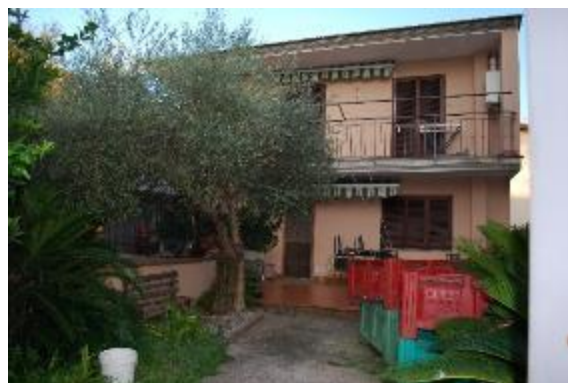
Foto 54– LOTTO 2- area esterna
