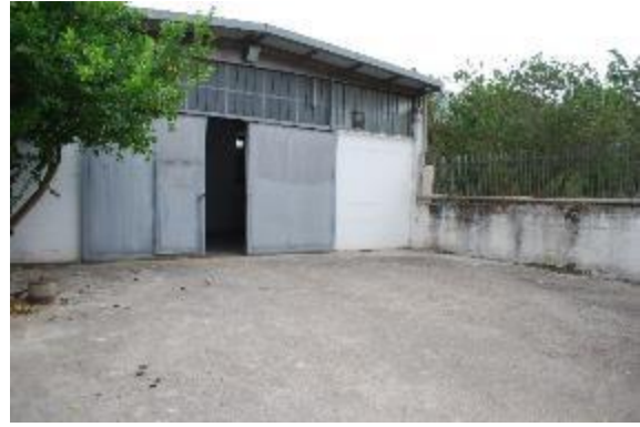
Foto 80- LOTTO 3- area esterna
