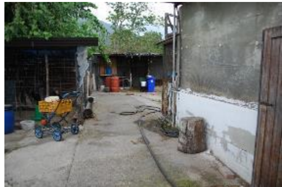
Foto 121 – LOTTO 4- tettoie area nord-est
