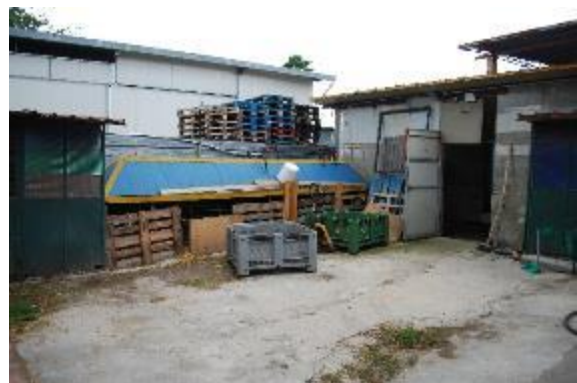
Foto 123 – LOTTO 4- tettoie area nord-est
