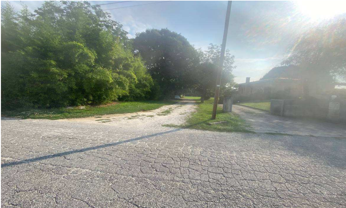
VISTA ESTERNA ACCESSO DA VIA BASSE
