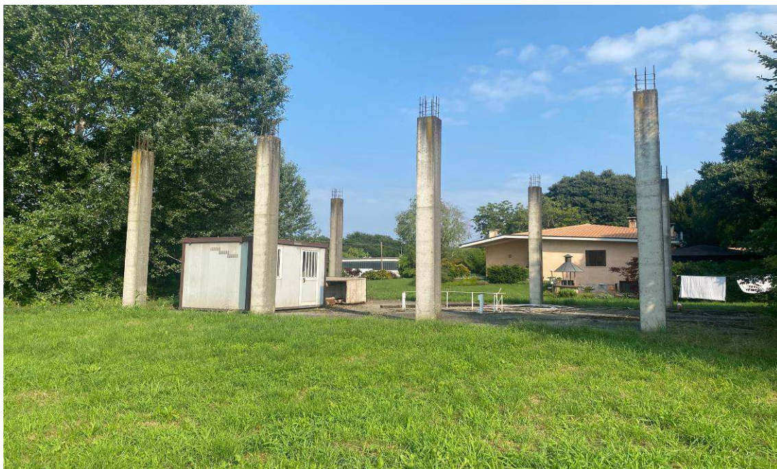
VISTA ESTERNA SCHELETRO ANNESSO RISTICO
