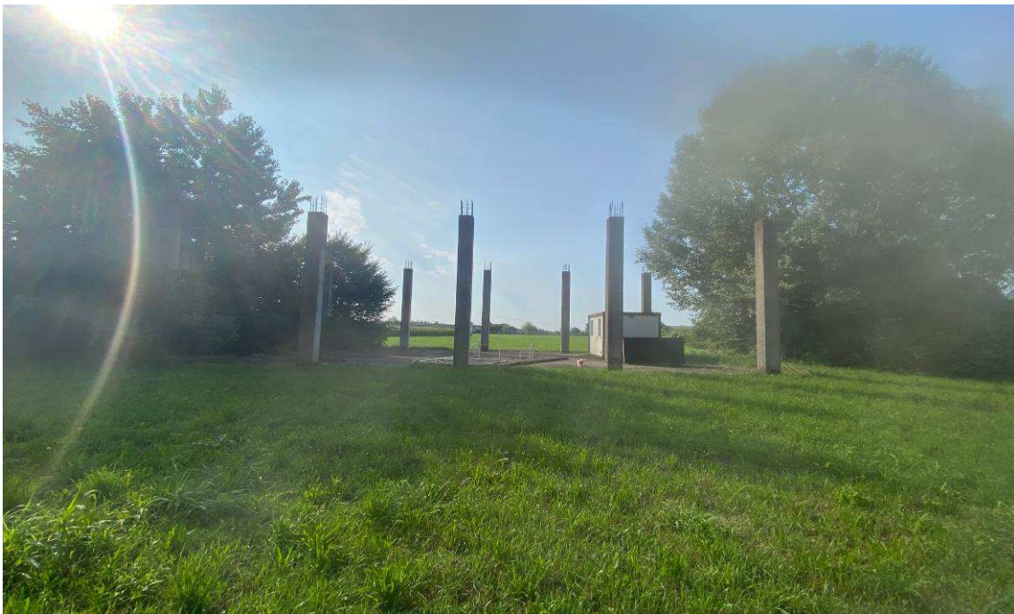
VISTA ESTERNA SCHELETRO ANNESSO RISTICO
