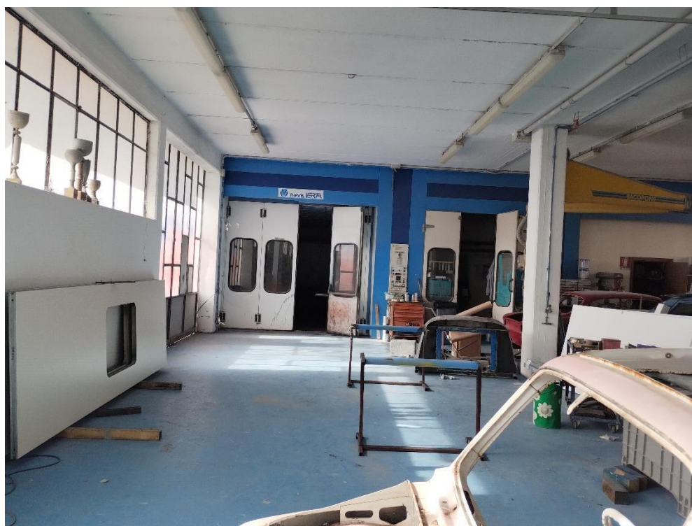
FOTO 5 - LOTTO 1 : INFONDO VISIBILE AMPLIAMENTO NON AUTORIZZATO PER
