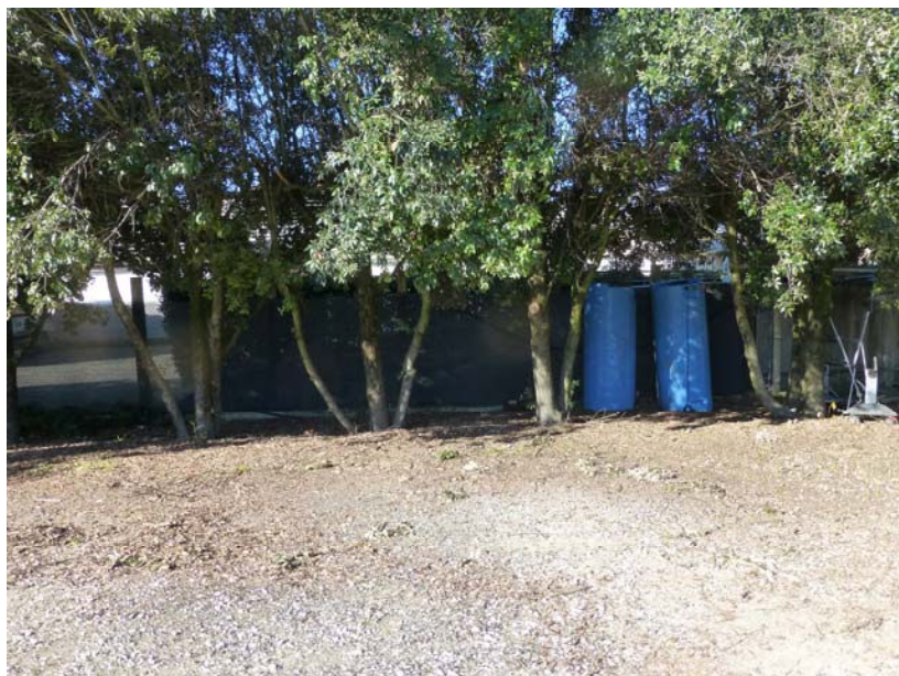
FOTO 15 – Vista dell'impianto di depurazione
