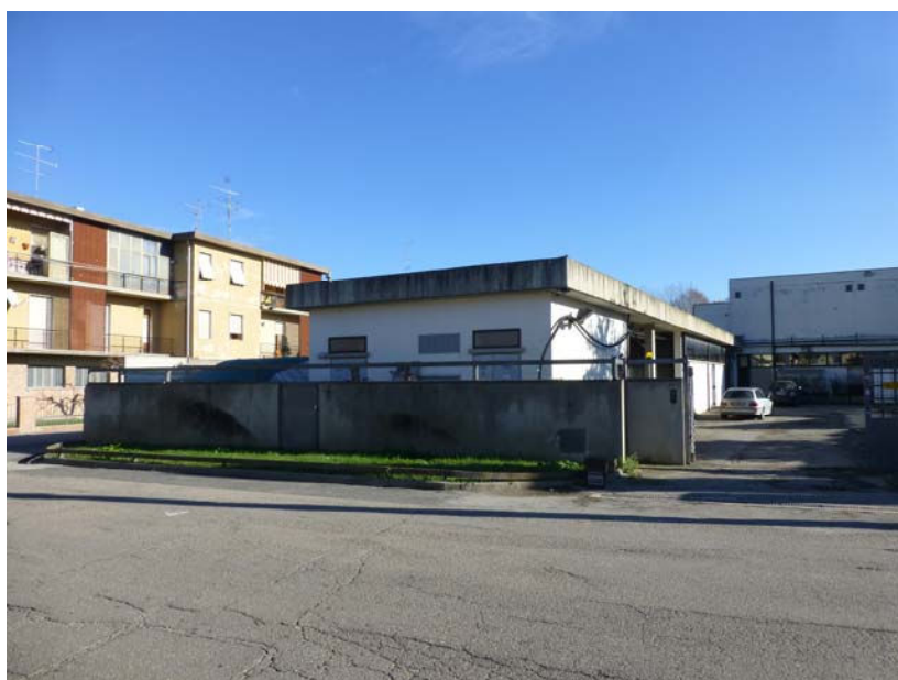
FOTO 2 – Vista zona fronte via Grieco ospitante la cabina ENEL
