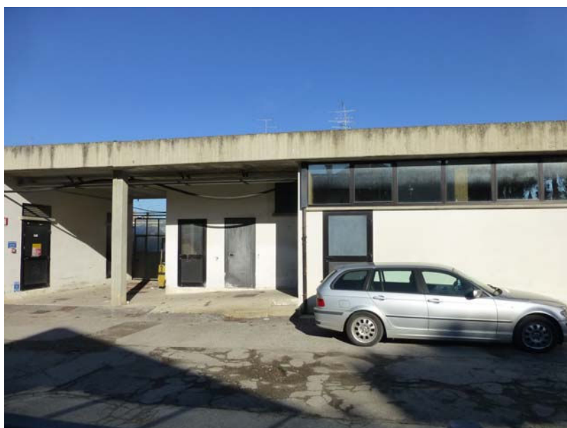
FOTO 4 – Vista dell'edificio e del piazzale frontale di carico/scarico
