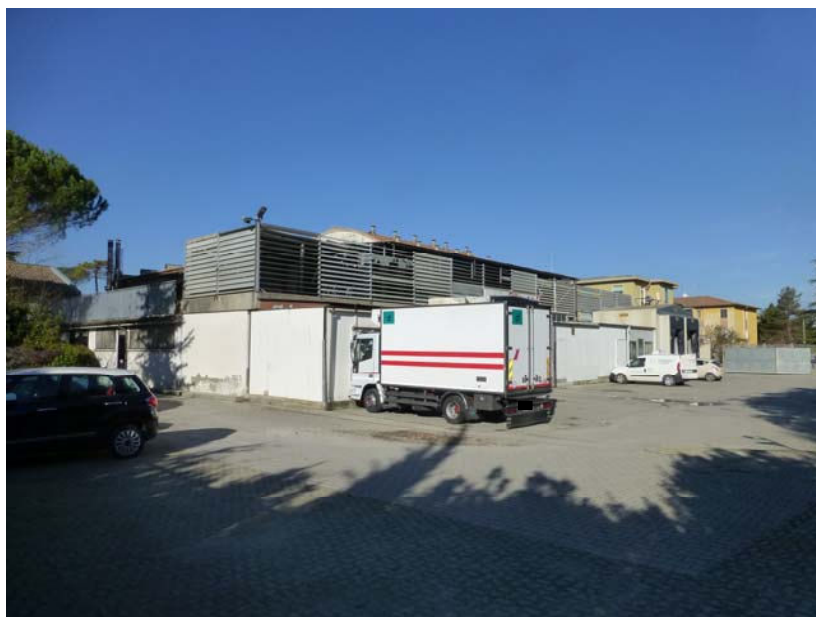
FOTO 9 - Vista del prospetto posteriore con il piazzale con l'ampliamento del fronte tergale
