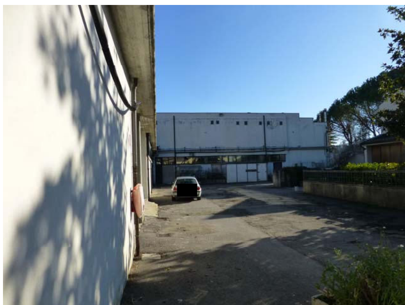
FOTO 6 – Vista dell'edificio e del piazzale frontale di carico/scarico
