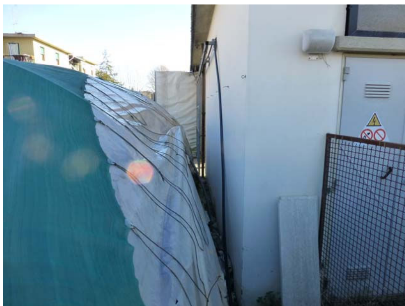
FOTO 28 – Vista dello spazio tra recinzione lato nord-est in pannelli di calcestruzzo ed edificio industriale
