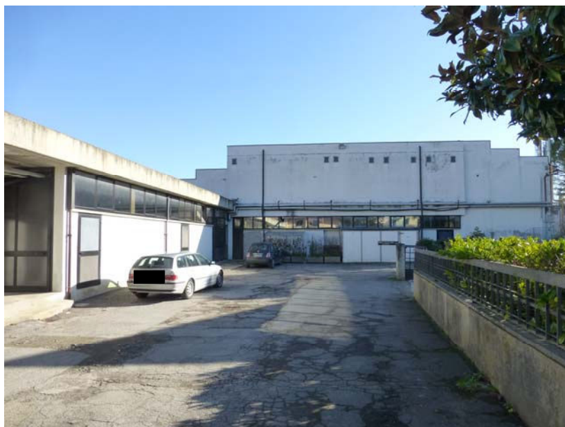
FOTO 5 – Vista dell'edificio e del piazzale frontale di carico/scarico
