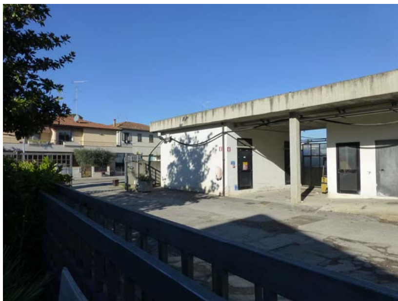
FOTO 3 – Vista della zona di ingresso via Grieco n.35 dall'interno
