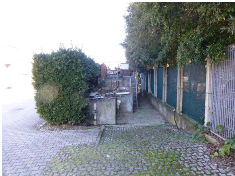
FOTO 23 – Vista dell'impianto di depurazione
