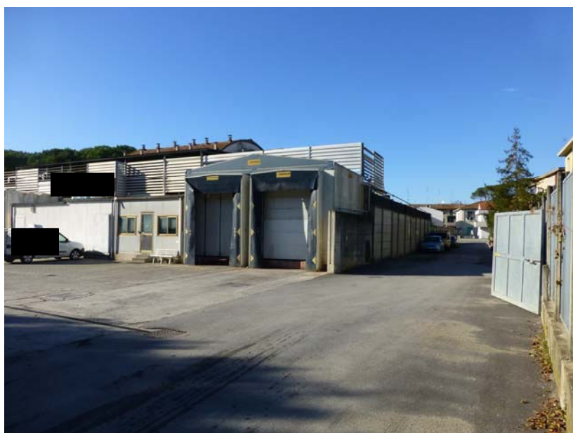
FOTO 24 – Vista dell'accesso al piazzale tergale tramite strada privata attigua
