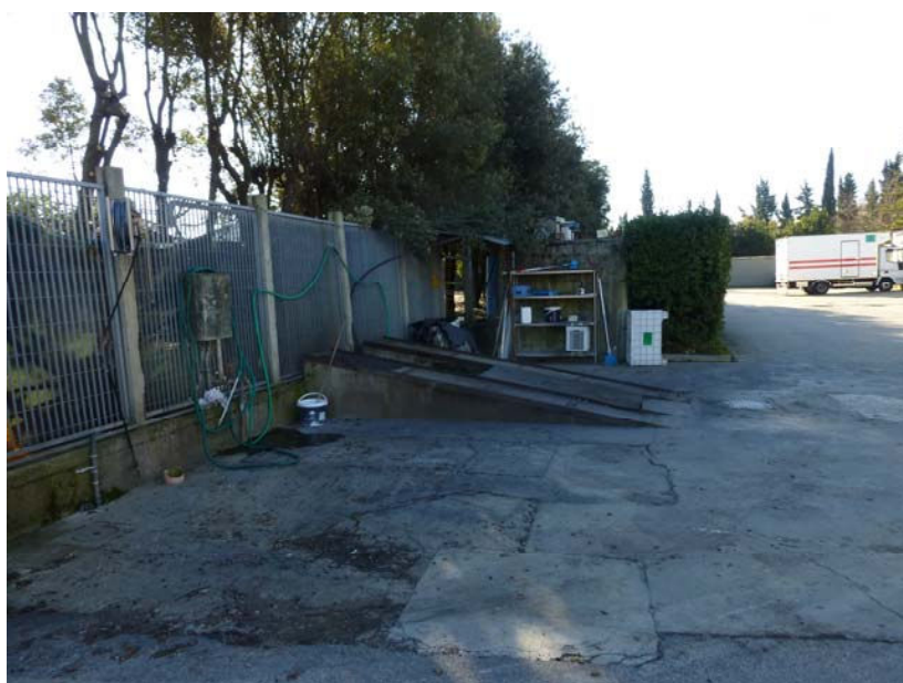
FOTO 22 – Vista dell'impianto di depurazione
