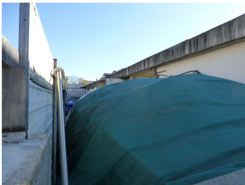
FOTO 27 – Vista dello spazio tra recinzione lato nord-est in pannelli di calcestruzzo ed edificio industriale
