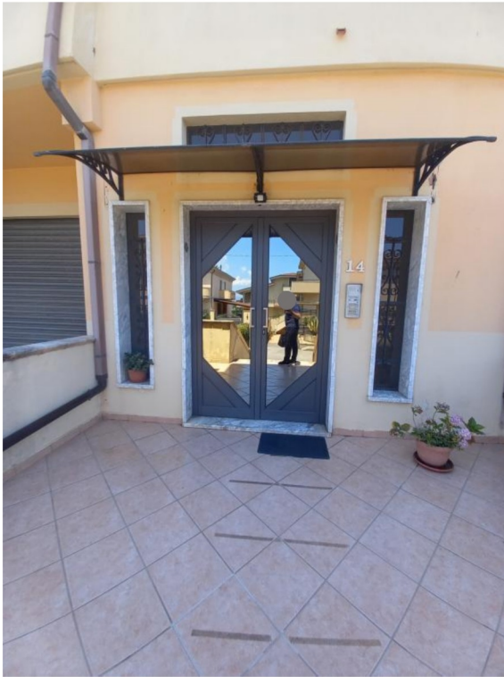
Foto n. 5: Ingresso vano scala
