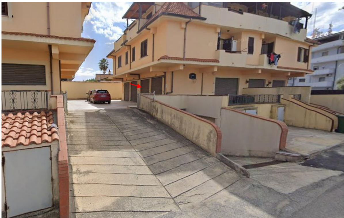
Foto n. 4: Garage part. 721 sub 22- fabbricato corpo "A"
