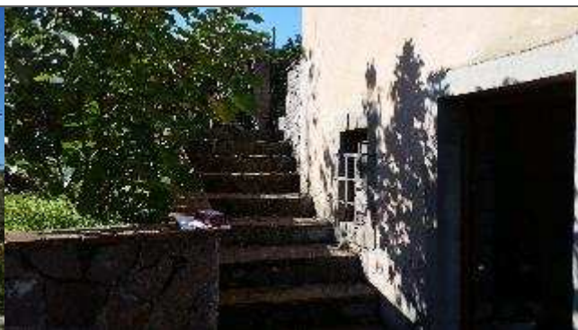
foto n.2 – ingresso al piano seminterrato
