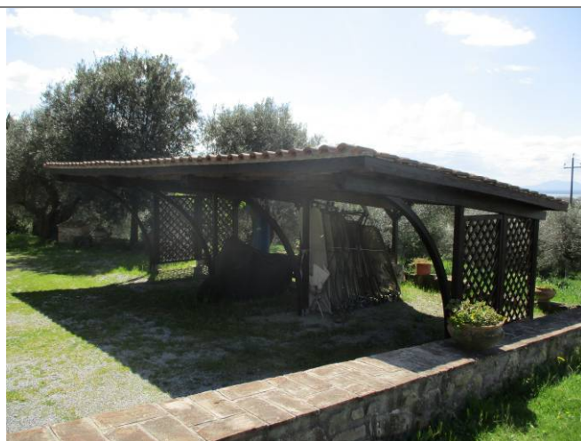
Foto n. 12 - Vista Tettoia per ricovero automezzi
