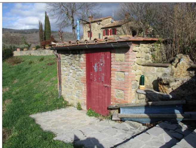
Foto n. 9 - Vista Locale tecnico piscina
