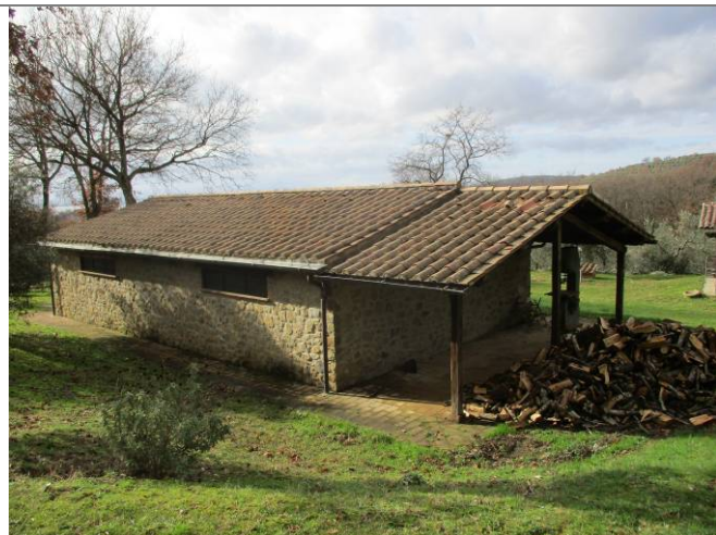
Foto n. 58 - Vista Tettoia (P.T.)
