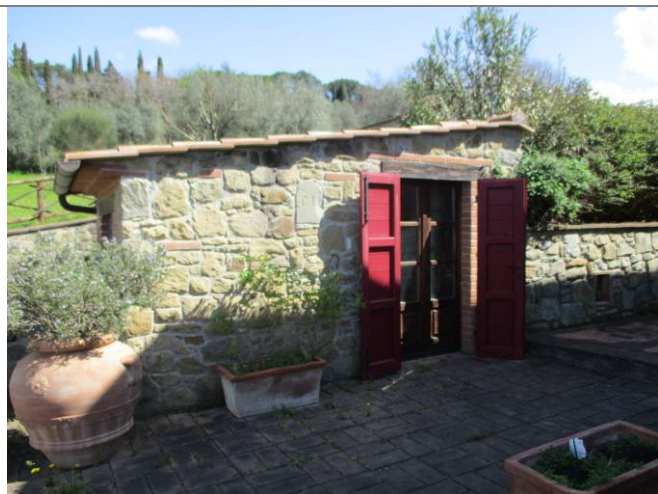
Foto n. 55 - Vista locale lavanderia (P.T.)
