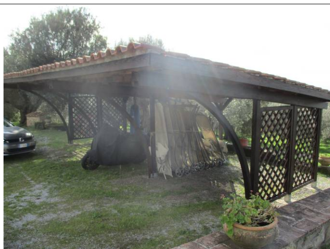
Foto n. 11 - Vista Tettoia per ricovero automezzi
