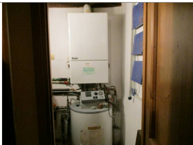
Foto n. 27 - Locale tecnico (P.T.)
