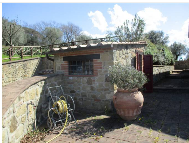
Foto n. 54 - Vista locale lavanderia (P.T.)
