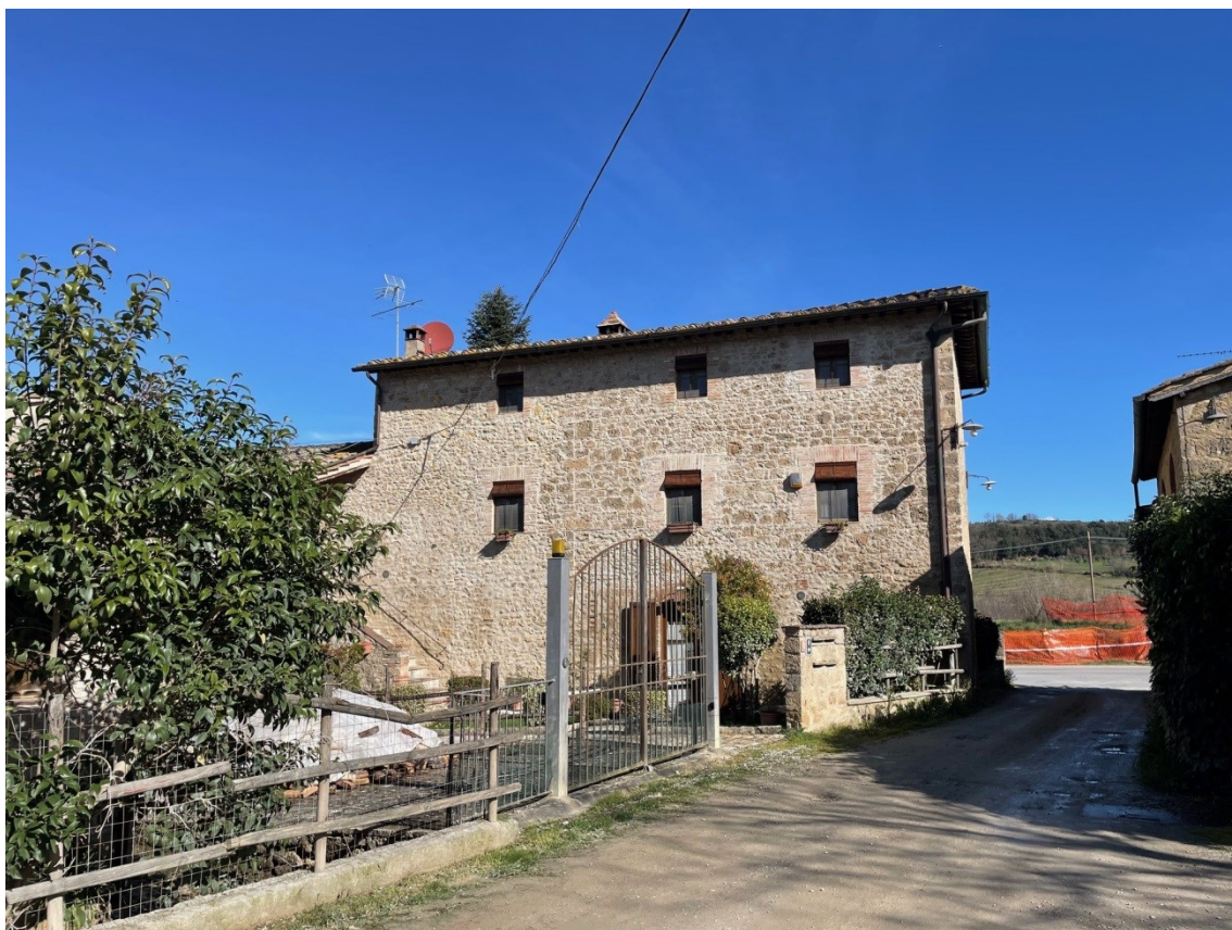
Vista secondaria complesso immobiliare ospitante le u.i.u. oggetto di pignoramento
