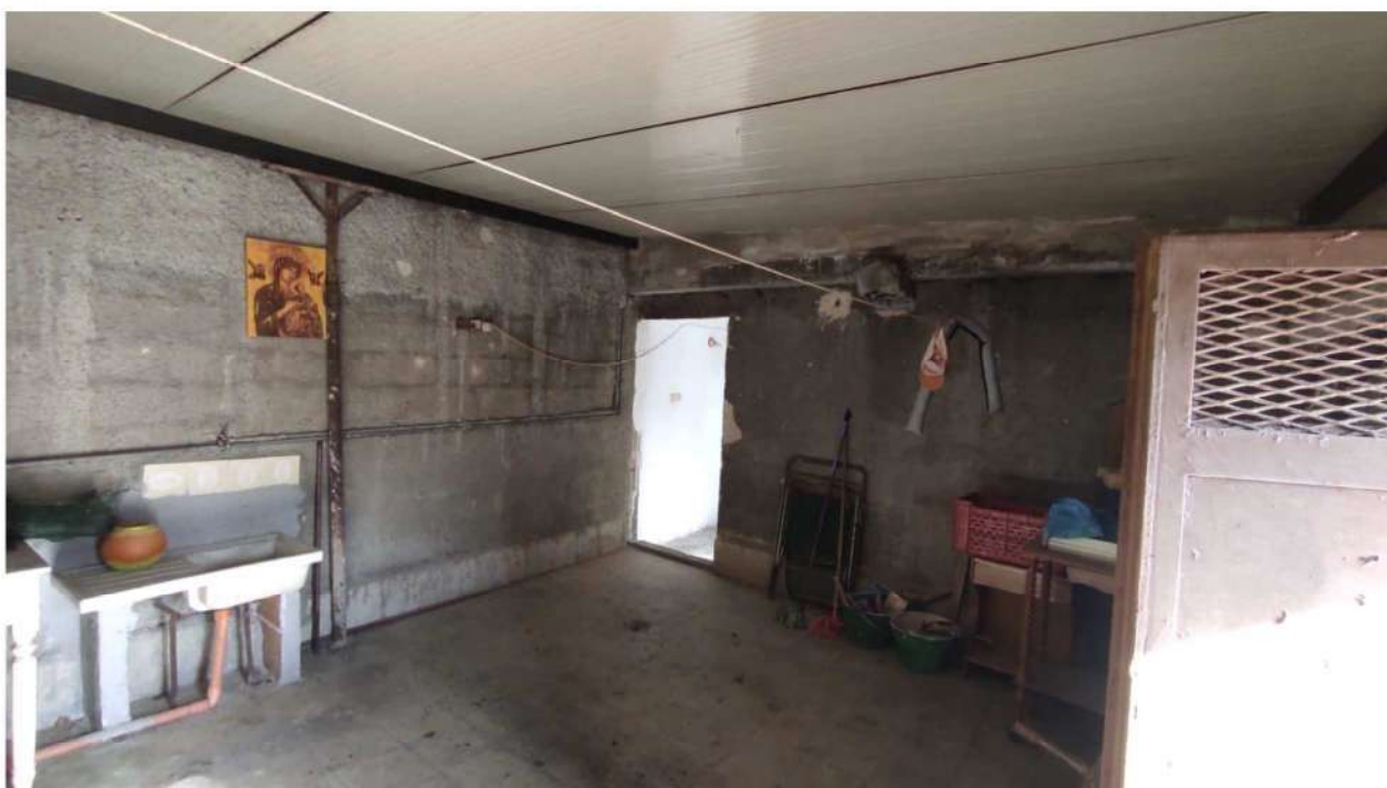
Foto n.2 – Vano camera a P.3°.
