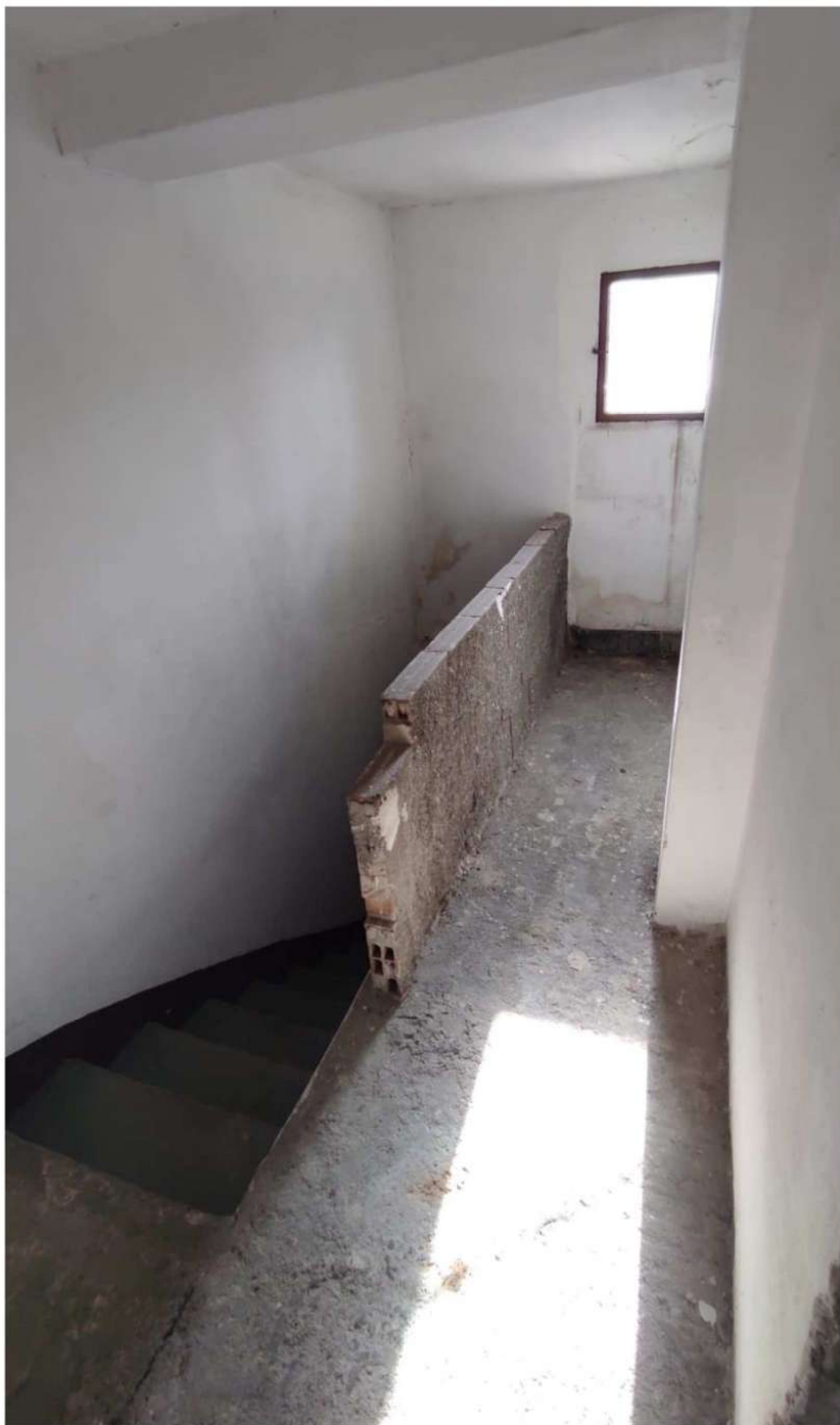
Foto n.1 – Vano scala e disimpegno a P.3°.
