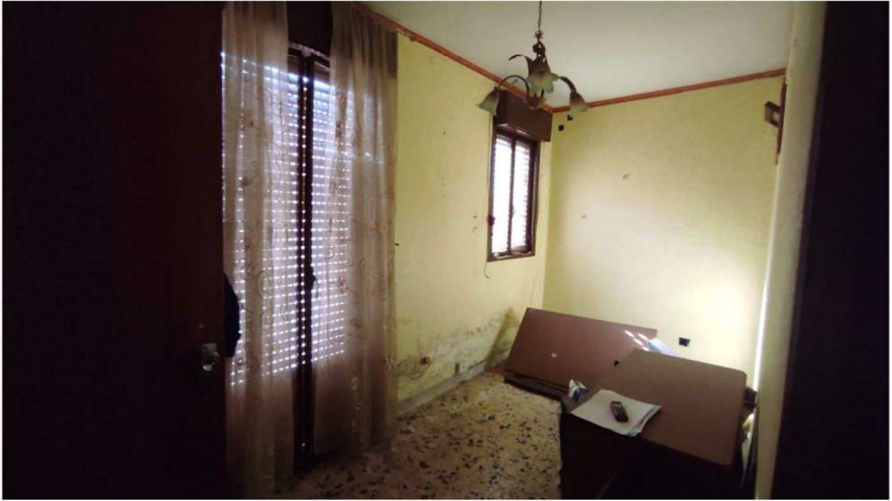
Foto n.2 – Vano ingresso a P.2°.
