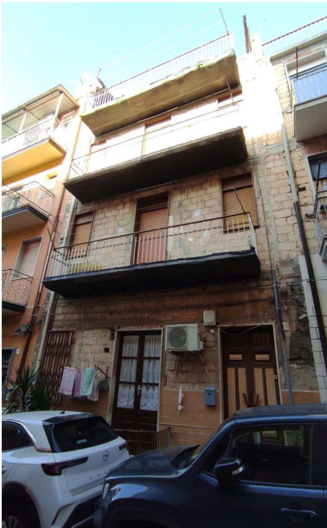
Foto n.1 – Visione dell'esterno dell'immobile – Prospetto Principale
