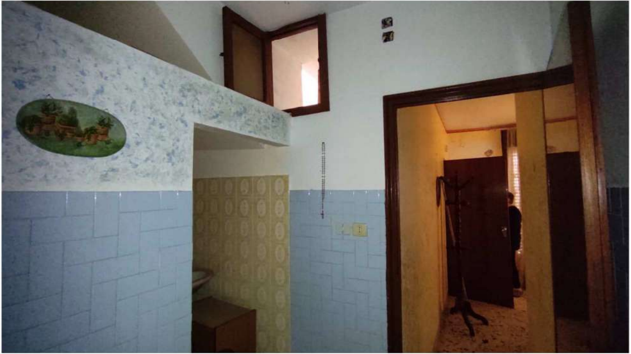
Foto n.4 – Vano anti w.c. a P.2°.
