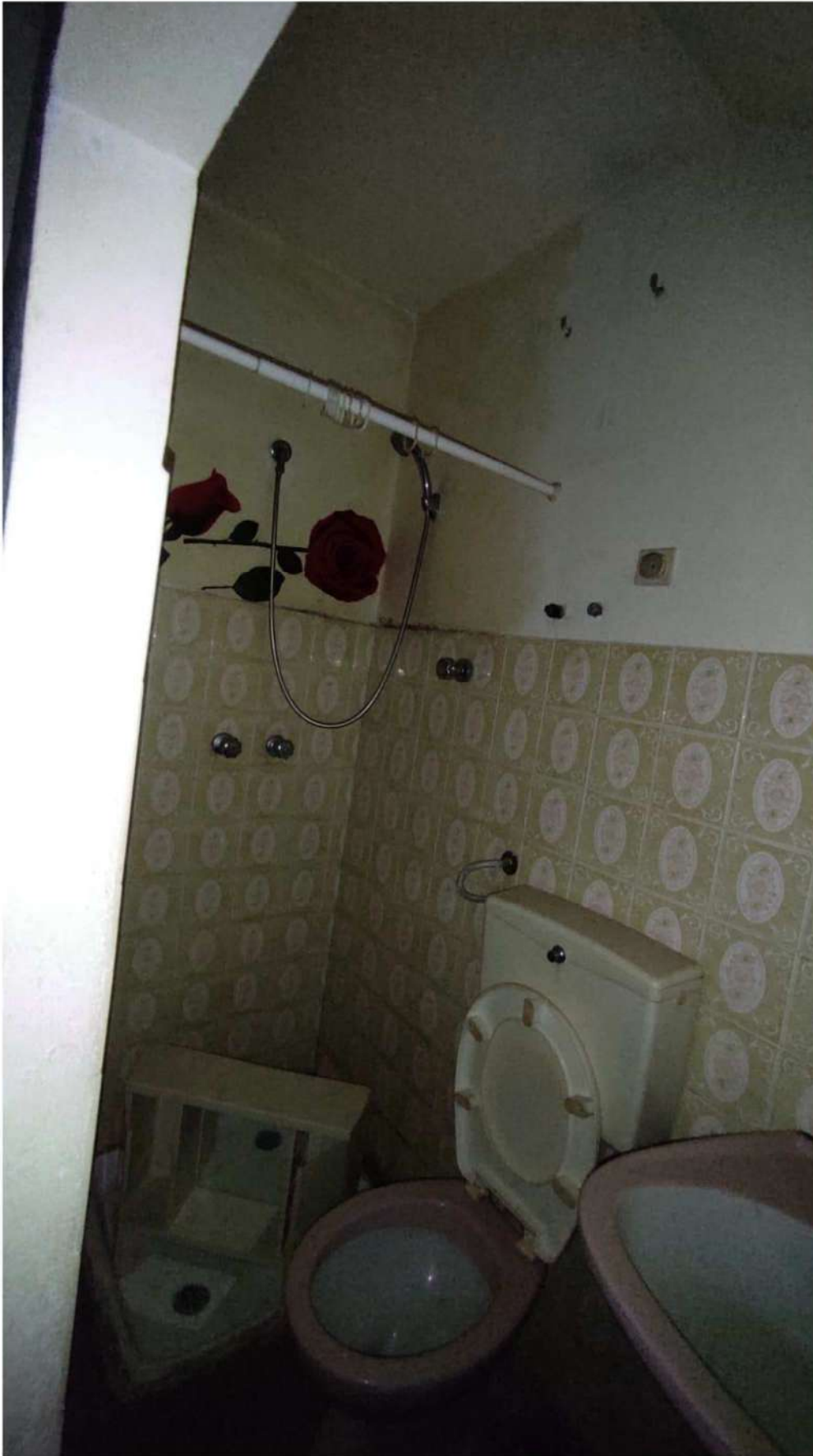
Foto n.5 – Vano w.c. a P.2°.
