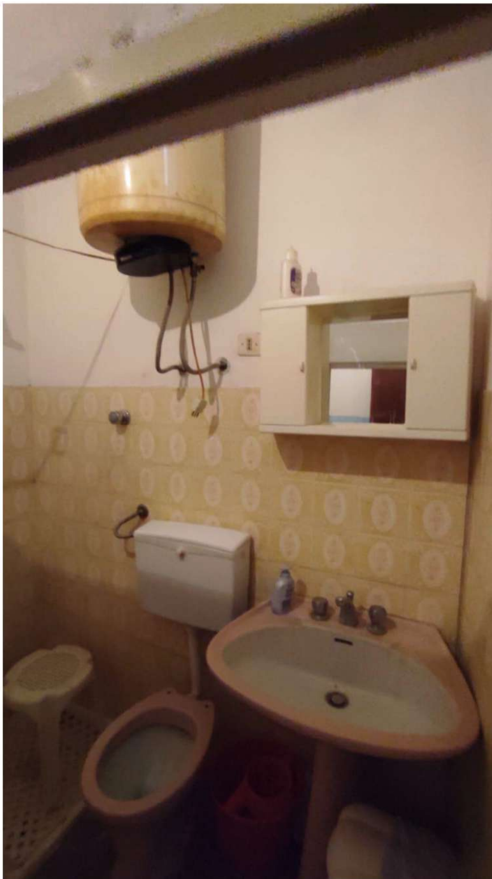
Foto n.5 – Vano w.c. a P.1°.
