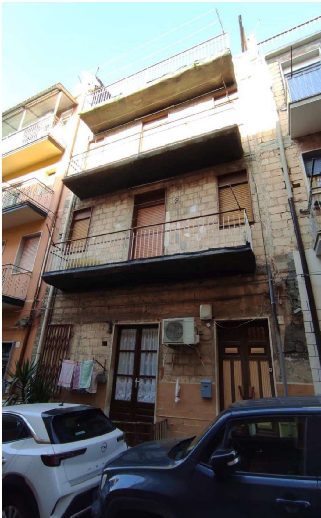
Foto n.1 – Visione dell'esterno dell'immobile – Prospetto Principale
