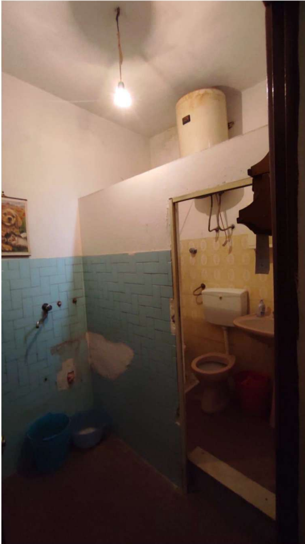
Foto n.4 – Vano anti w.c. a P.1°.
