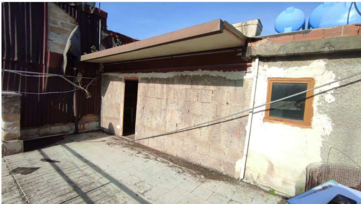
Foto n.2 – Visione dell'esterno del Piano terzo – Prospetto Principale
