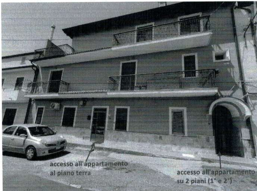
prospetto del fabbricato
