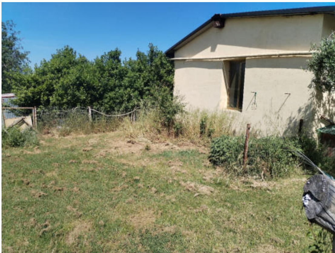
Foto n° 12 : prospetto Sud del fabbricato censito al C.F. nel foglio n° 39 con la particella n° 473/4
