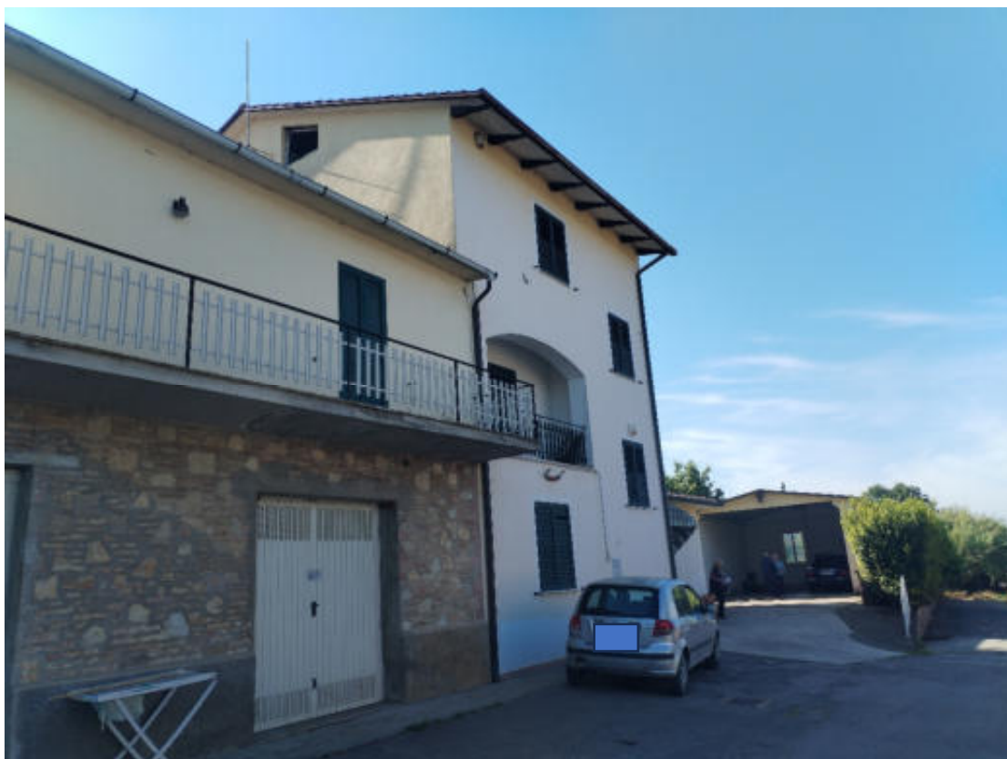
Foto n° 5: prospetto Ovest del fabbricato censito al C.F. nel foglio n° 39 con le particelle n° 11/11-473/2(graftata), n° 11/12-473/3(graftata) e n° 11/4
