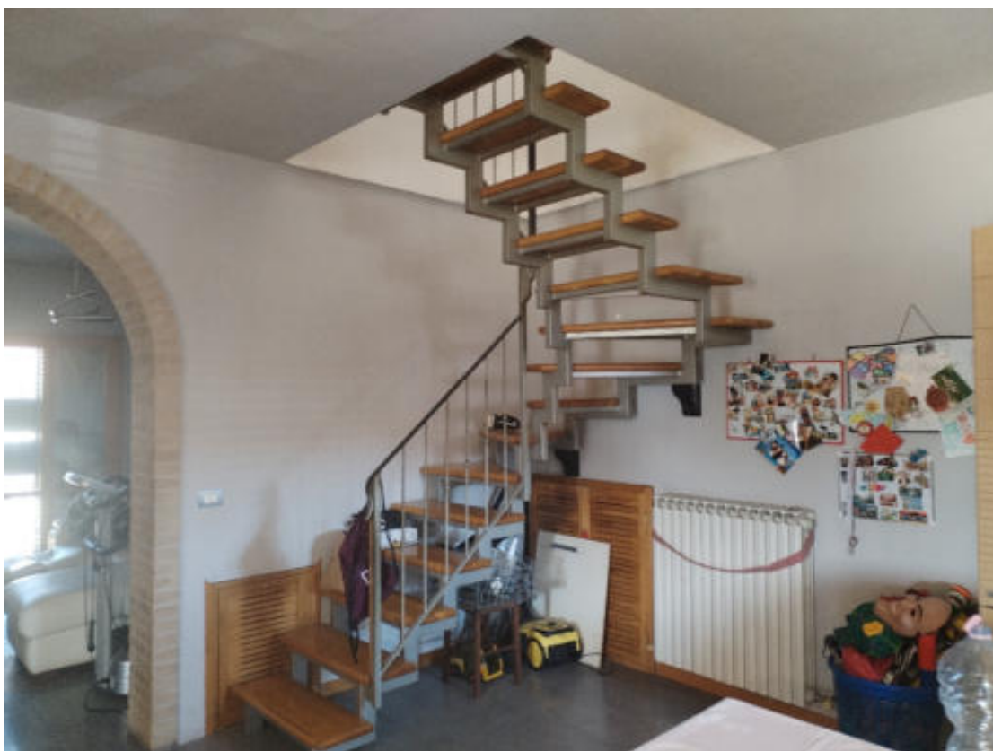
Foto n° 29 : interno dell'unità immobiliare censita al C.F. nel foglio n° 39 con la particella n° 11/12-473/3(graftata) – scala a chiocciola interna di collegamento al piano 2° –
