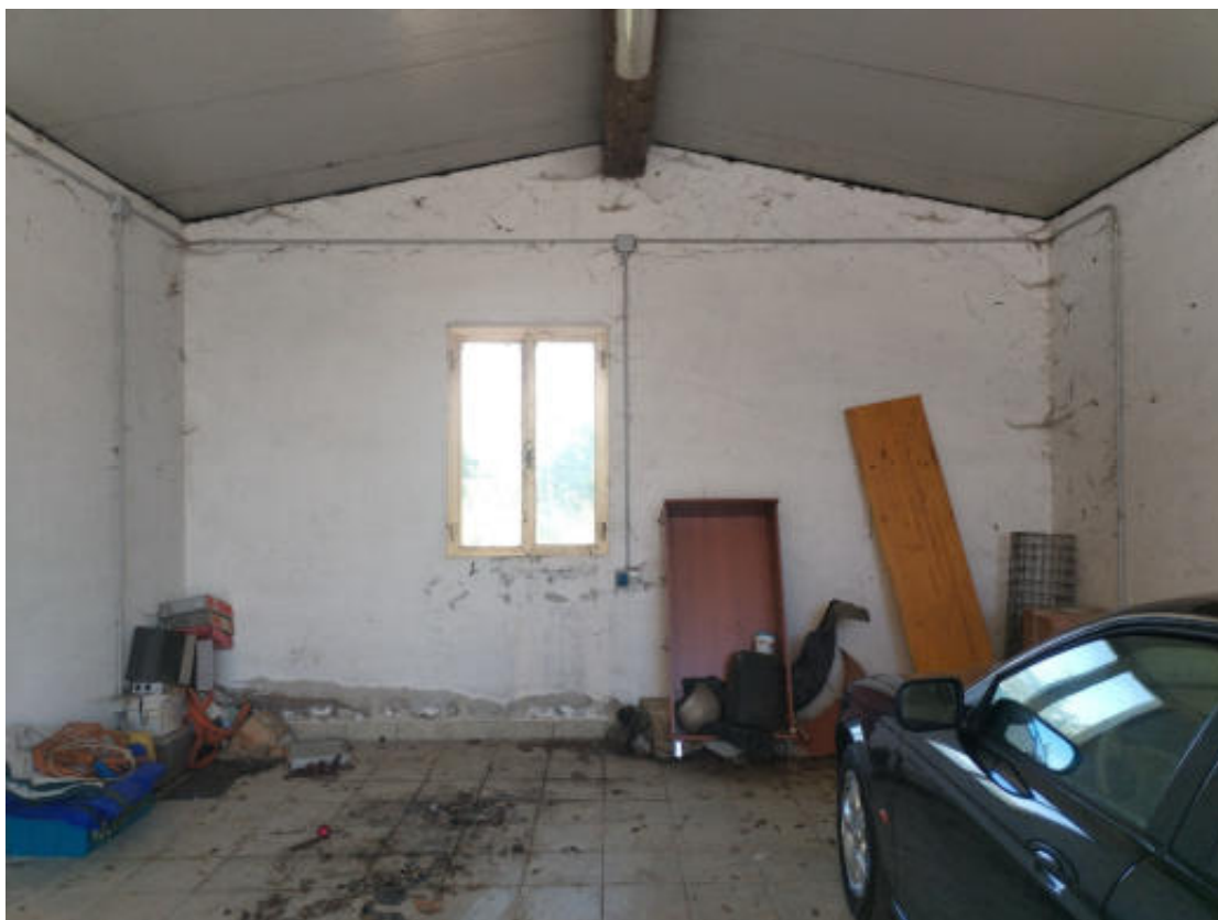
Foto n° 40 :interno dell'unità immobiliare censita al C.F. nel foglio n° 39 con la particella n° 473/4
