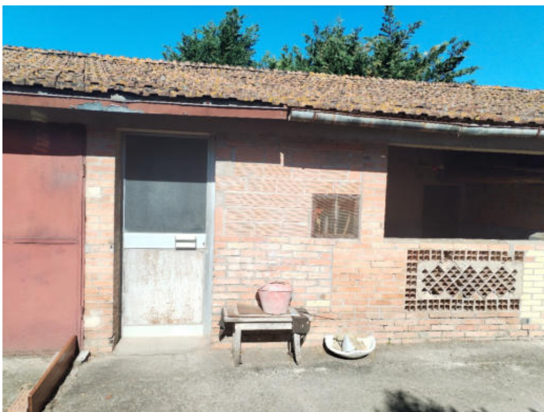
Foto n° 14 : prospetto Ovest del fabbricato censito al C.F. nel foglio n° 39 con la particella n° 217/4
