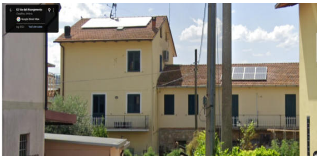
Foto n° 10: prospetto Nord/Est del fabbricato censito al C.F. nel foglio n° 39 con le particelle n° 11/11-473/2(graftata) e n° 11/12-473/3(graftata)
