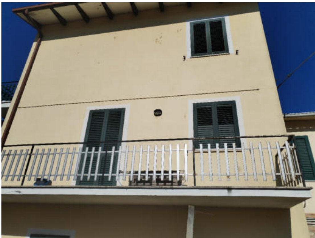
Foto n° 8: prospetto Est del fabbricato censito al C.F. nel foglio n° 39 con le particelle n° 11/11-473/2(graftata) e n° 11/12-473/3(graftata)
