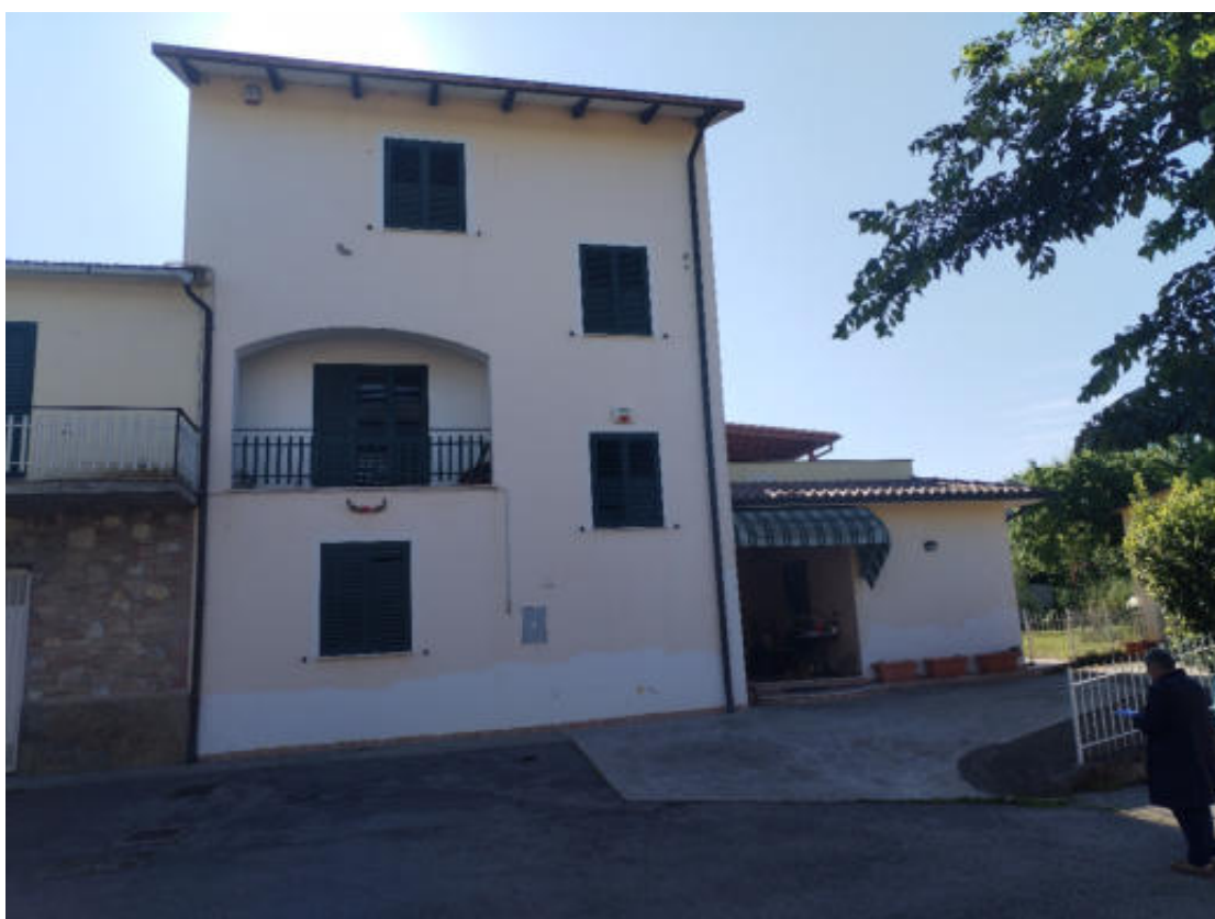
Foto n° 6: prospetto Ovest del fabbricato censito al C.F. nel foglio n° 39 con le particelle n° 11/11-473/2(graftata) e n° 11/12-473/3(graftata)
