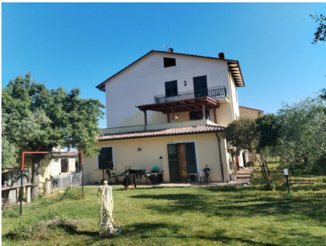
Foto n° 7: prospetto Sud del fabbricato censito al C.F. nel foglio n° 39 con le particelle n° 11/11-473/2(graftata) e n° 11/12-473/3(graftata) e corte comune ( C.F. fg n° 39 con la particella n° 473/5)
