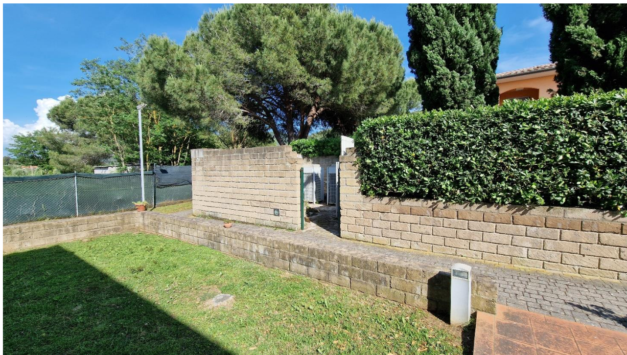
Fig. 31 – Vista esterna area impianti tecnologici
