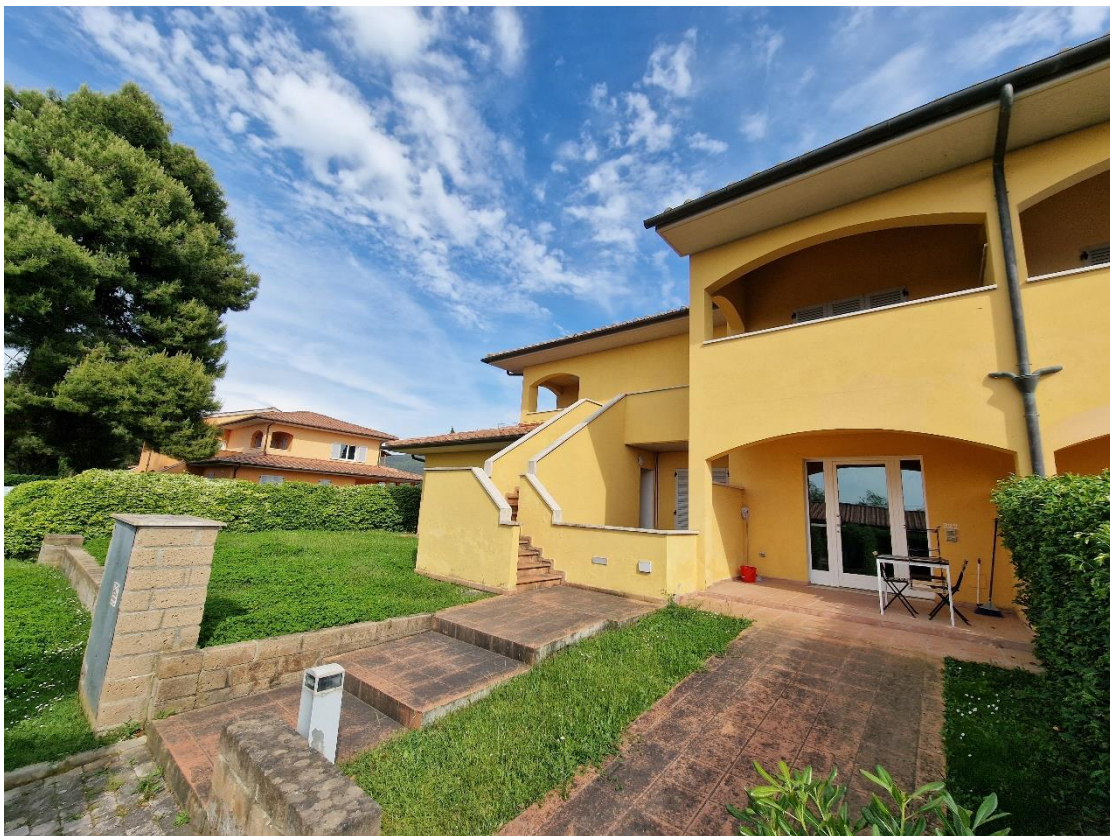
Fig. 18 – Palazzina gialla: vista sul fronte della porzione di proprietà
