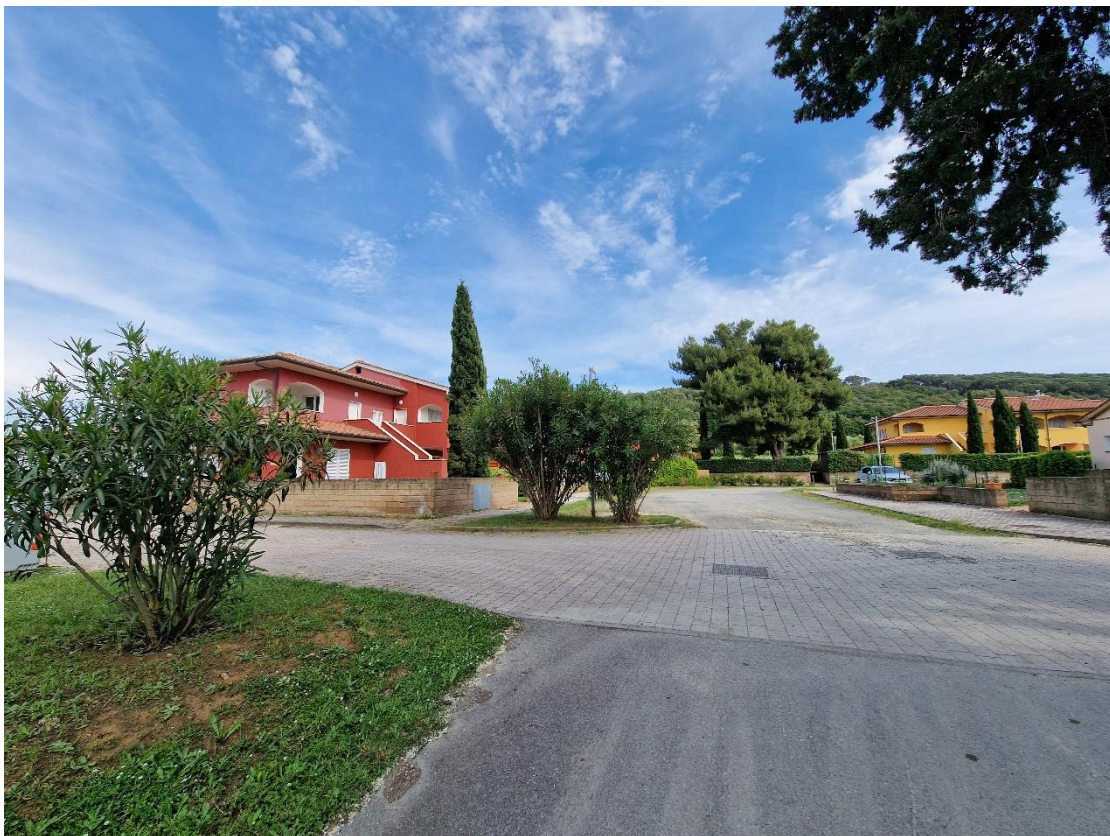
Fig. 1 – Vista ingresso all'RTA
