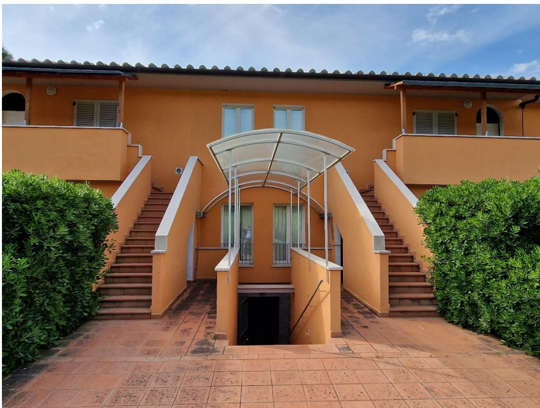
Fig. 16 – Palazzina arancio: vista sul retro
