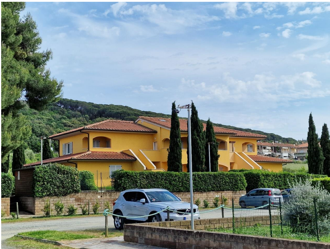
Fig. 17 – Palazzina gialla: vista dal piazzale
