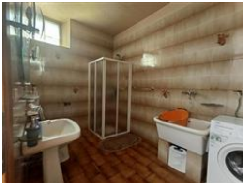
Dettaglio del vano accatastato come lavanderia e trasformato in servizio igienico sanitario
