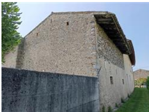
Vista prospetto Sud - Ovest
