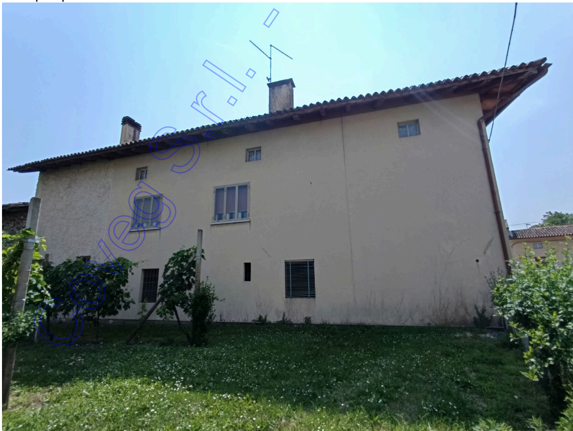
Vista prospetto Est fabbricato
