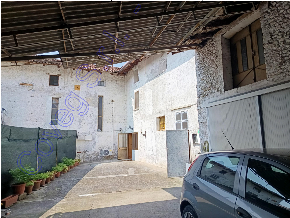
Vista fabbricato dalla corte comune (utilizzata in maniera esclusiva)
