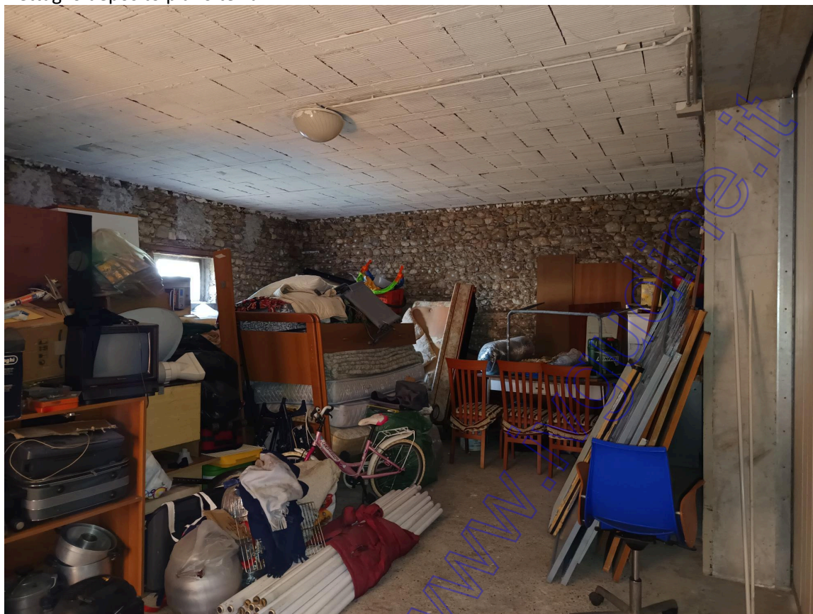
Dettaglio deposito piano terra
