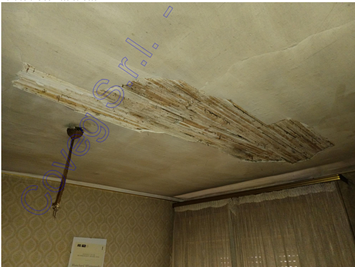
Particolare soffitto salotto
