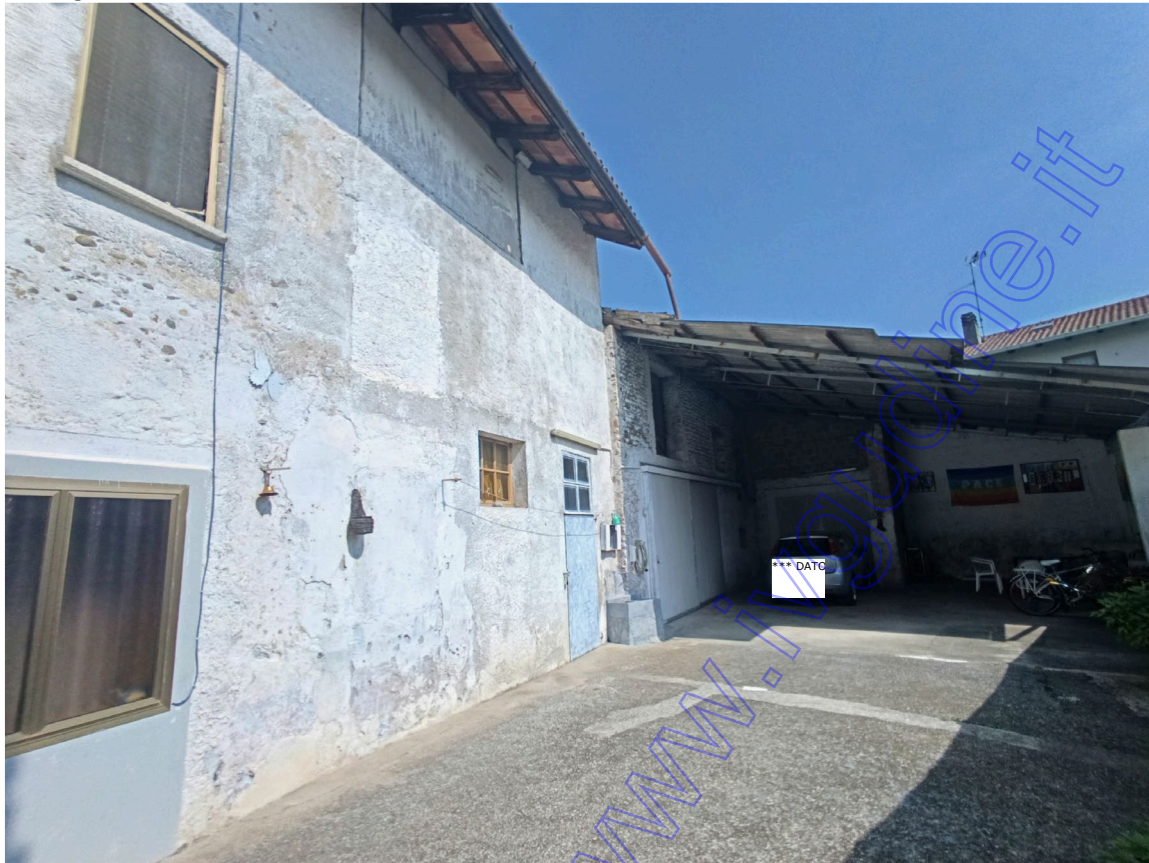
Dettaglio tettoia da demolire
