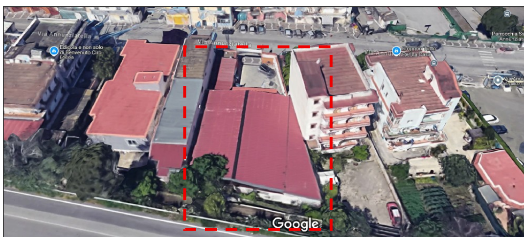
Immagine satellitare Google Earth – Inquadramento urbanistico del fabbricato
