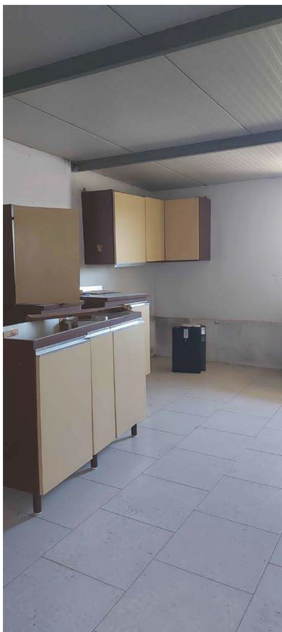
F. 15 - Locale termico
