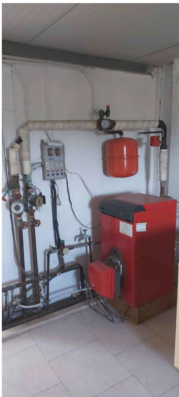
F. 14 Vista locale termico
