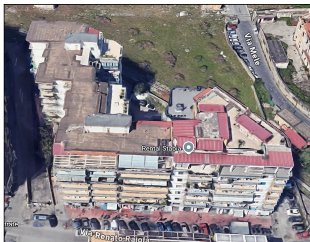
Immagine satellitare fabbricato
