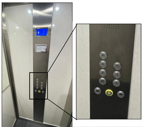
Particolare di pulsantiera ascensore a servizio delle unità abitative
