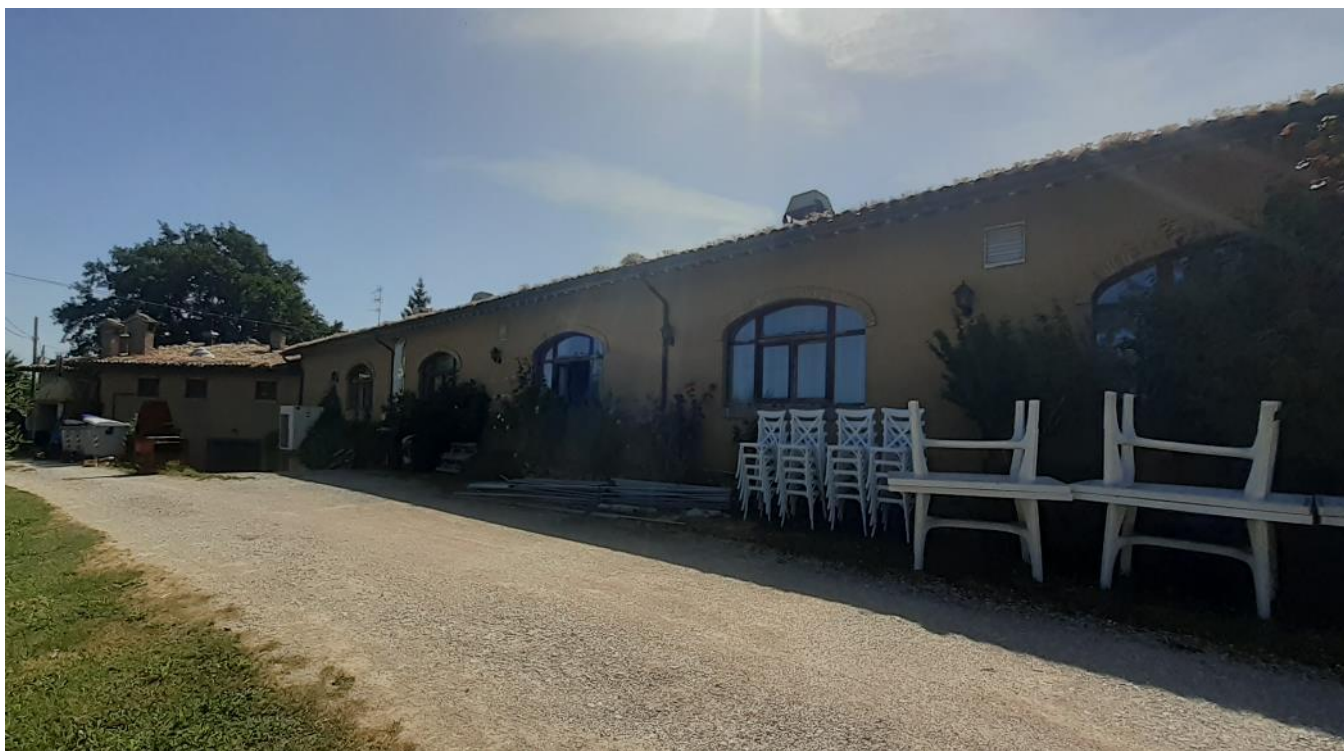
Foto 4 – Vista dell'edificio da sud-ovest. La parte rettilinea ospita la sala banchetti.
