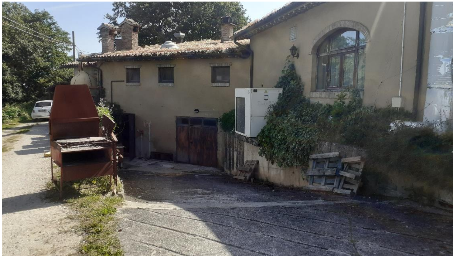
Foto 5 – L’edificio presenta una porzione con piano interrato che ospita locali di servizio.
