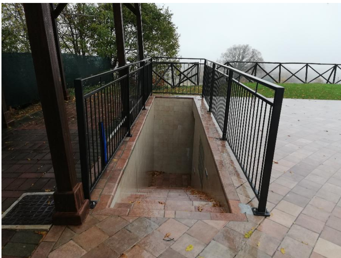
Foto 24 – L'ingresso agli spogliatoi ed alla zona servizi della piscina.
