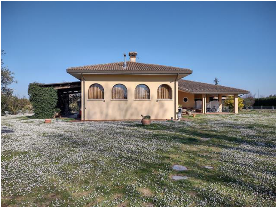
FOTO 7. La porzione di villa che contiene l'abitazione: prospetto laterale
