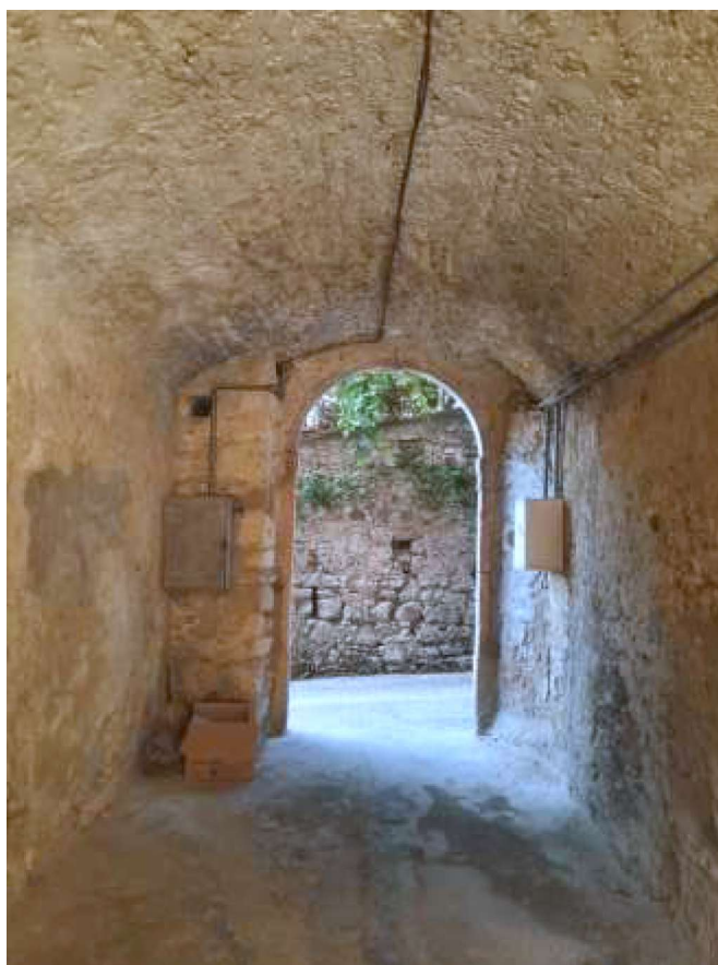
VISTA VERSO VICO XX SETTEMBRE
