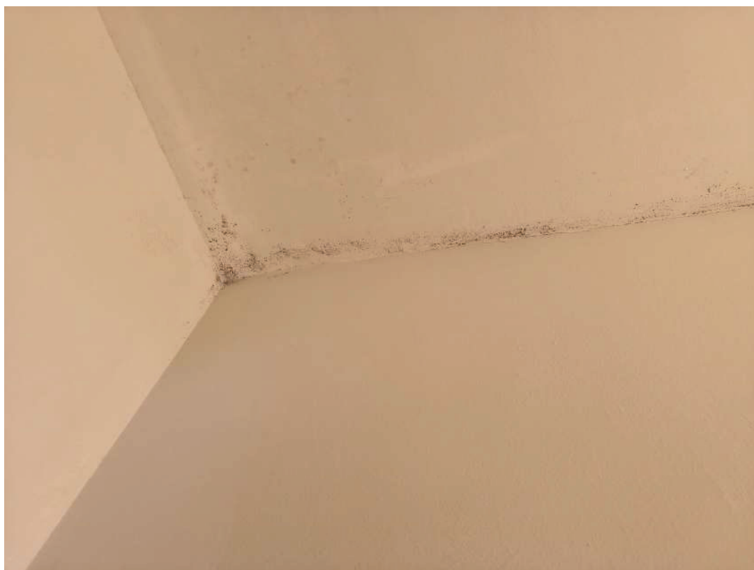
Foto n.12 (Zona solaio piano terzo)
