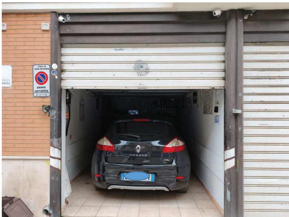
Foto n.23 (Autorimessa piano terra)
