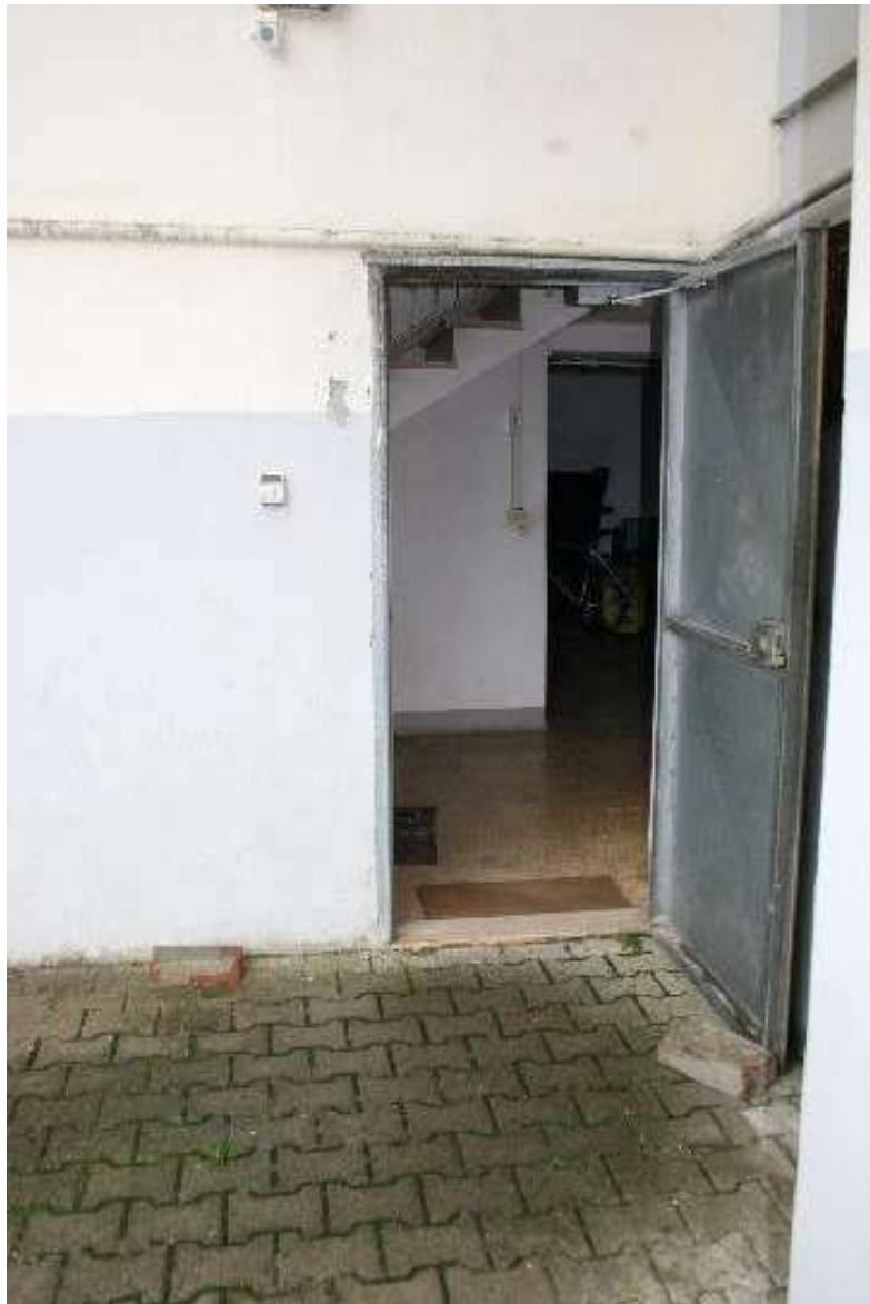
39– Il l'accesso all'immobile dall'area di manovra condominiale
