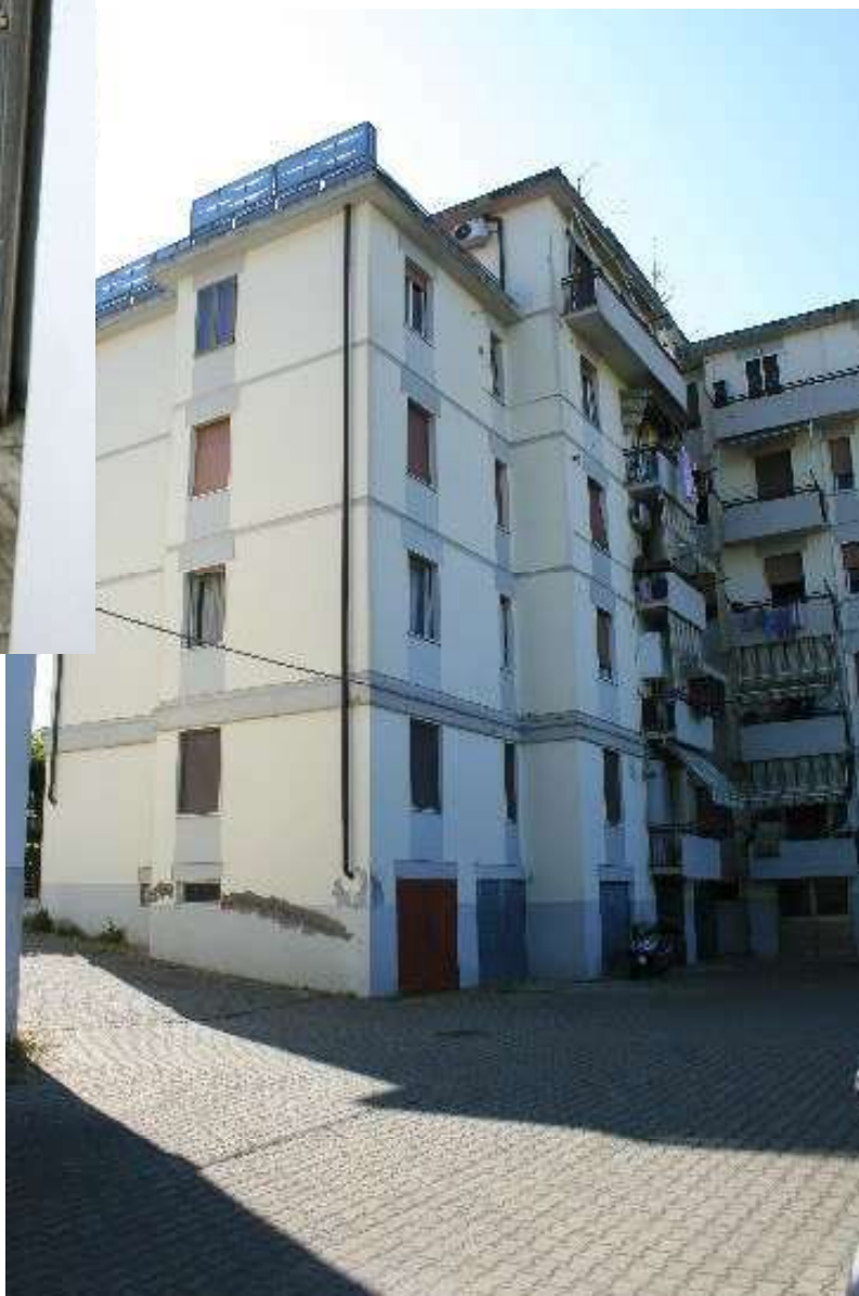
40– Il Box garage visto dall'area di manovra
