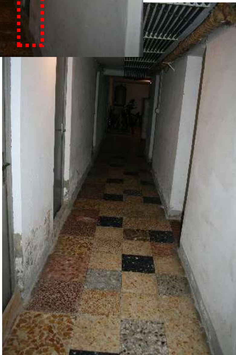
36 – Il Corridoio di accesso ai Box e Depositi), visti con le spalle alla Rampa
