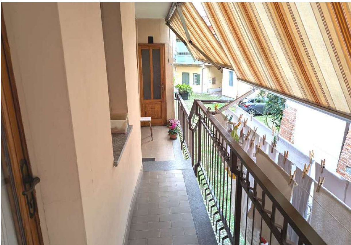
Immagine 7 - balcone/ballatoio su due livelli (sub. 7) dal quale si accede all'appartamento al P1
