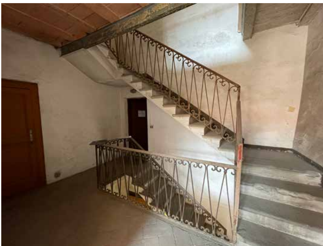
Scala comune di accesso ai piani dell'edificio
