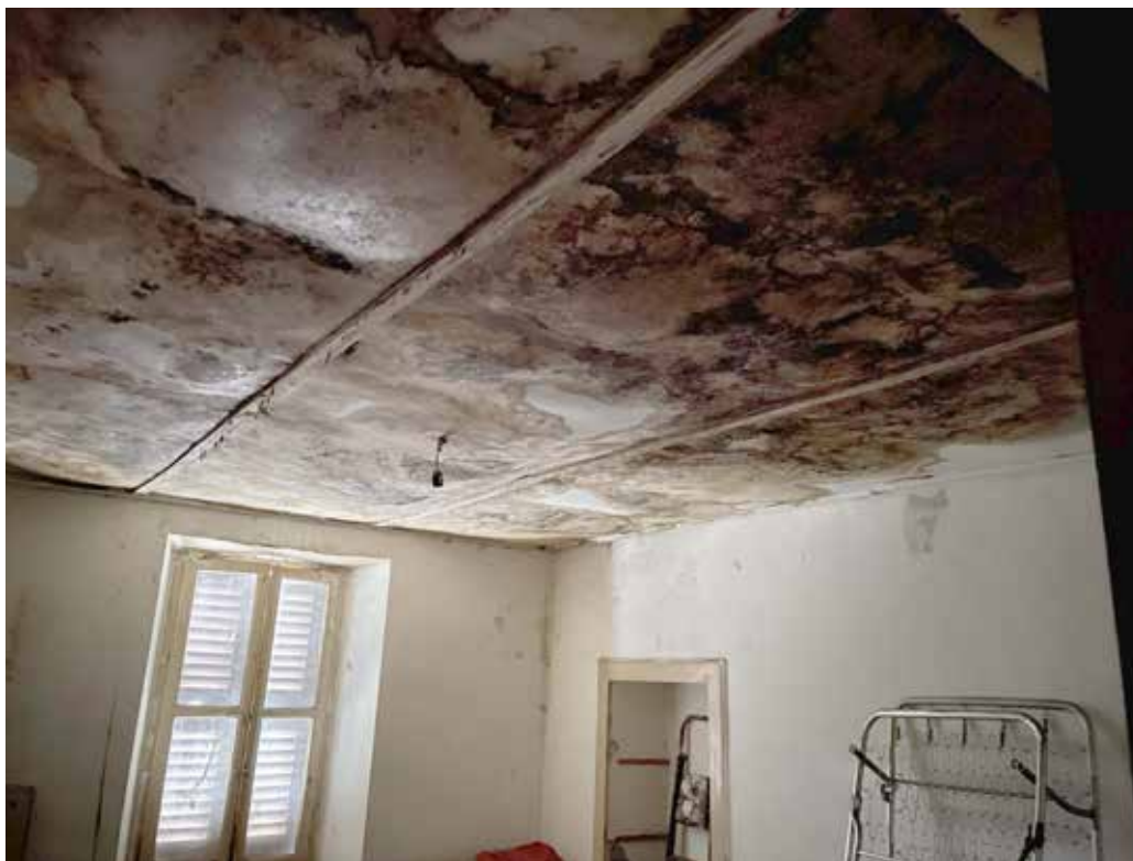
Particolare soffitto della camera
