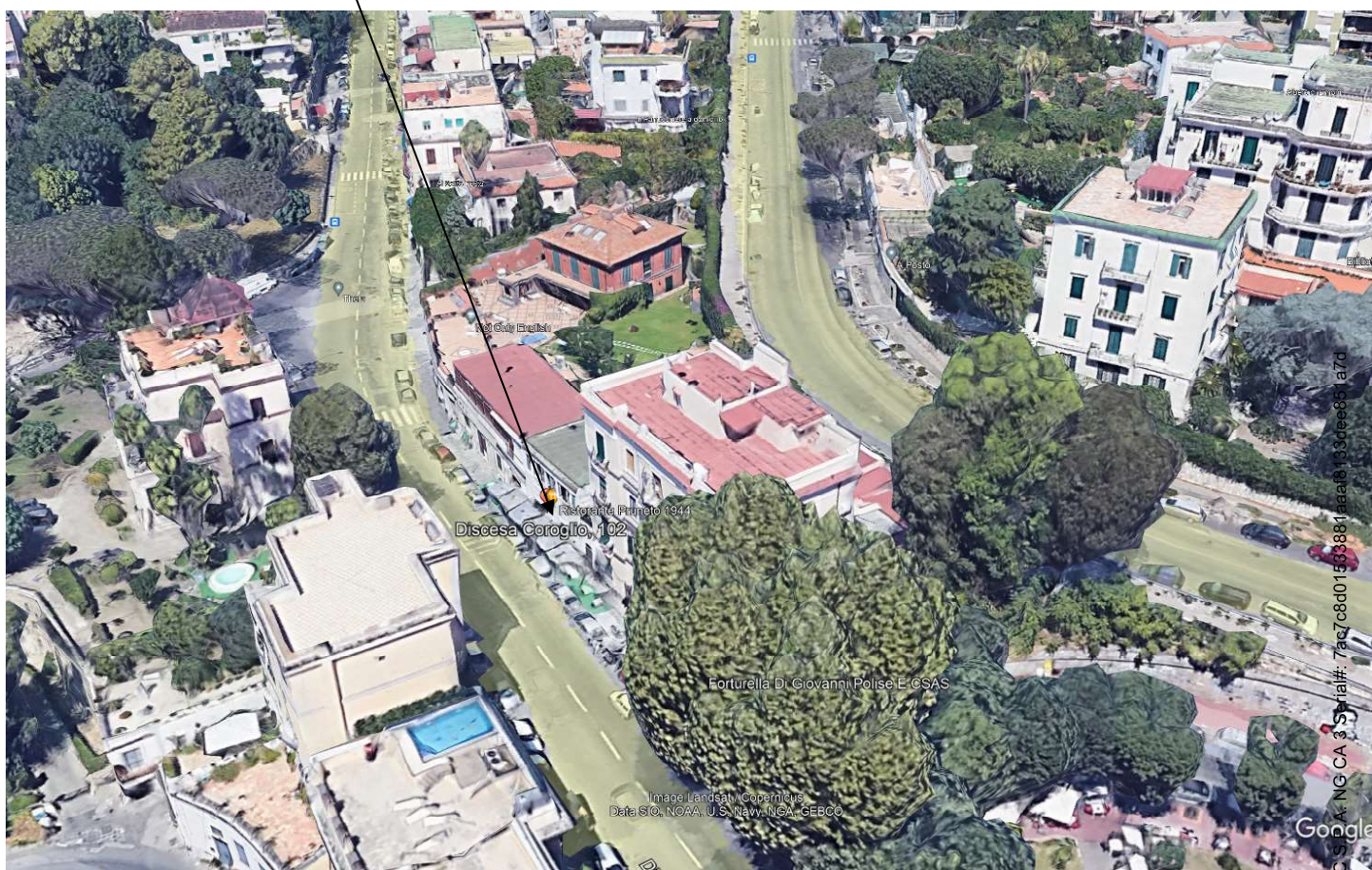
Foto n. inquadramento vista dall'alto del piccolo fabbricato alla Discesa Coroglio n. 102.
