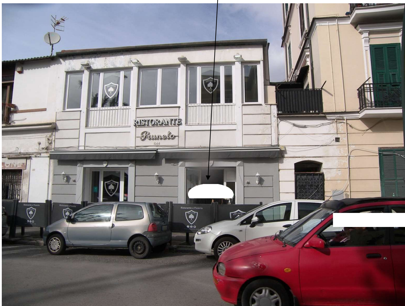
Foto n. 2: nella foto è visibile l'ingresso dell'unità immobiliare in oggetto, oggi facente parte della sala ristorazione del ristorante "PRUNETO" .
