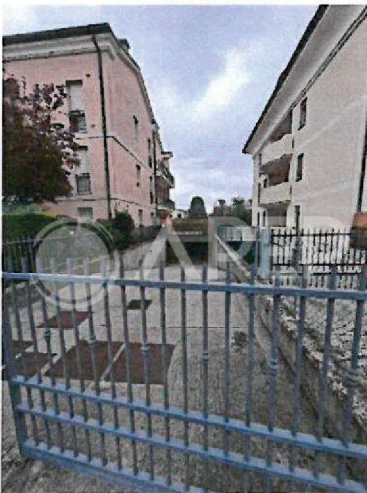
3 – Rampa di accesso ai garage
