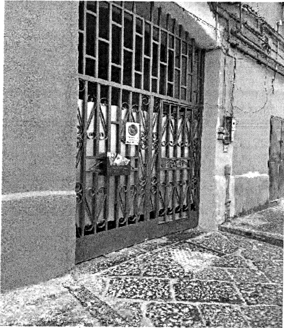
Foto 2 - Portone ingresso dell'edificio
