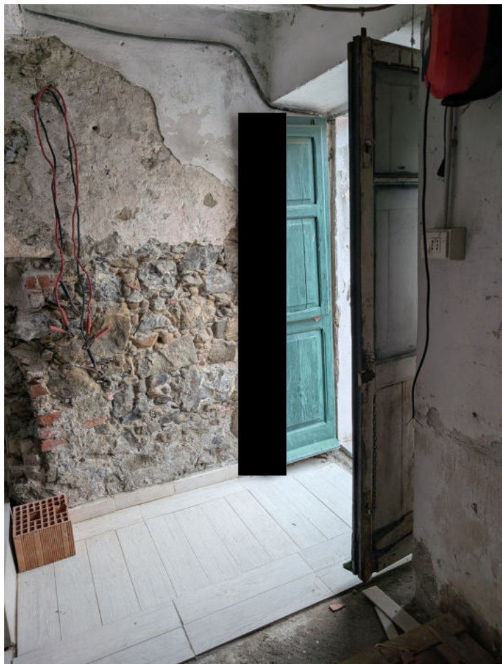
09 - Locale piano terra del mapp. 21 sub. 7
