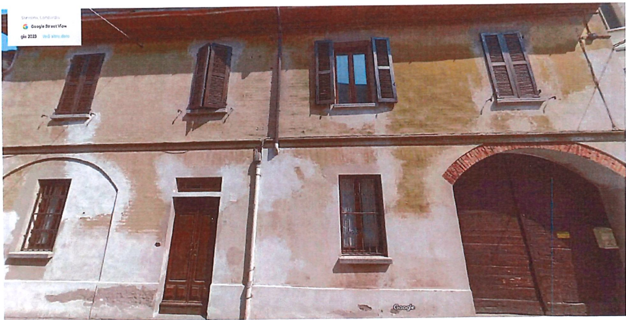
Particolare della facciata
