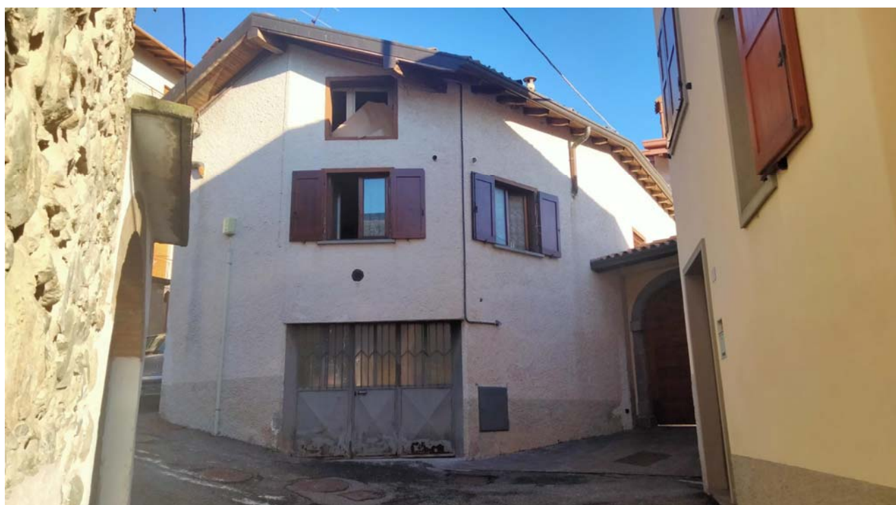
11. Accesso al ripostiglio-cantina P. semint..jpg
