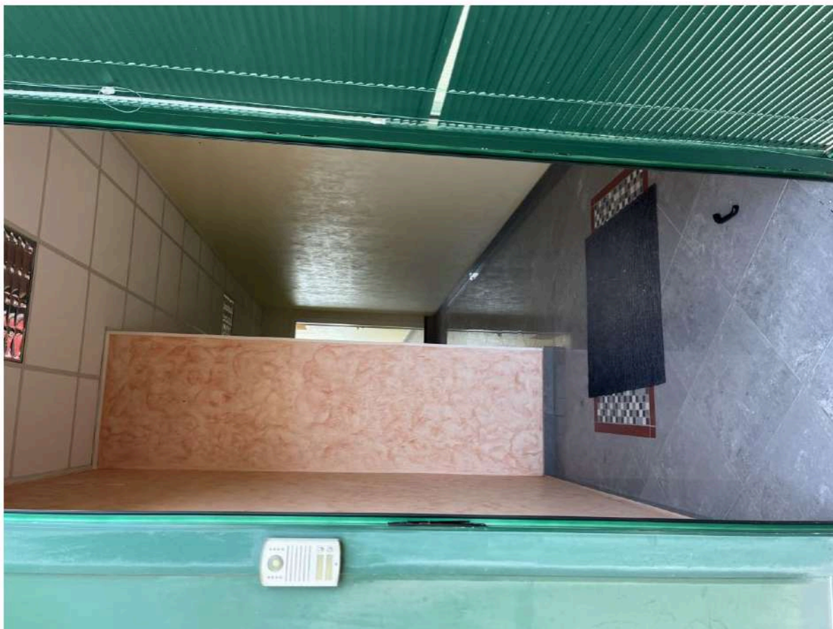
FOTO N. 9 – VISTA INGRESSO AGLI UFFICI SUL RETRO
