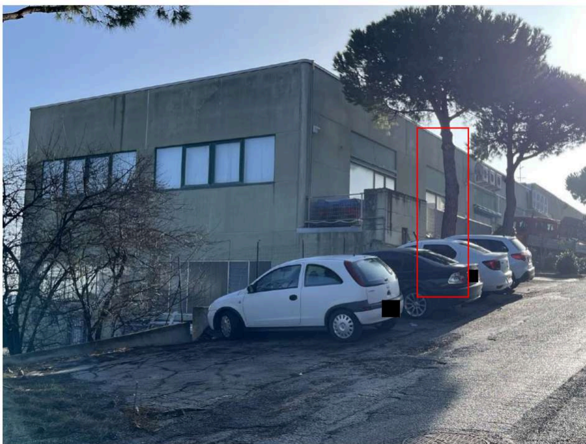
FOTO N. 4 – LATO SINISTRO E PROSPETTO
