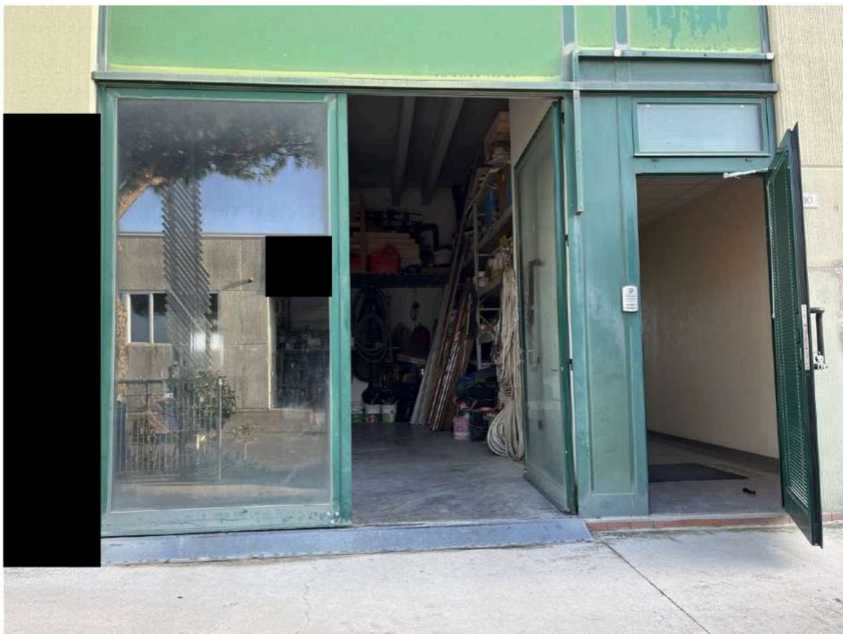
FOTO N. 6 – VISTA INGRESSO IMMOBILE
