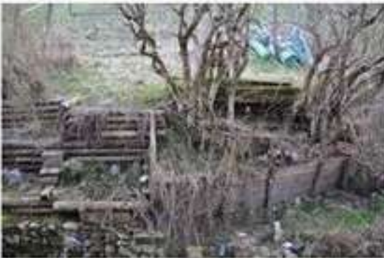
Foto 21 - L'area scoperta sul retro
