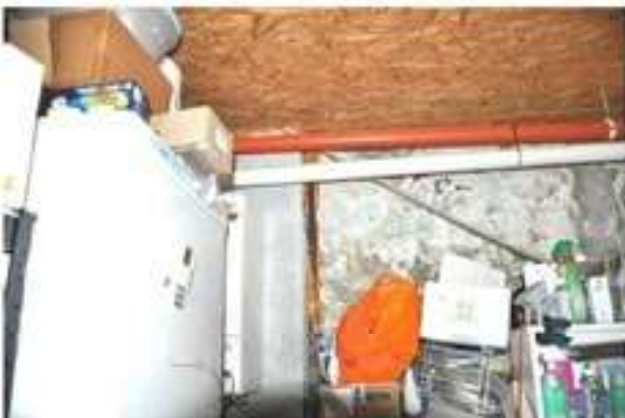
Foto 39 – il locale deposito
