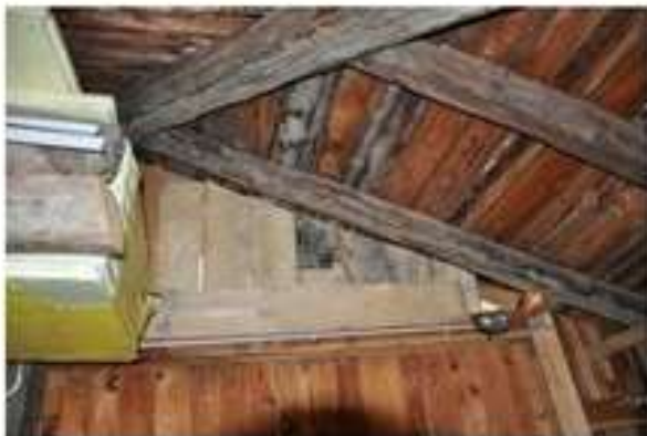
Foto 89 – Il sottotetto adibito a soffitta
