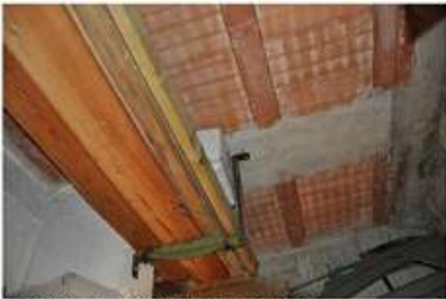
Foto 37 – Il soffitto della cantina
