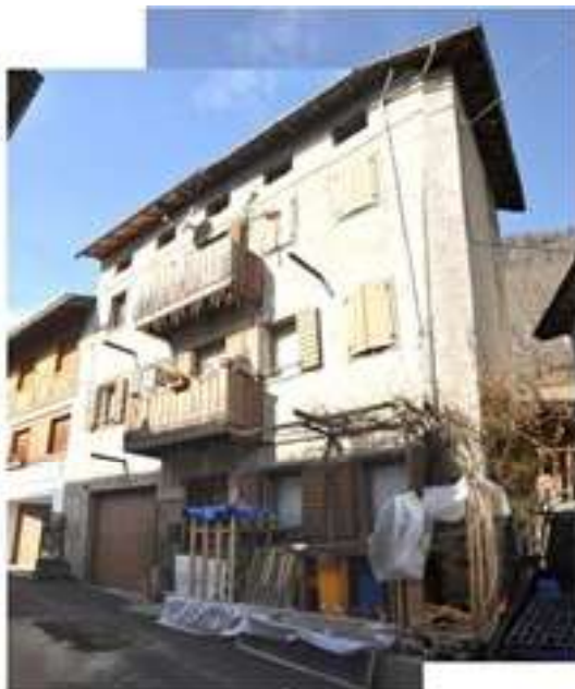
Foto 2 - Vista dalla strada
