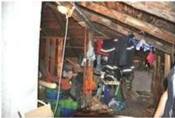
Foto 87 – 88 – Il sottotetto adibito a soffitta
