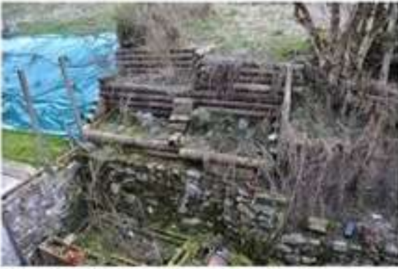
Foto 17 - L'area scoperta sul retro
