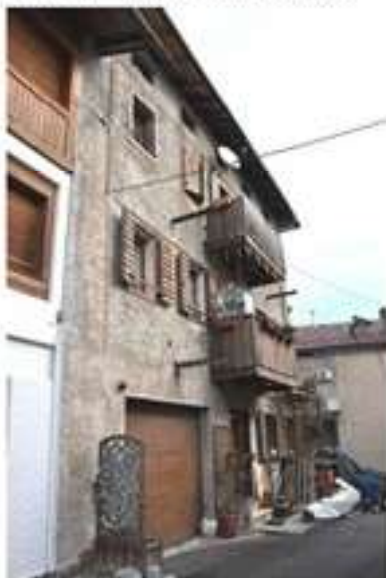
Foto 3 - vista dalla strada
