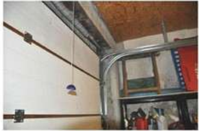
Foto 34 – Dettaglio del portone del garage
