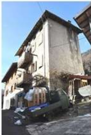
Foto 1 - Vista dalla strada
