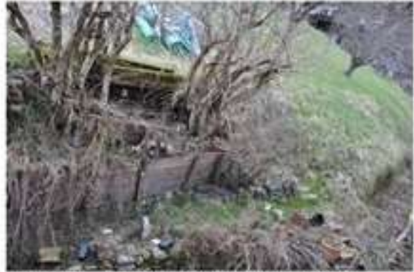
Foto 20 - L'area scoperta sul retro
