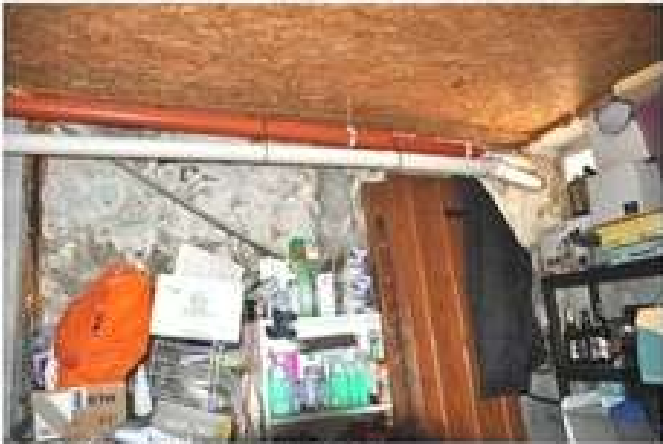
Foto 40 – il locale deposito
