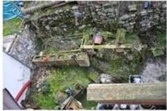
Foto 18 - L'area scoperta sul retro
