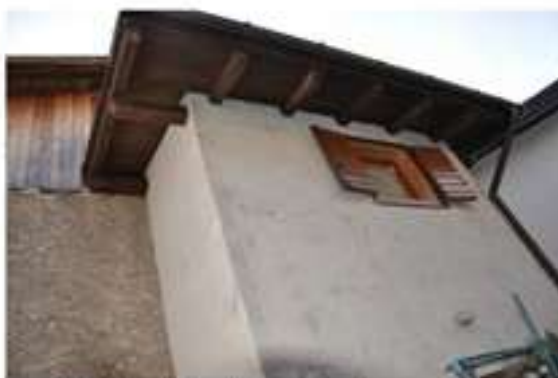
Foto 6 - Il volume aggiunto sul retro
