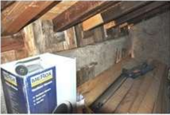
Foto 85 – 86 – Il sottotetto adibito a soffitta
