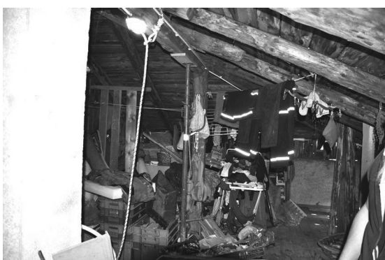
Foto 87 – 88 – Il sottotetto adibito a soffitta
