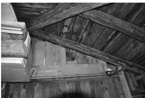
Foto 89 – Il sottotetto adibito a soffitta
