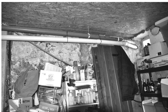
Foto 40 – il locale deposito
