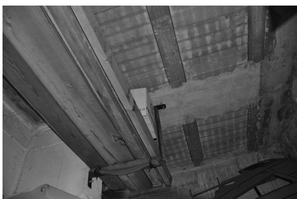
Foto 37 – Il soffitto della cantina
