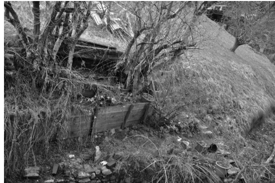
Foto 20 – L'area scoperta sul retro
