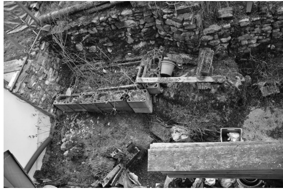
Foto 18 – L'area scoperta sul retro
