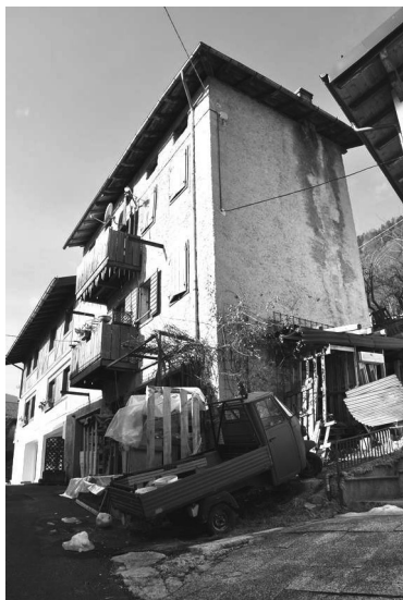
Foto 1 - Vista dalla strada
