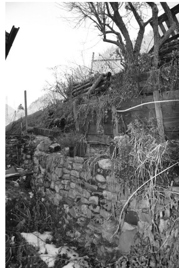
Foto 22 – L'area scoperta sul retro
