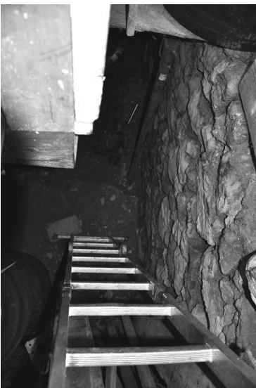
Foto 23 – L'accesso con scala a pioli
