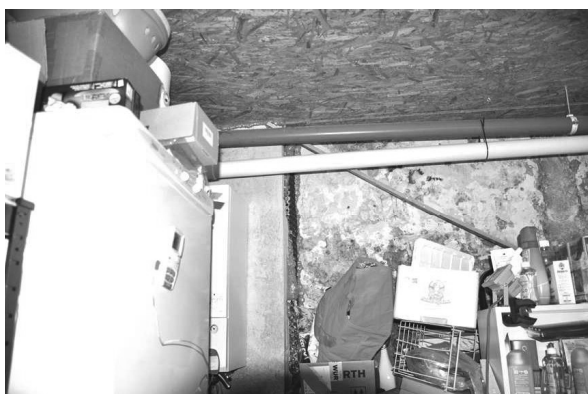
Foto 39 – il locale deposito
