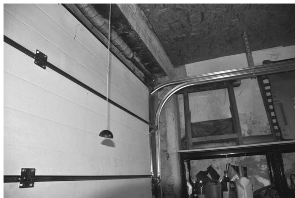
Foto 34 – Dettaglio del portone del garage
