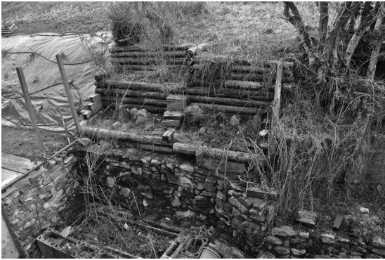
Foto 17 – L'area scoperta sul retro
