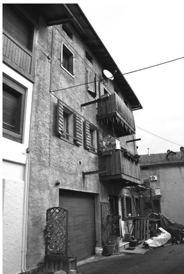
Foto 3 – vista dalla strada
