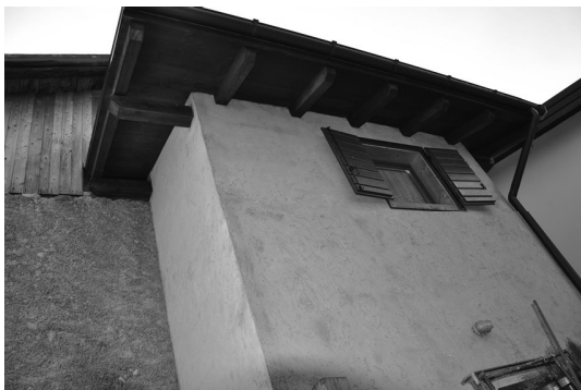
Foto 6 – Il volume aggiunto sul retro
