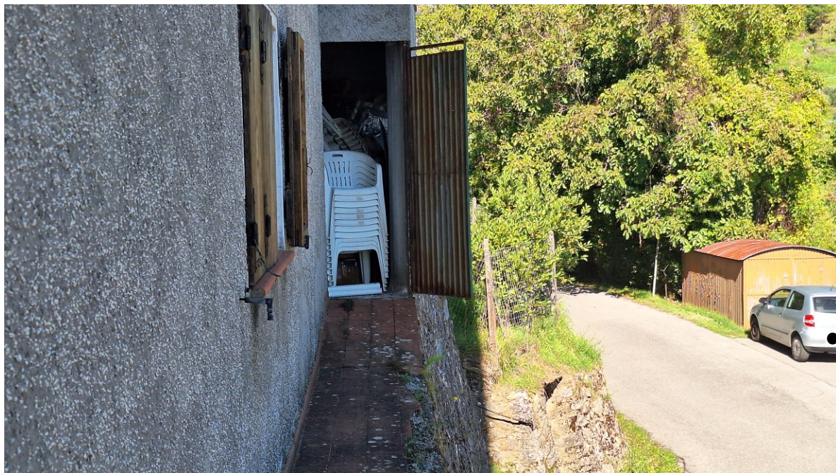
Accesso esterno al ripostiglio
