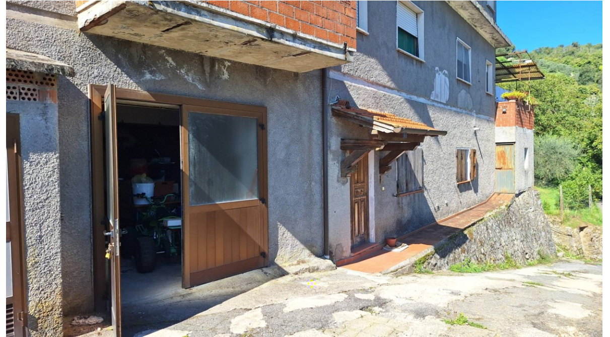
Accesso a piano seminterrato
