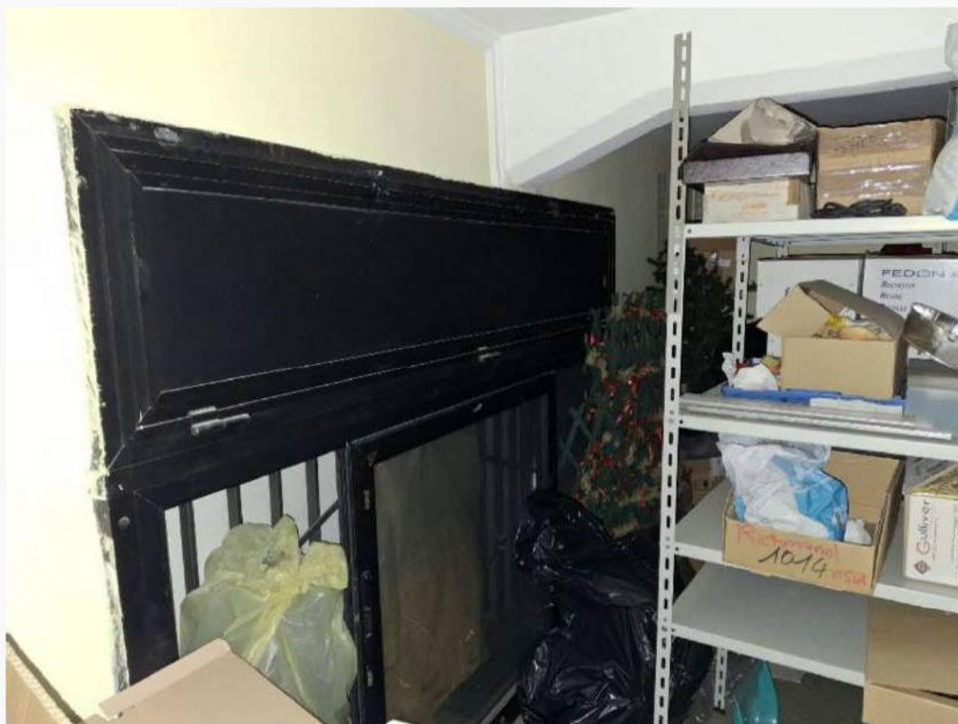
Infisso sovrastante la porta d'ingresso al locale
