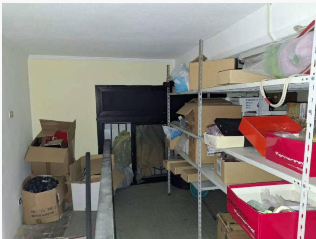
Infisso sovrastante la porta d'ingresso al locale
