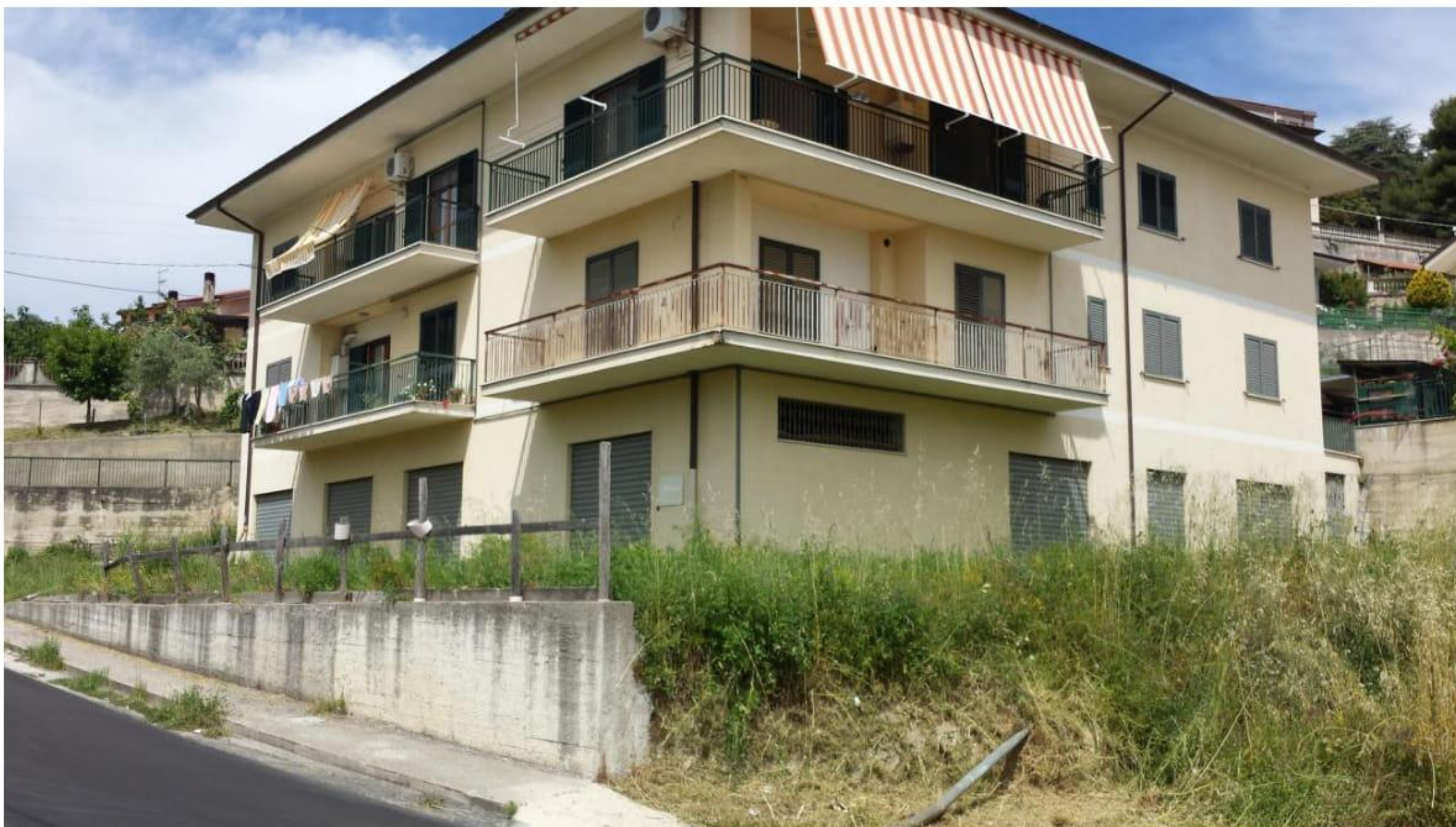
FOTO n.7 – Foglio 12 Part. 224 Sub. 6,7,8
