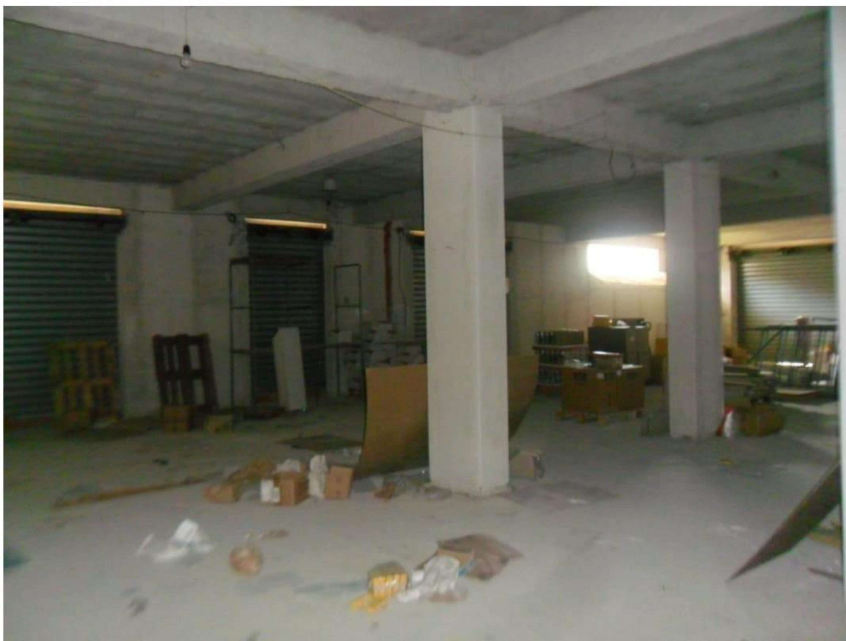
FOTO n.8 – Foglio 12 Part. 224 Sub. 6 -7
