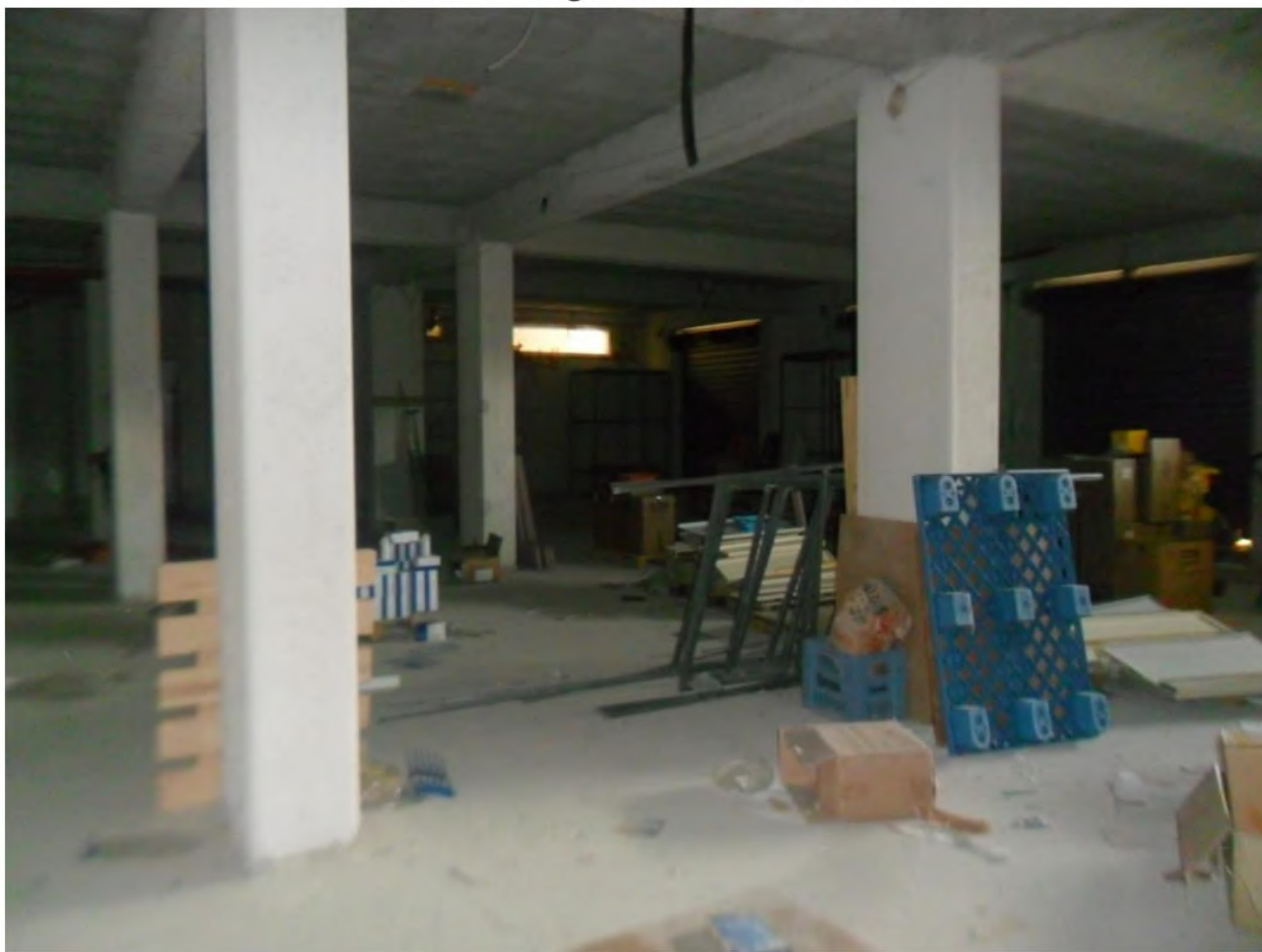
FOTO n.10 – Foglio 12 Part. 224 Sub. 6 -7
