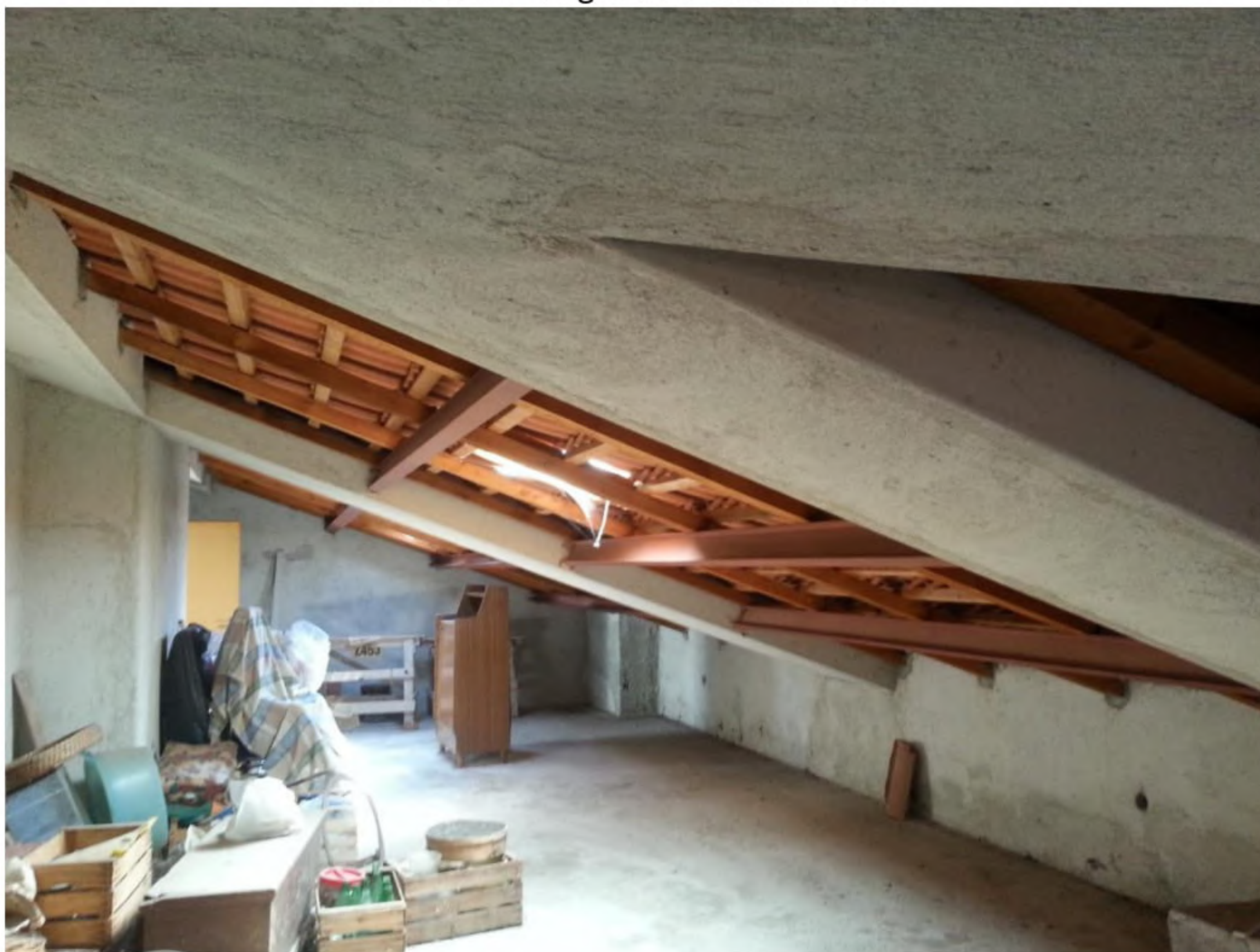
FOTO n.15 – Foglio 12 Part. 224 Sub. 5
