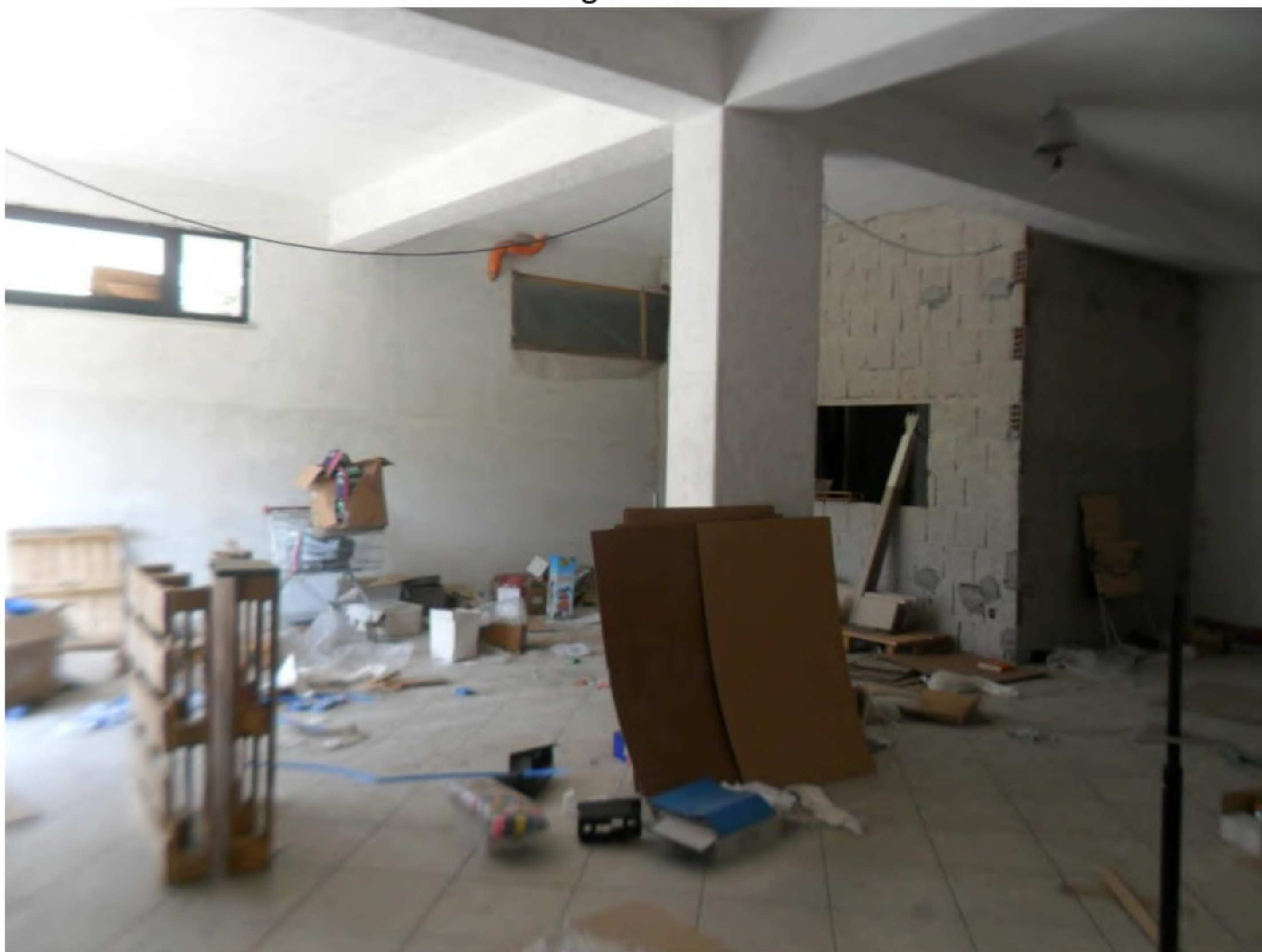
FOTO n.11 – Foglio 12 Part. 224 Sub. 8
