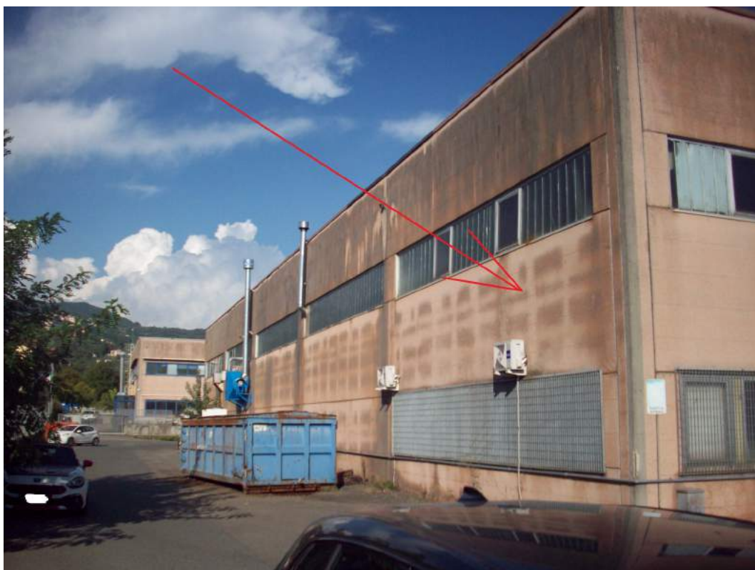
Foto n. 5 – vista lato nord-ovest capannone
