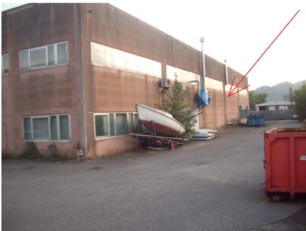
Foto n. 6 – vista lato nord-ovest capannone
