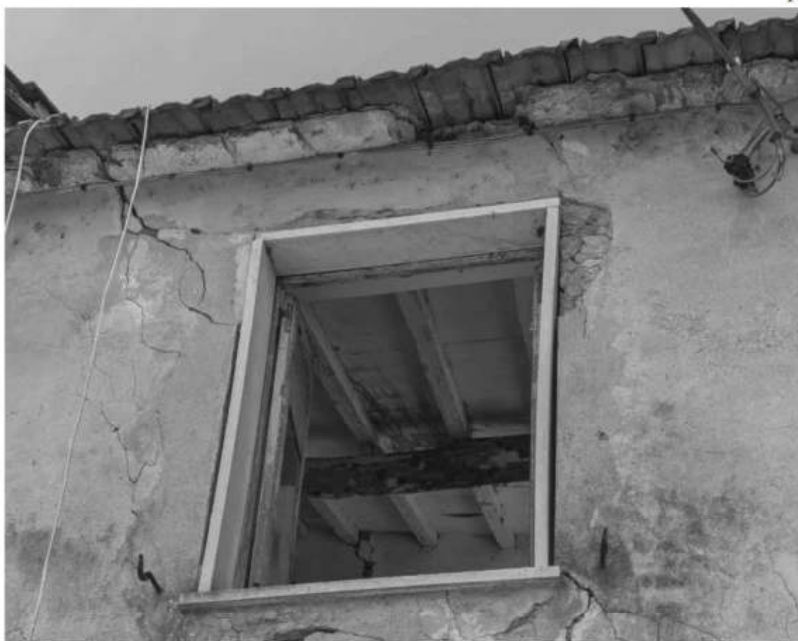
Particolare copertura visto dalla corte esterna
