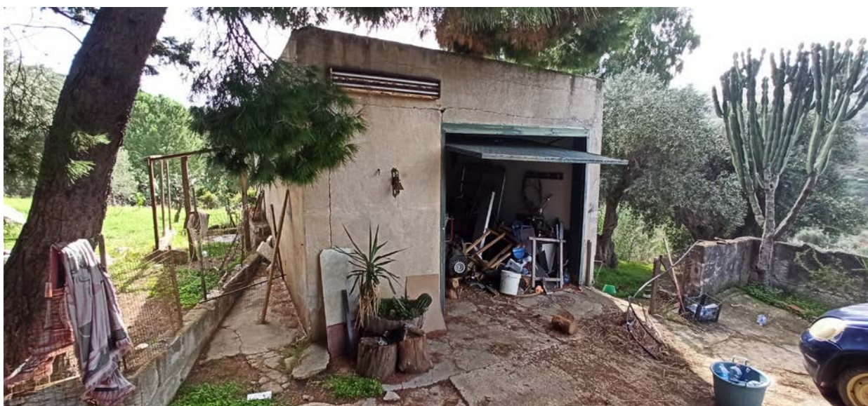
Foto n.18 – Locale di sgombero/magazzino
