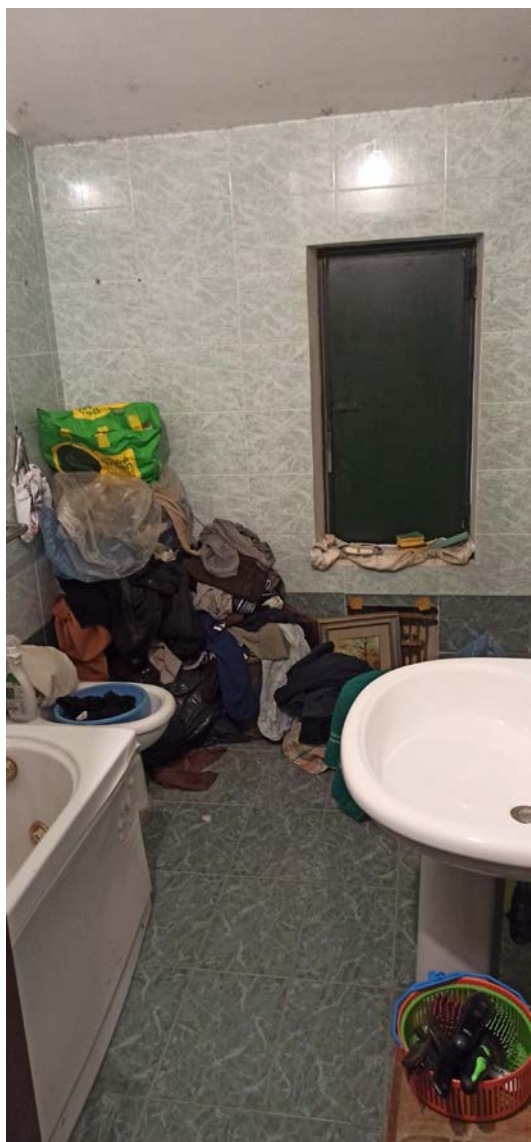
14 – Piano 1° - Vano w.c.
