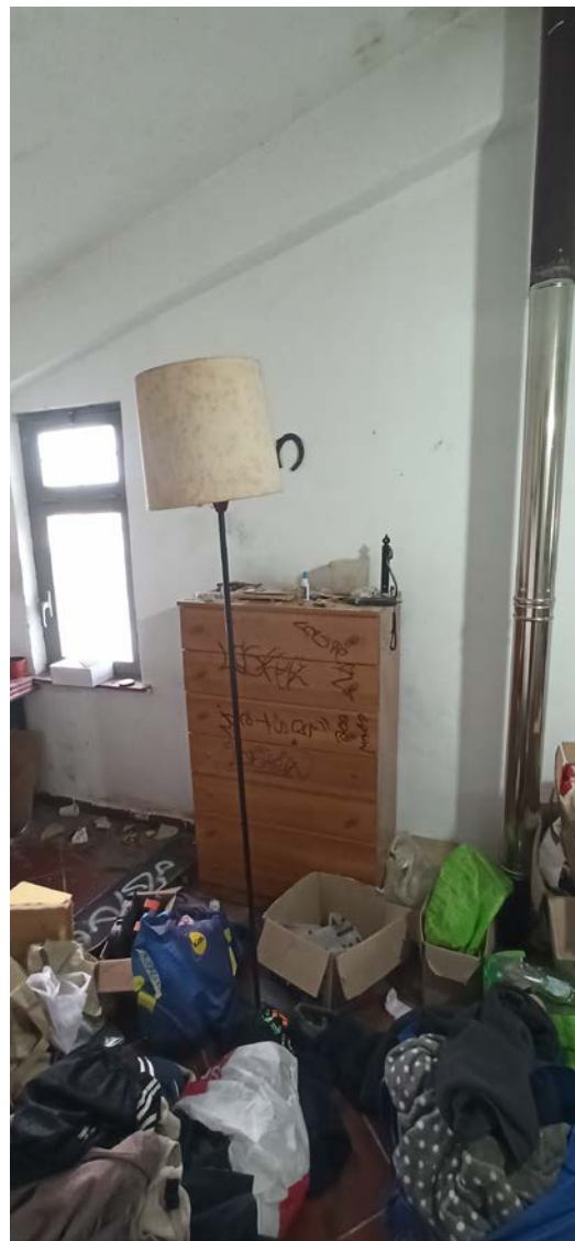
Foto n.17 – Piano 1 - Zona Terrazzo coperto
