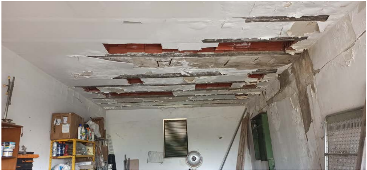
Foto n.19 – Locale di sgombero/magazzino
